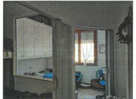
FOTO 54 - PIANO PRIMO CAMERA CON SUDDIVISIONE NON CONFORME
