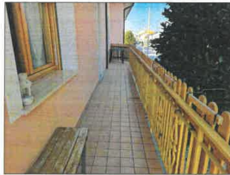
FOTO 29 - BALCONE SUL FRONTE PRINCIPALE
