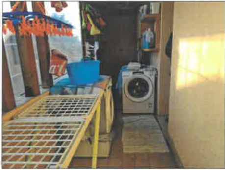
FOTO 49 - PIANO PRIMO RIPOSTIGLIO LAVANDERIA VERANDA NON CONFORME
