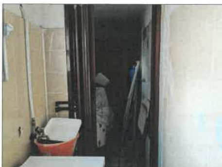
FOTO 34 - VANI NEL FABBRICATO STACCATO A SERVIZI
