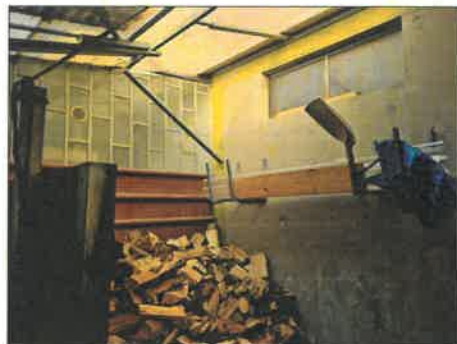
FOTO 32 - AUTORIMESSA A PIANO TERRA
