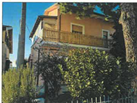
FOTO 08 - PROSPETTO LATERALE E VISTA VERANDA NON CONFORME
