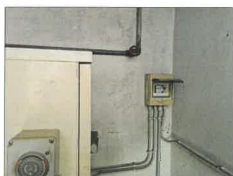
FOTO 72 - CALDAIA PIANO TERRA
