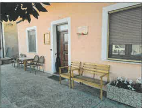
FOTO 22 - INGRESSO A PIANO TERRA
