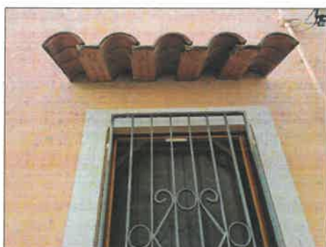
FOTO 65 - FINESTRA A PIANO TERRA CON GRATA ANTI-INTRUSIONE
