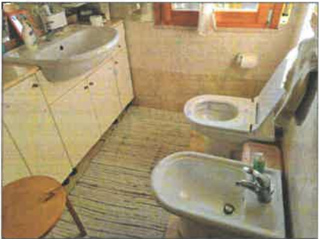
FOTO 52 - PIANO PRIMO BAGNO PRINCIPALE
