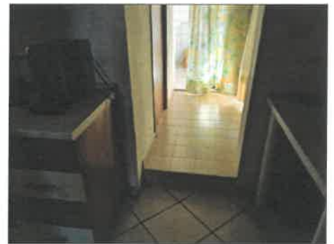
FOTO 39 - PIANO TERRA VANO W.C.
