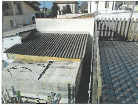
FOTO 26 - TAMPONAMENTI TETTOIE A PIANO TERRA NON CONFORMI
