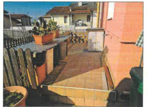
FOTO 30 - BALCONE NON CONFORME SUL FRONTE RETROSTANTE
