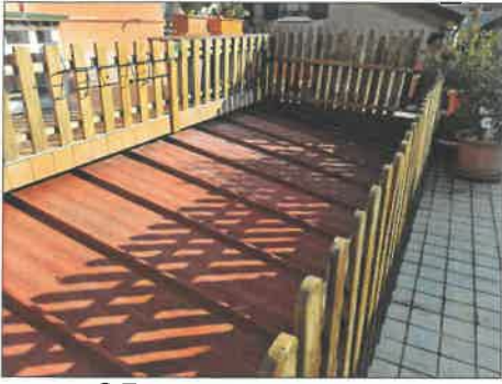
FOTO 25 - COPERTURE TETTOIE A PIANO TERRA NON CONFORMI
