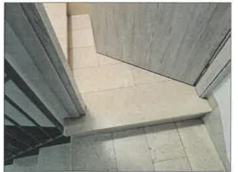
FOTO 60 - VANO SCALA DETTAGLIO INGRESSO PIANO PRIMO
