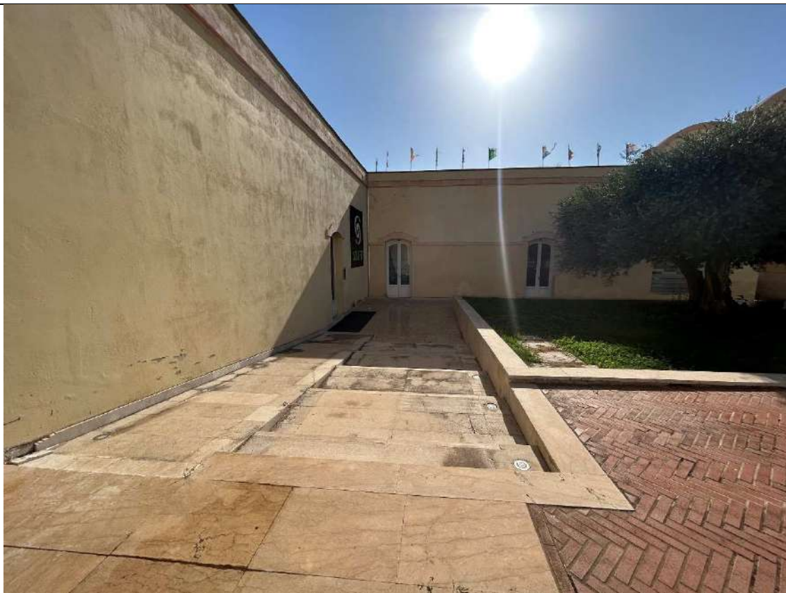
Foto n.15 – Vista dell'edificio A lato dx – Area da destinare ad aule ed, oggi, occupata dalla palestra
