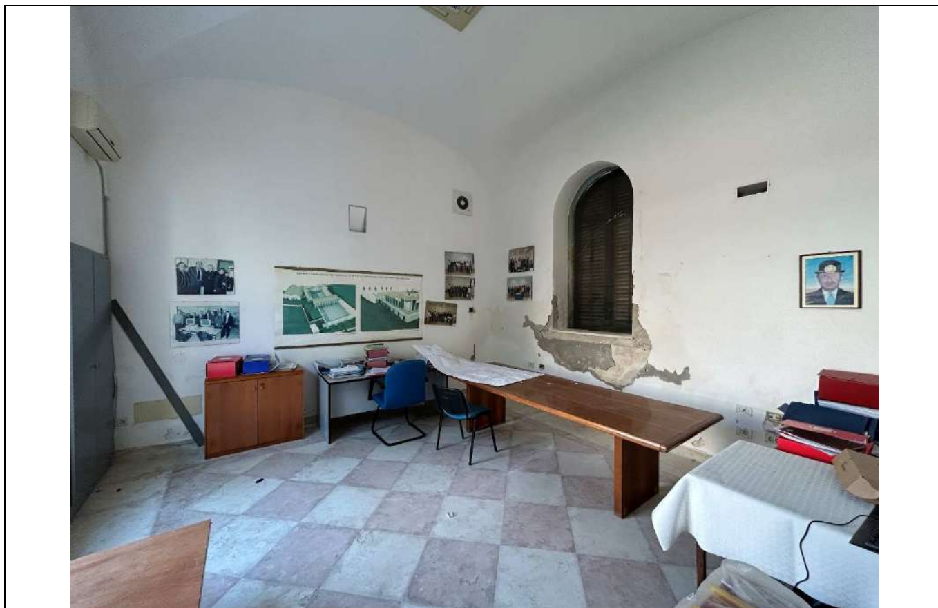
Foto n.7 – Vista dell' edificio A lato sx - stanza n.1
