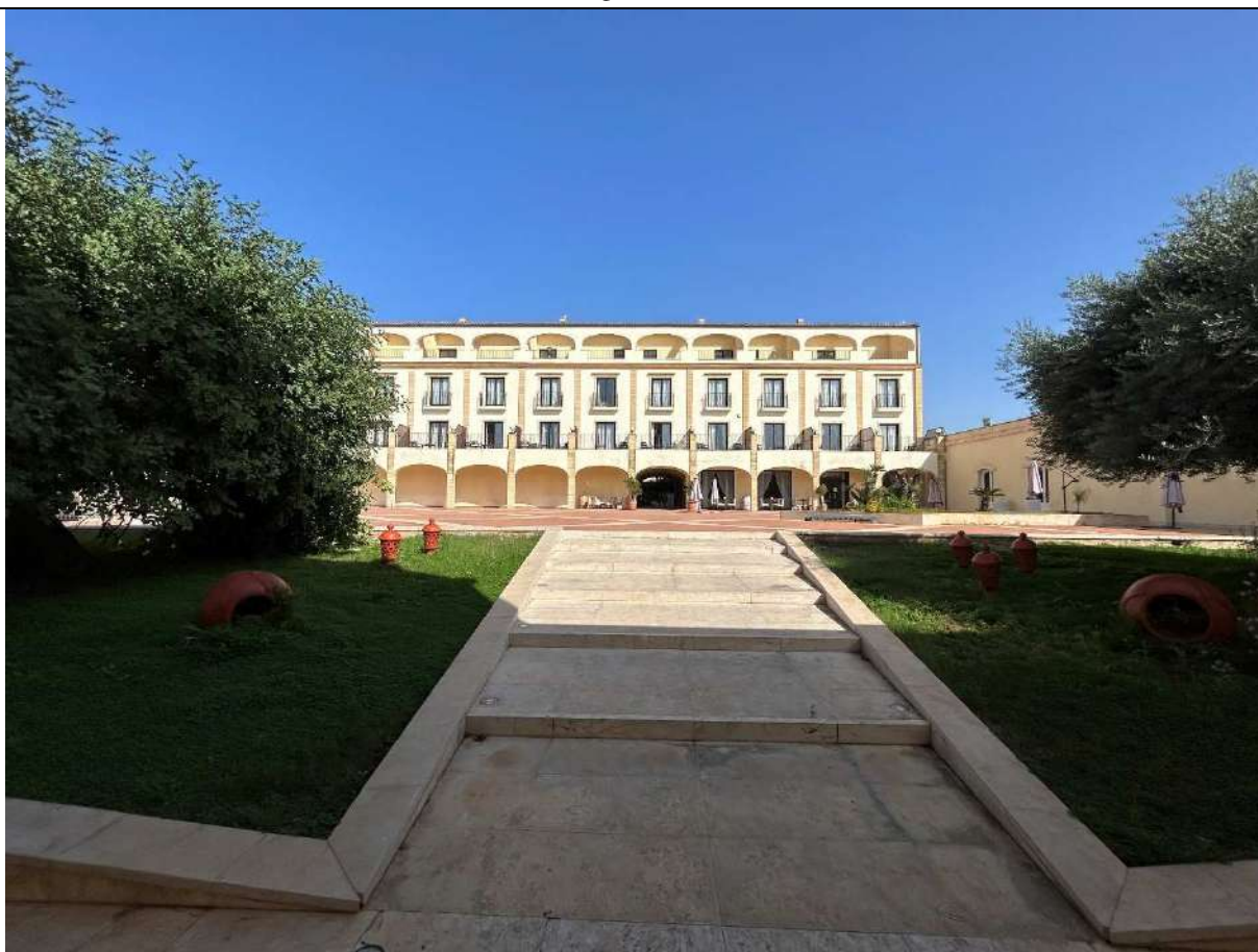
Foto n.6 – Vista della scalinata di accesso alla struttura
