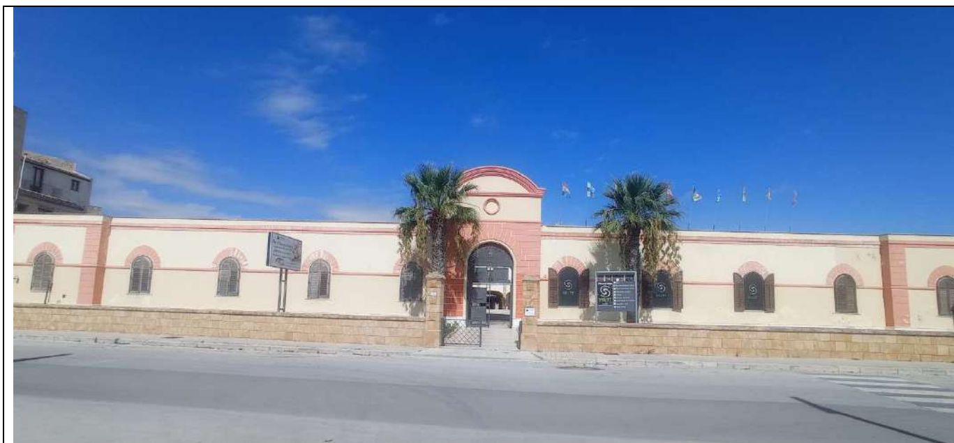
Foto n.1 – Vista frontale dell'edificio A
