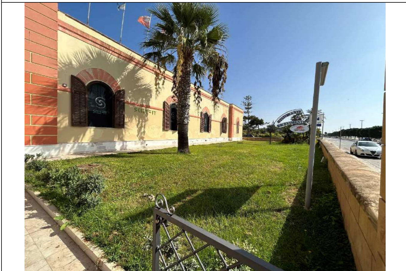
Foto n.4 - Vista dell'esterno lato dx – Zona da adibire ad aule
