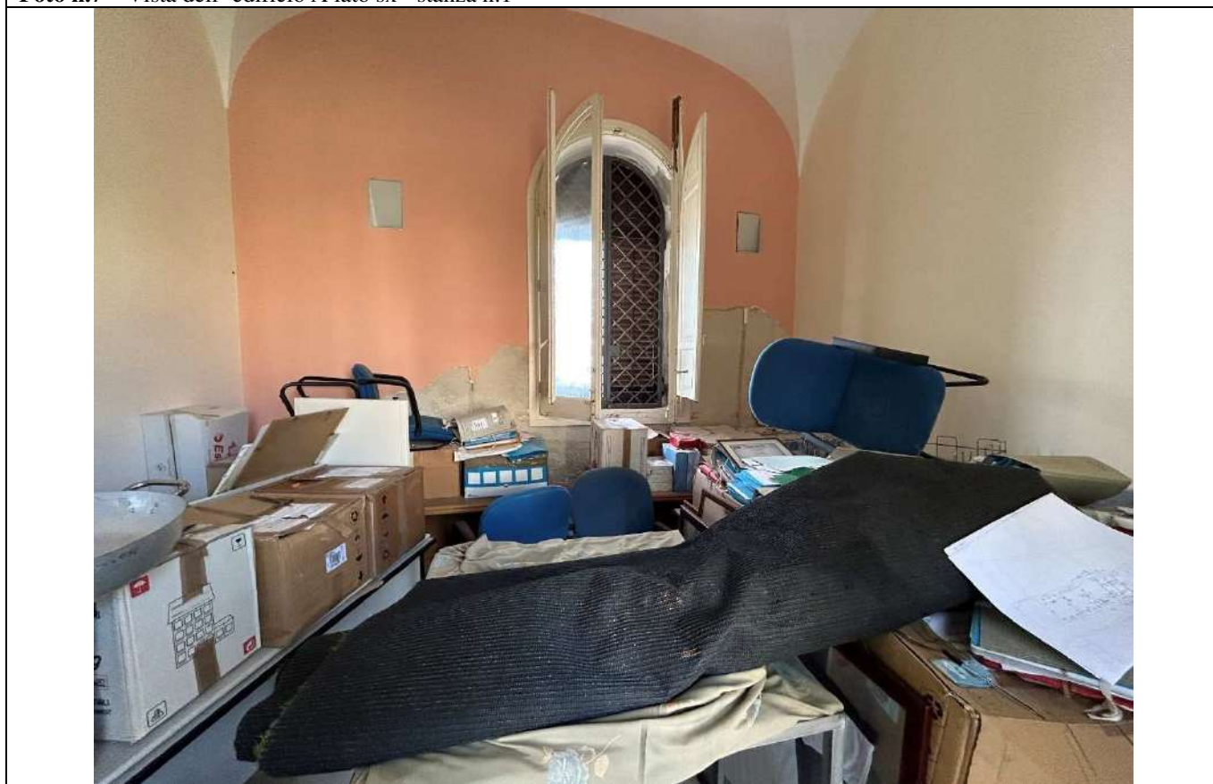
Foto n.8 – Vista dell' edificio A lato sx - stanza n.2
