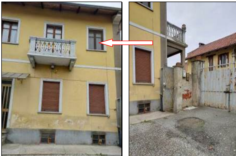
Aree cortile interno con identificazione superficie locata
