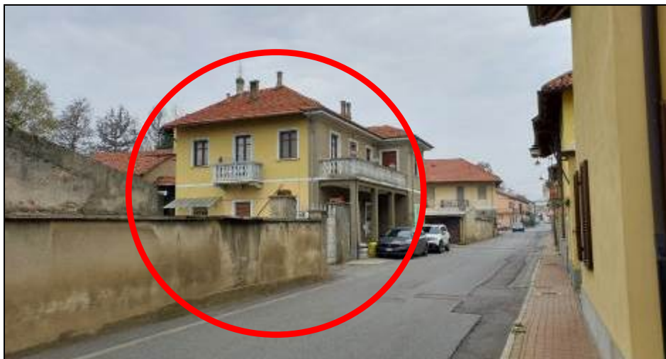
Identificazione della palazzina in Trofarello, via Umberto I n.19
