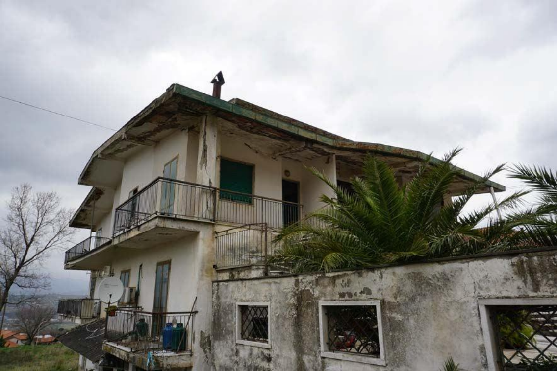
Fig.6 – Vista del fronte sud-ovest da Viale dei Pini
