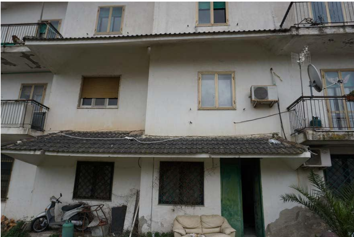
Fig.15 – Vista ingresso dell'immobile sub.7 (A10)
