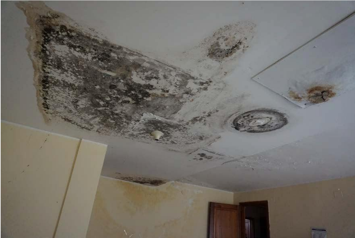
Fig.18 – Vista vano interno sub.7 (A10)
