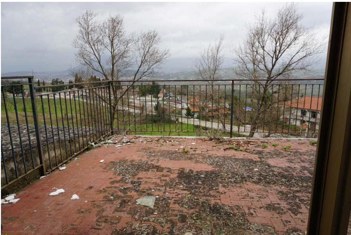
Fig.67 – Vista su terrazzo posto al secondo piano rivolto a nord dell'immobile
