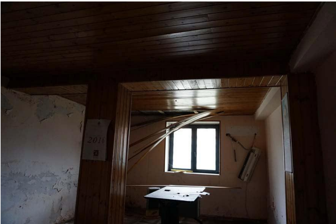
Fig.32– Vista su vano interno dell’immobile sub.9 (A10)
