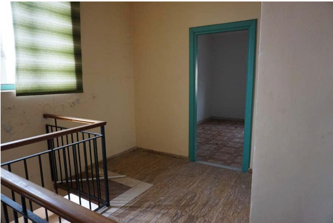
Fig.61 – Vista su pianerottolo posto al secondo piano
