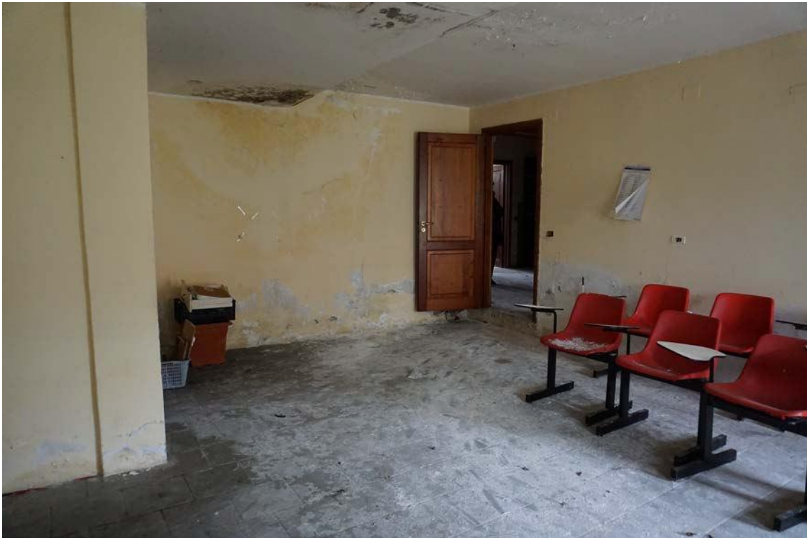
Fig.17 –Vista vano interno sub.7 (A10)
