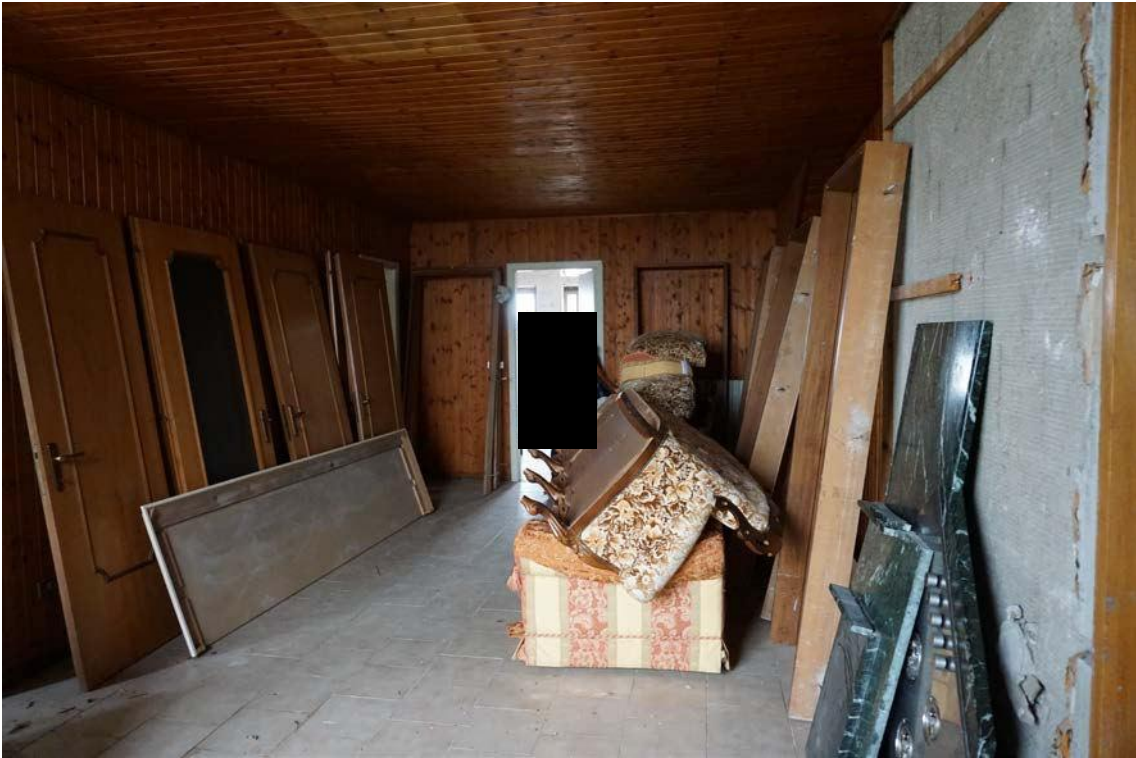
Fig.31 – Vista su vano interno dell’immobile sub.9 (A10)
