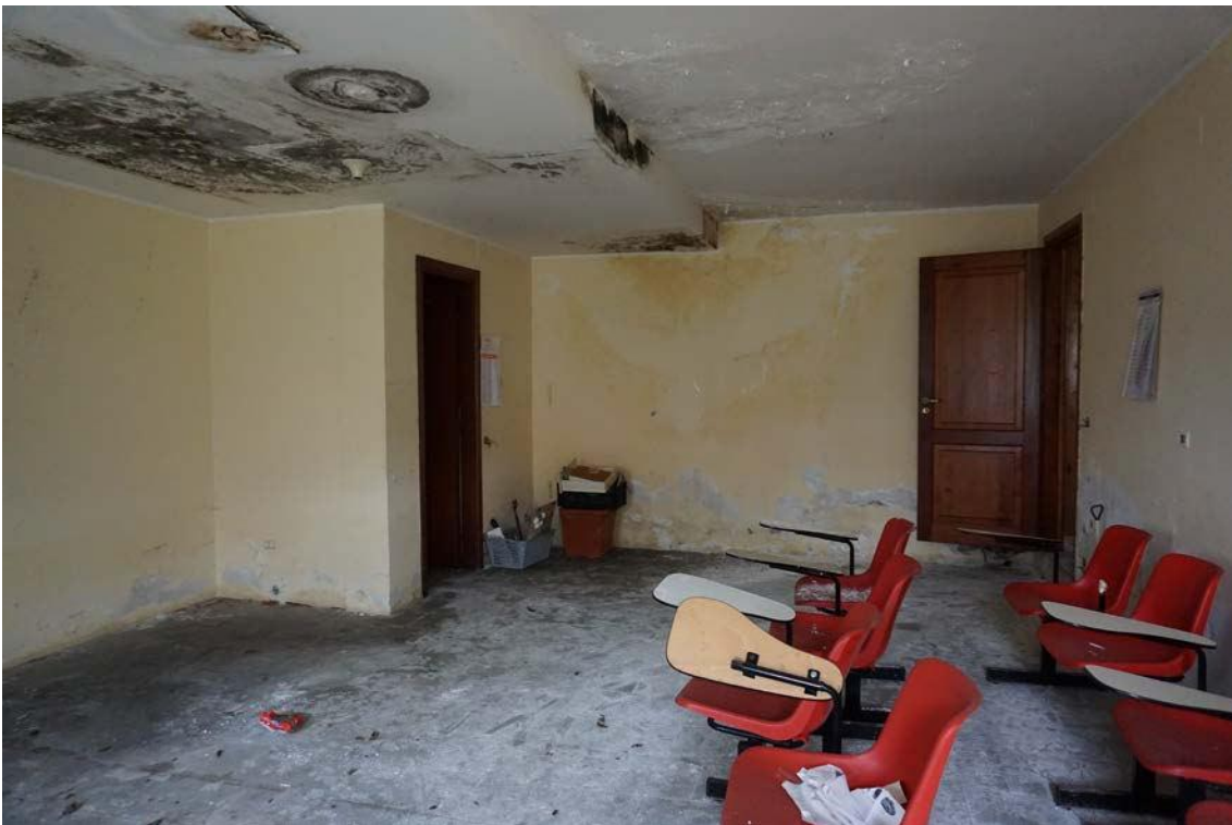
Fig.19 – Vista vano interno sub.7 (A10)
