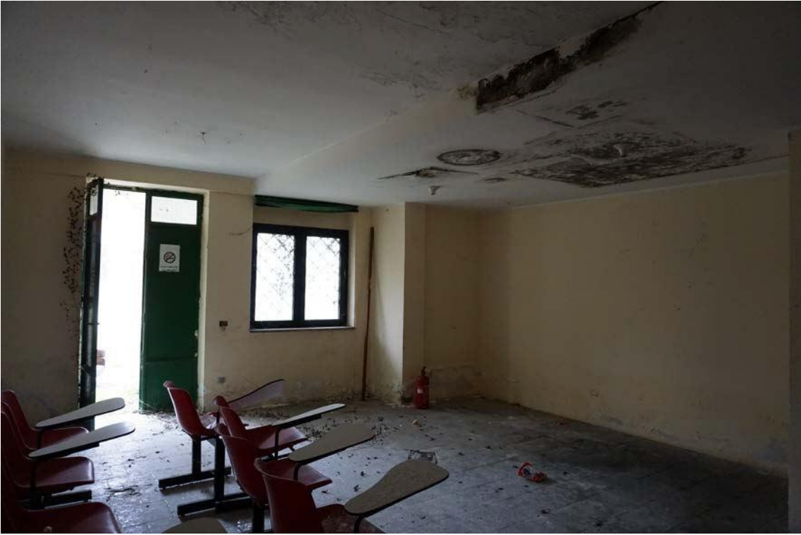
Fig.16 – Vista vano interno sub.7 (A10)
