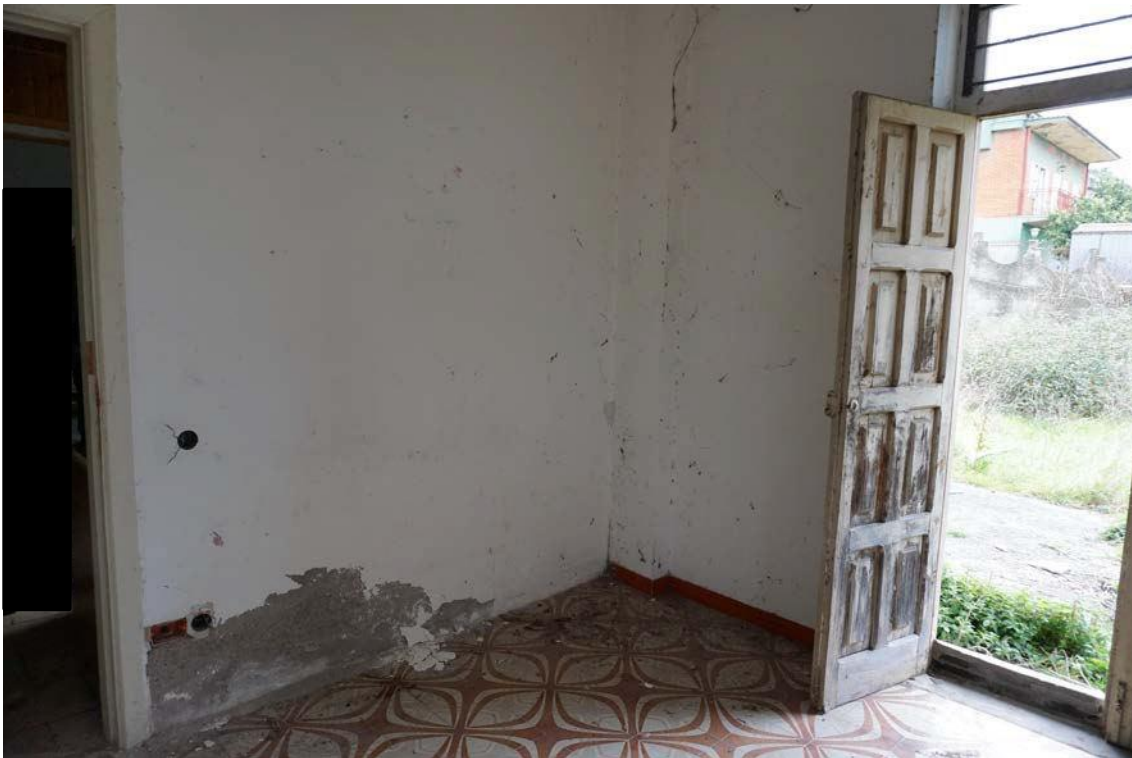
Fig.22 – Vista interna dell’ingresso del sub.9 (A10)
