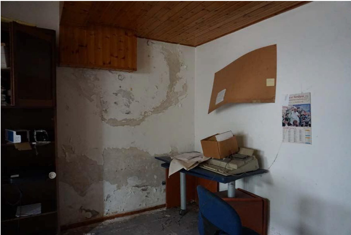
Fig.29 – Vista vano uso ufficio dell'immobile sub.9 (A10)
