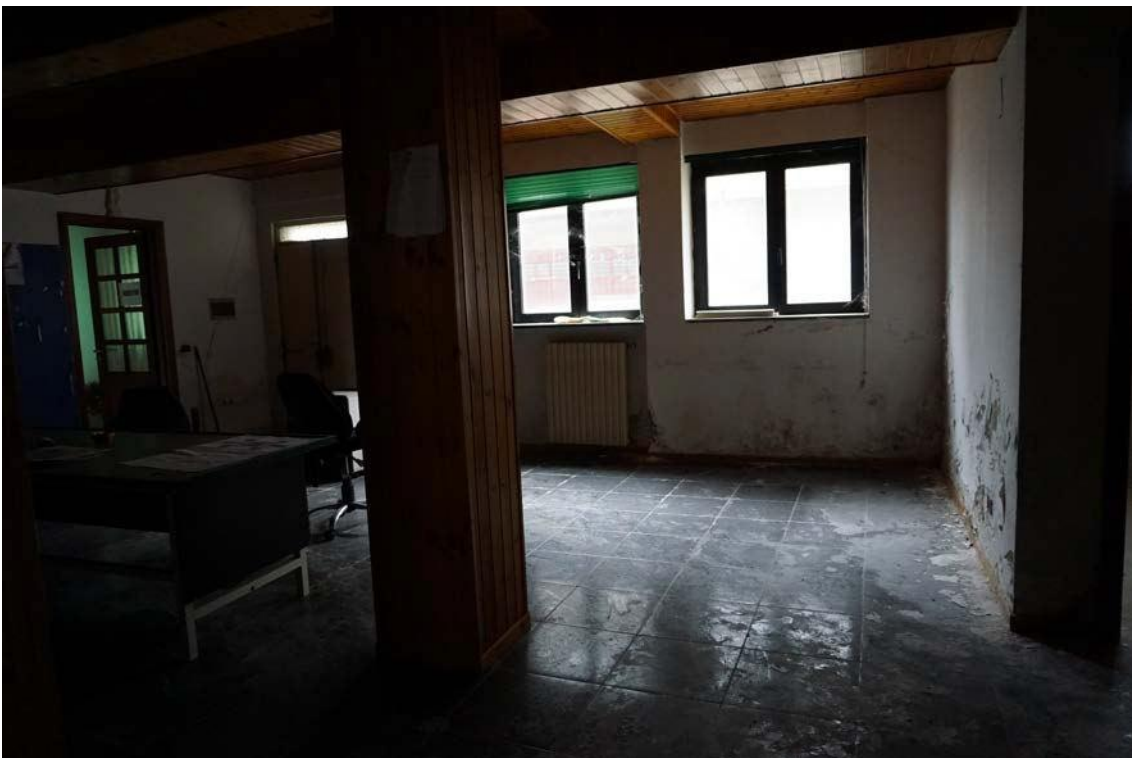
Fig.30 – Vista vano uso ufficio dell'immobile sub.9 (A10)
