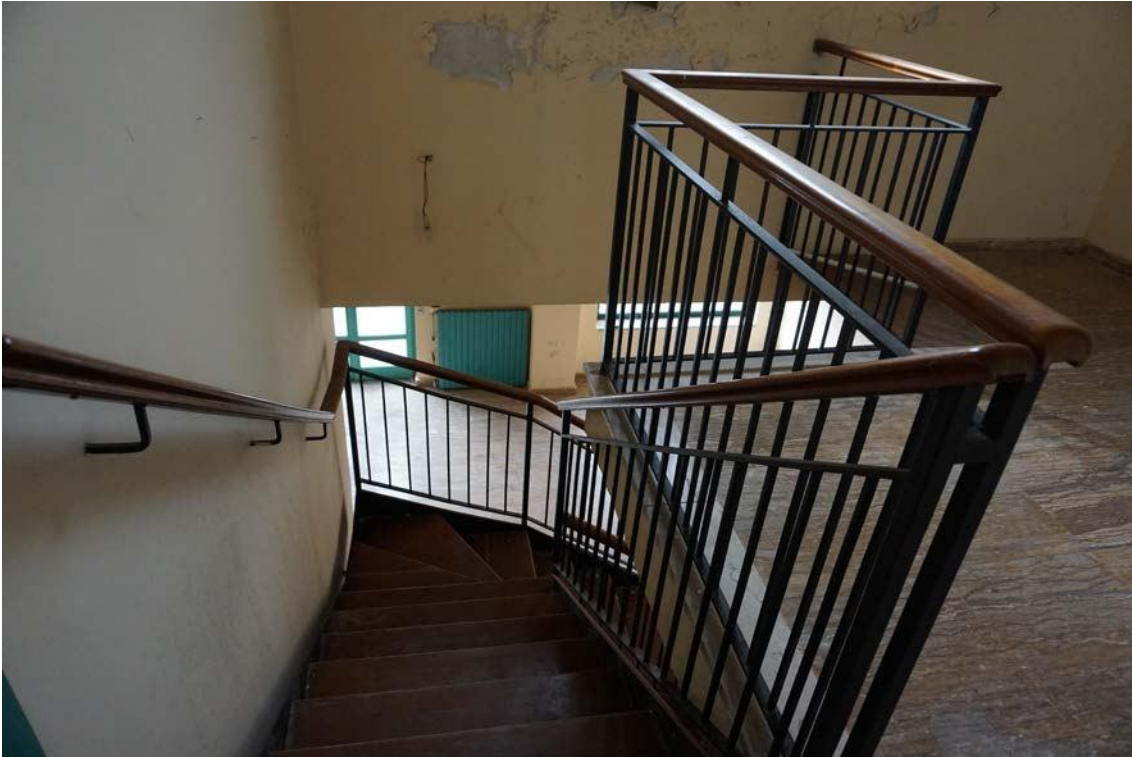
Fig.60 – Vista su scala e pianerottolo posto al secondo piano
