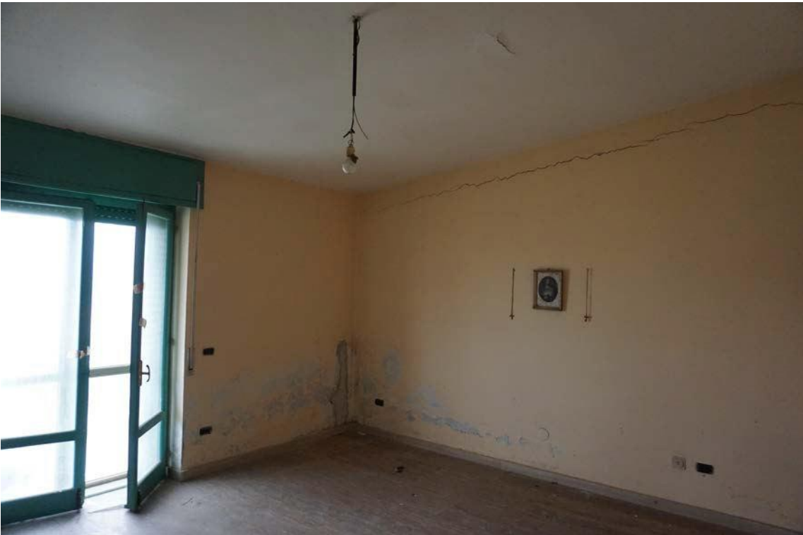
Fig.53 – Vista su vano interno dell'immobile al sub.12
