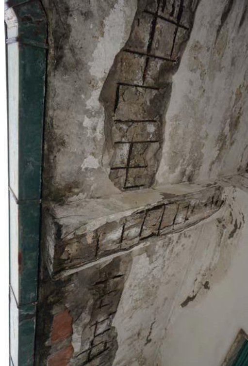
Figg.12-13 – Vista di dettaglio sul degrado delle strutture
