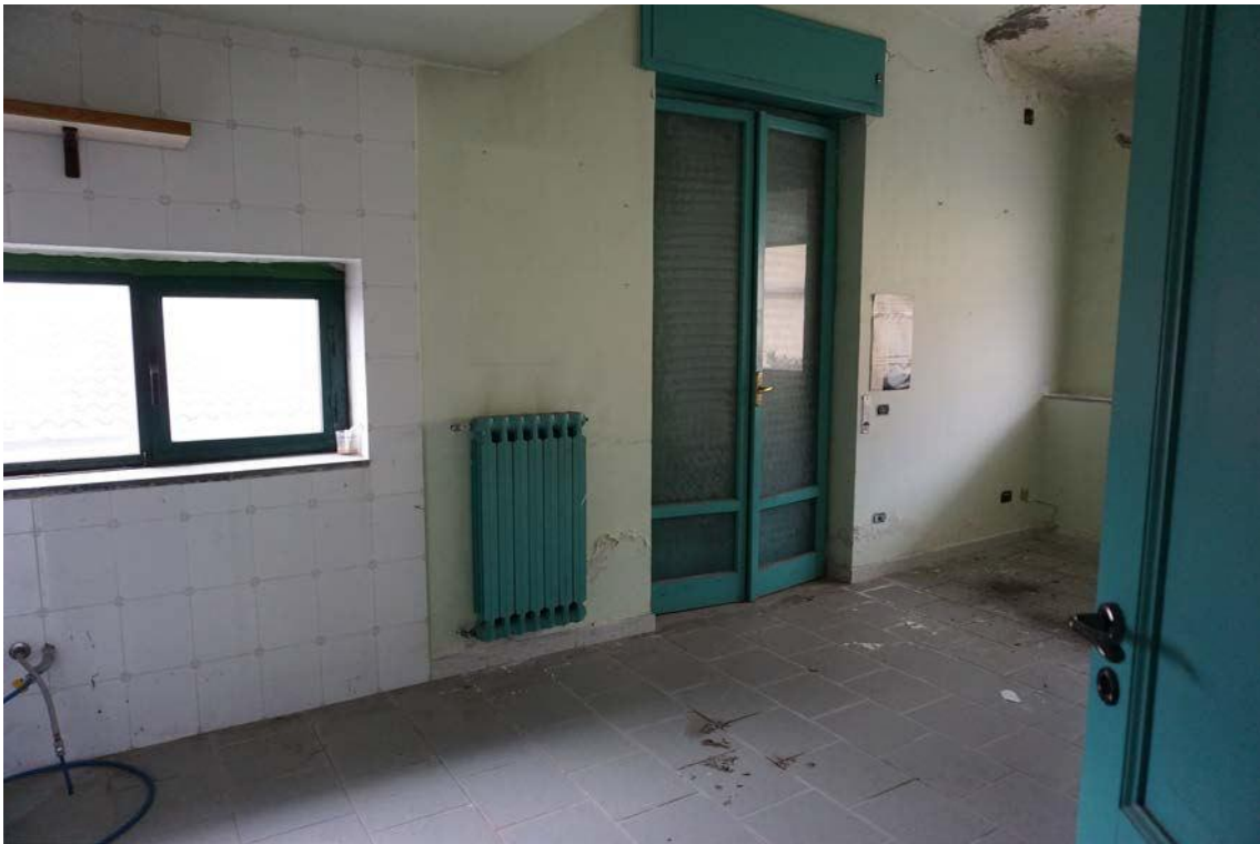
Fig.54 – Vista su vano cucina
