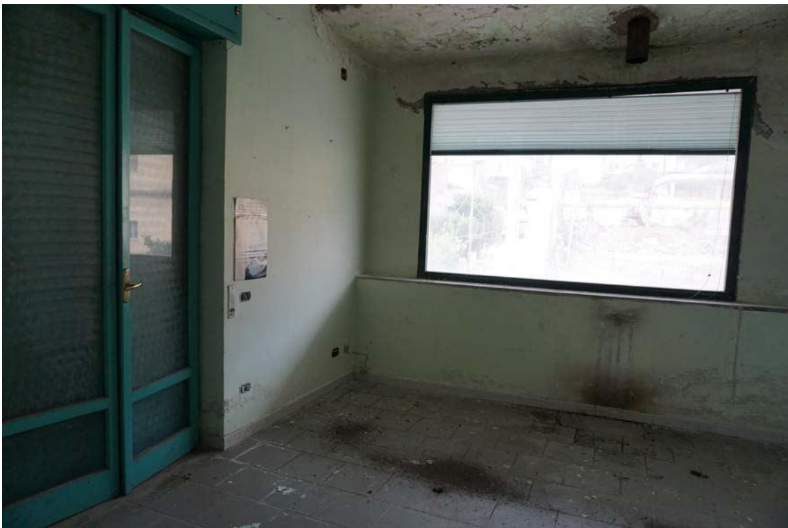
Fig.55 – Vista su vano cucina
