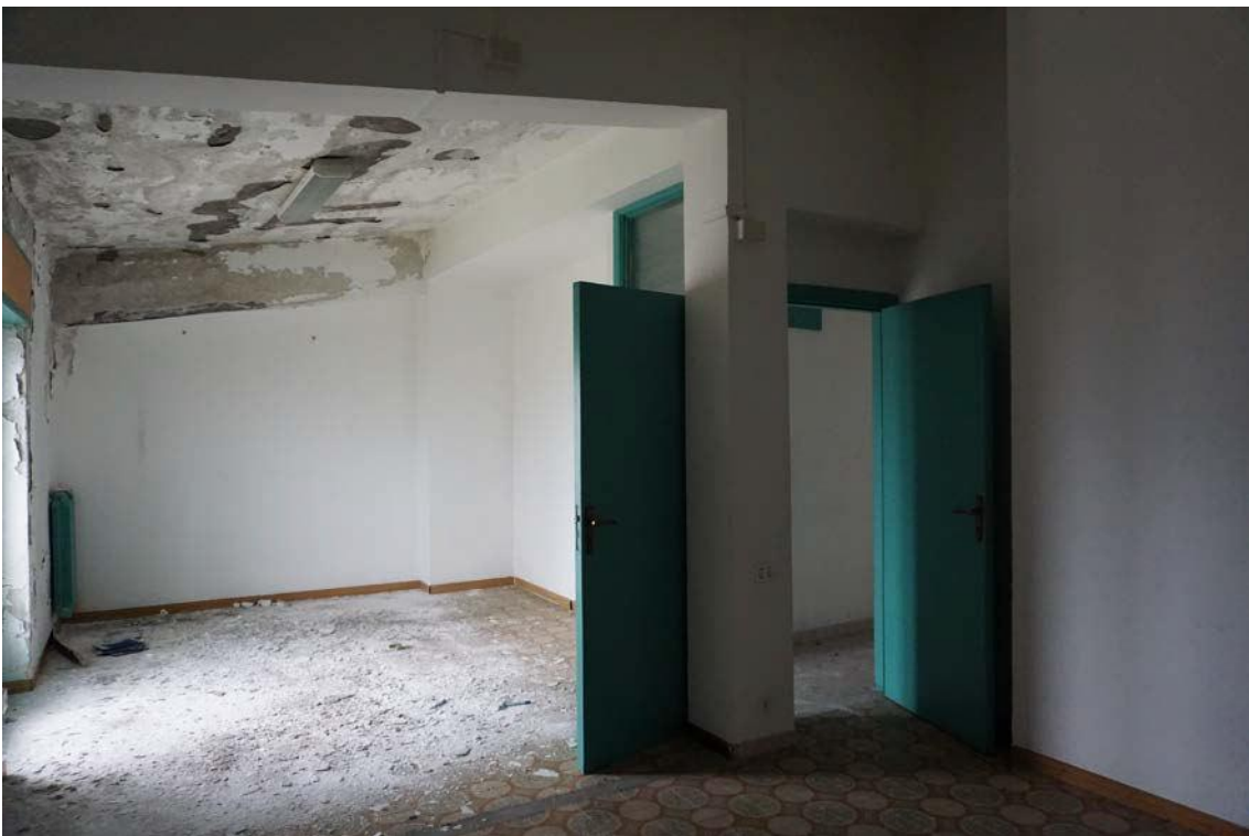
Fig.72 – Vista sala dell’immobile al sub.13 (A10)
