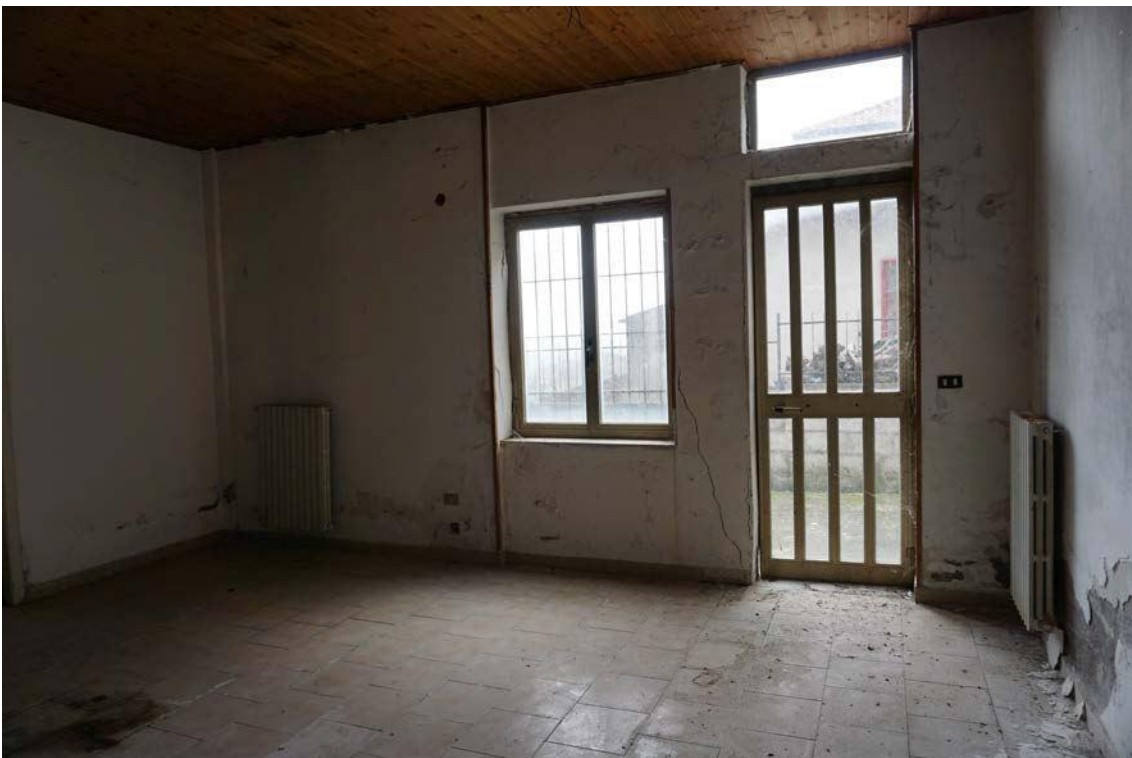
Fig.26 – Vista secondo ingresso dell’immobile sub.9 (A10)
