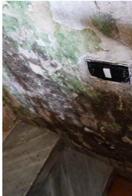
Fig.46 – Vista di dettaglio degli spazi interni del sub.11 e degrado delle superfici per infiltrazioni
