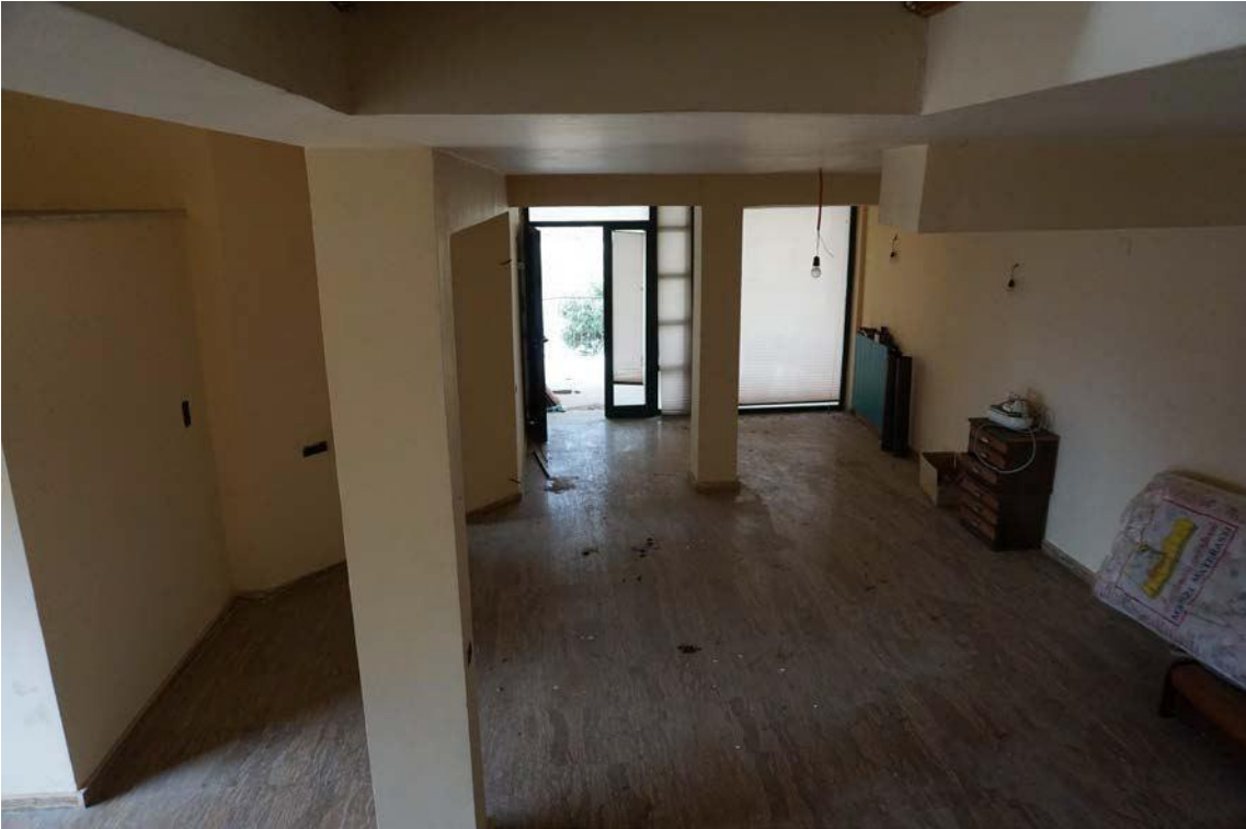
Fig.52 – Vista su vano principale
