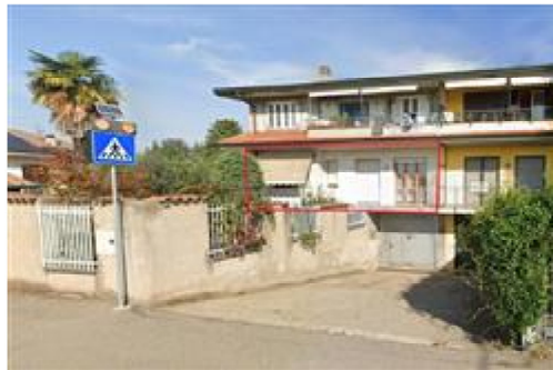
vista da via G. Verdi
