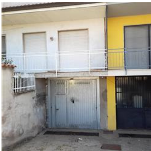
vista da via G. Verdi
