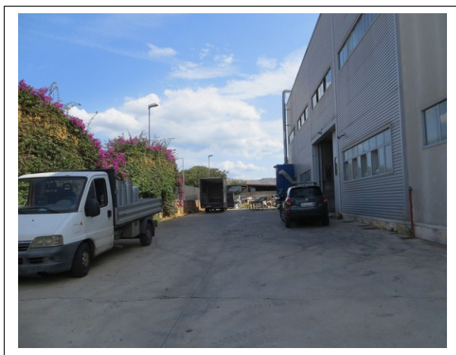
Foto 4 – Area esterna e prospetto ovest.
