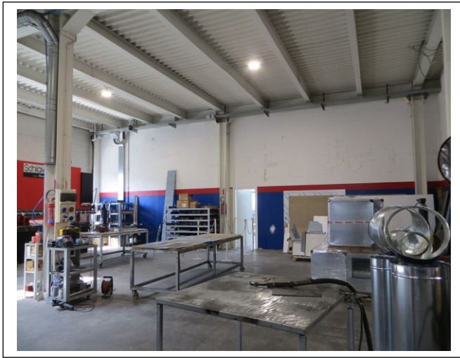
Foto 13 – Piano terra. Zona di lavorazione.
