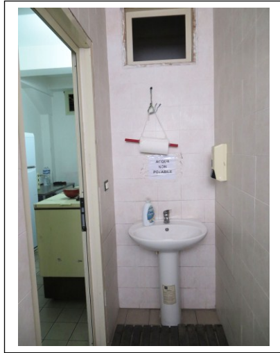
Foto 25 – Piano terra. Wc.
