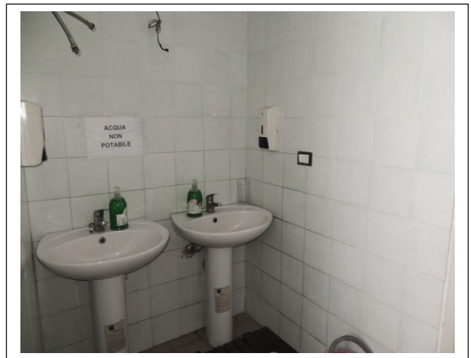
Foto 22 – Piano terra. Wc.
