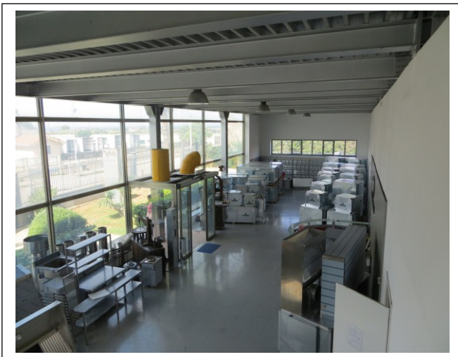
Foto 27 – Piano terra. Montacarichi.
