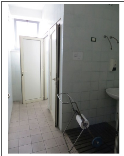
Foto 21 – Piano terra. Wc.
