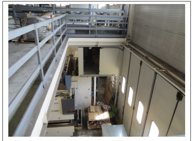
Foto 34 – Primo Piano. Affaccio verso il piano terra.
