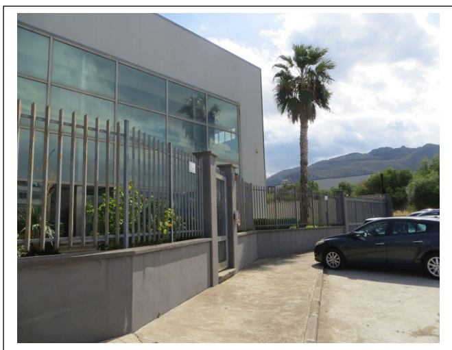
Foto 3 – Cannello pedonale e recinzione dell'area.
