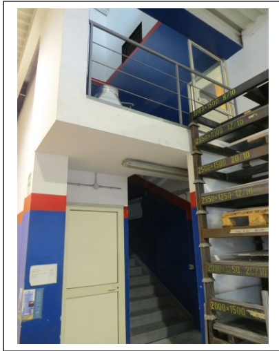
Foto 19 – Scala di servizio.
