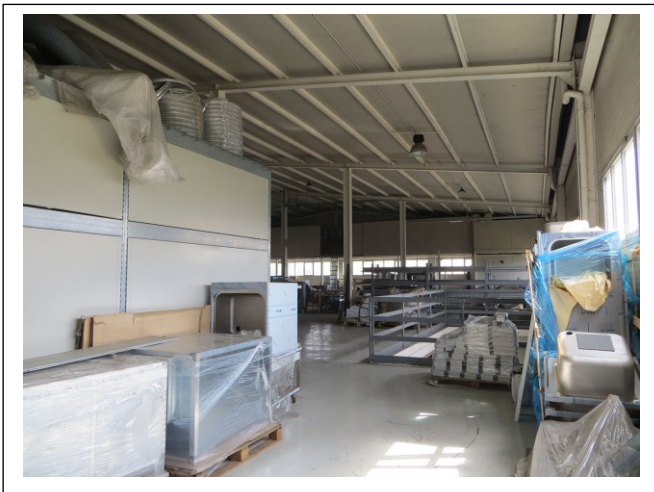
Foto 33 – Primo Piano. Zona di lavorazione.
