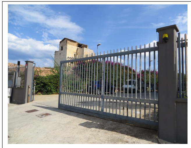
Foto 2 – Cannello carrabile elettrificato.
