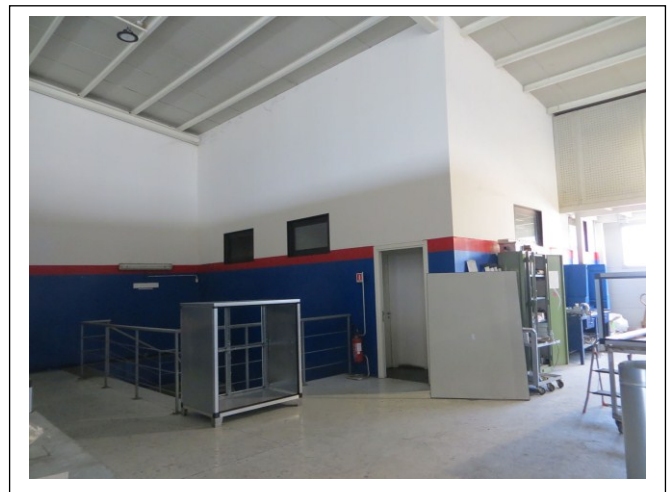
Foto 40 – Primo Piano. Zona di lavorazione.
