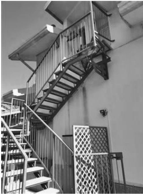
Scala esterna d'accesso al soittotetto
