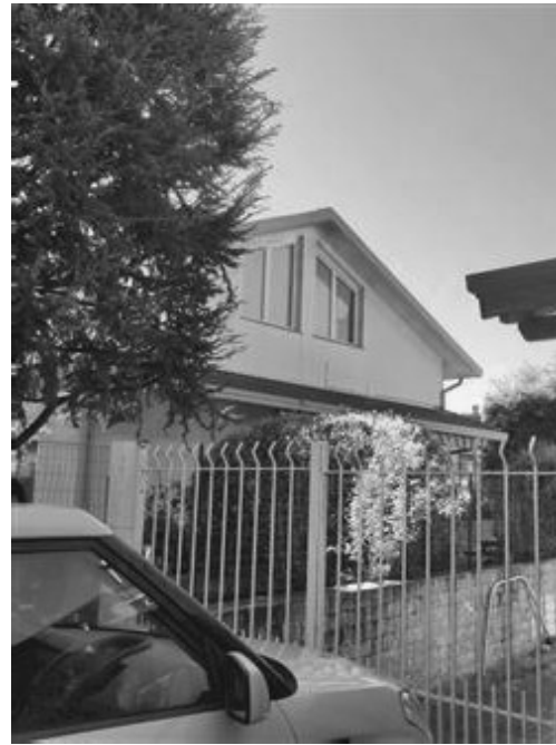
Vista esterna porzione immobiliare sottotetto
