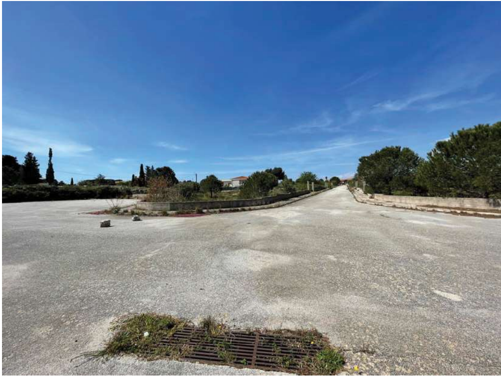
Opere di urbanizzazione interne al comparto edificatorio in cui il lotto ricade
