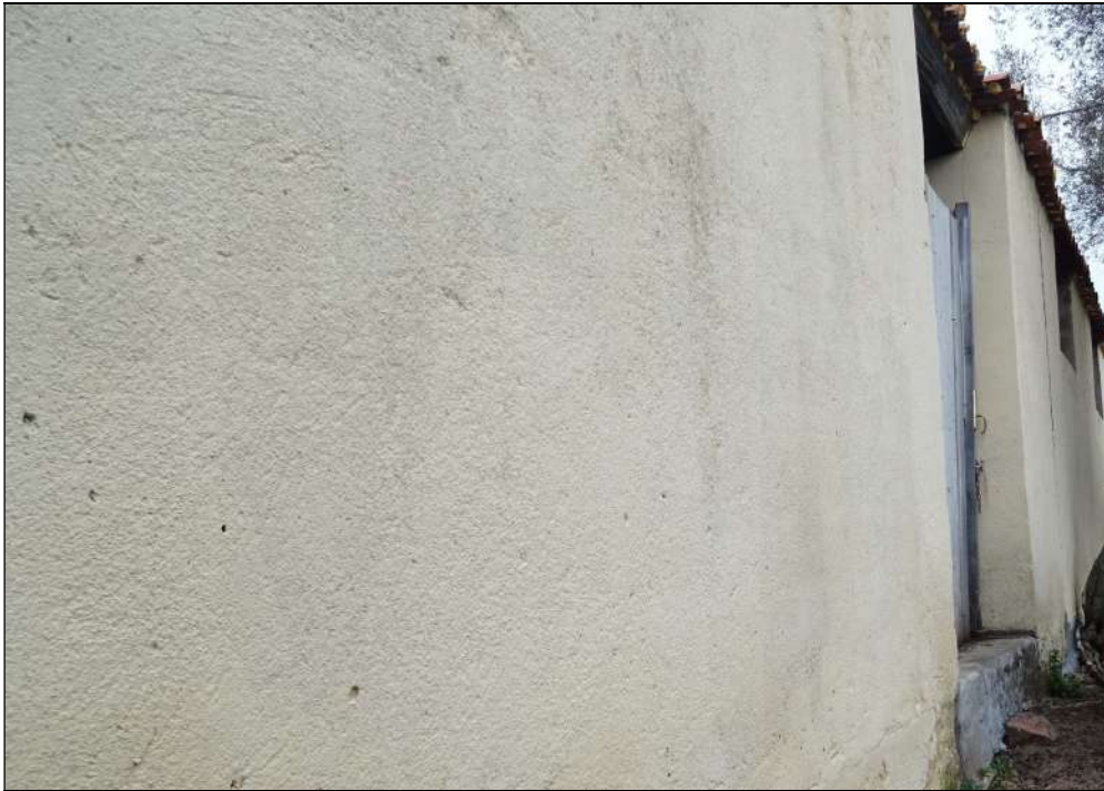
Vista facciata retro – ingresso stalla.
