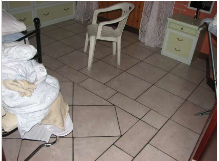
particolare pavimentazione ripostigli
