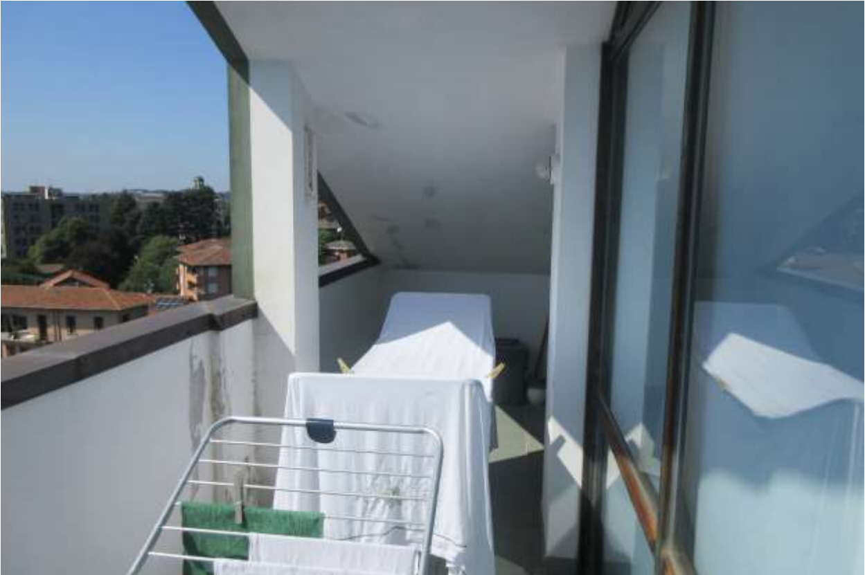
Terrazzo coperto al piano settimo
