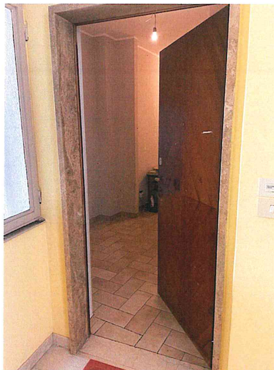
Particolare ingresso alloggio – piano secondo
