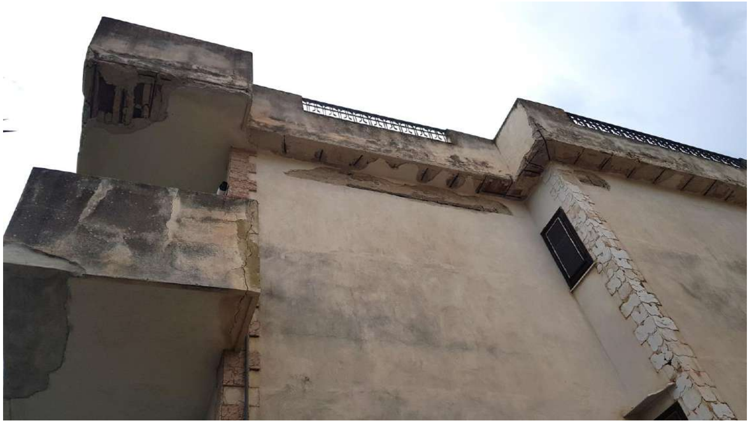
Foto n. 8. Dettaglio della parte sommitale del fabbricato, prospetto Ovest.
