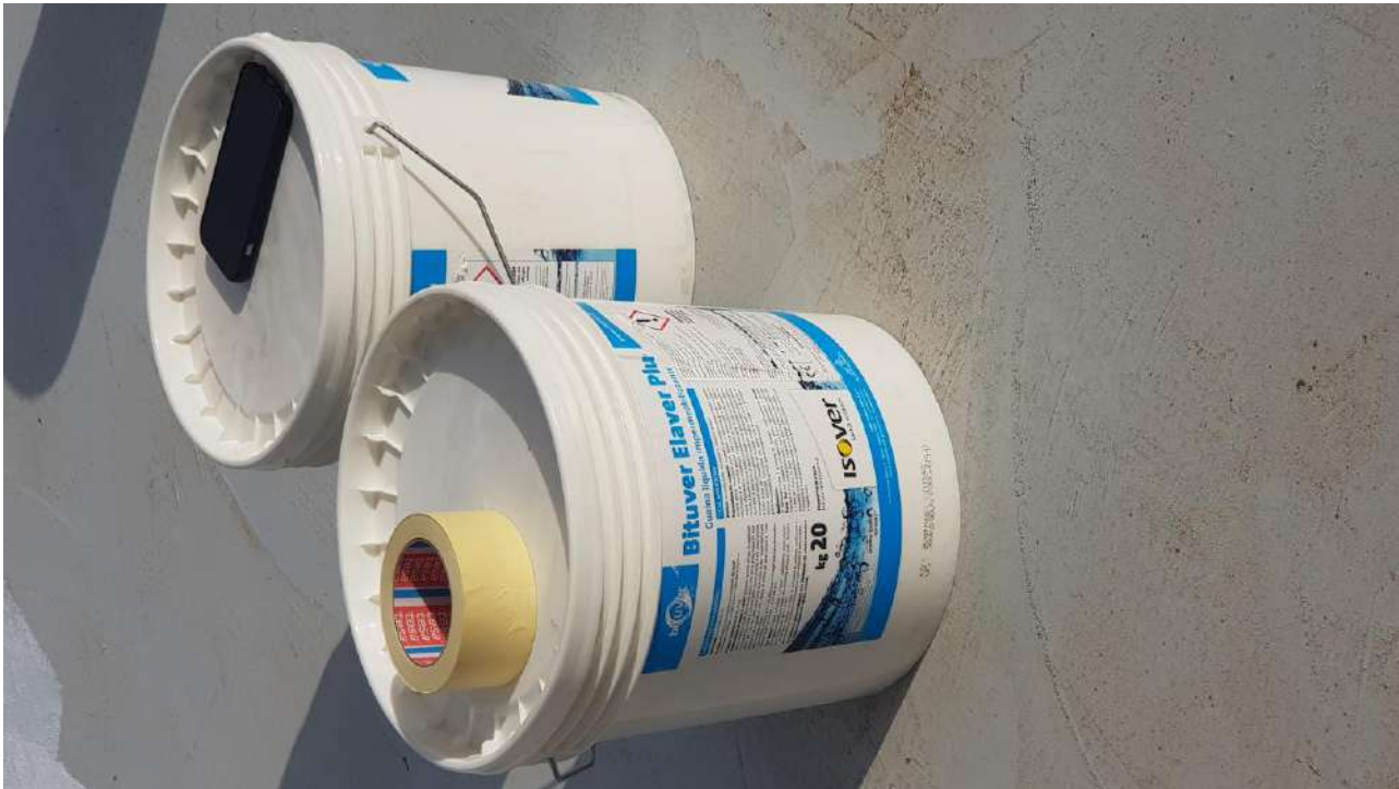
Foto n. 16. Tipologia di guaina impermeabilizzante passata sul lastrico solare.
