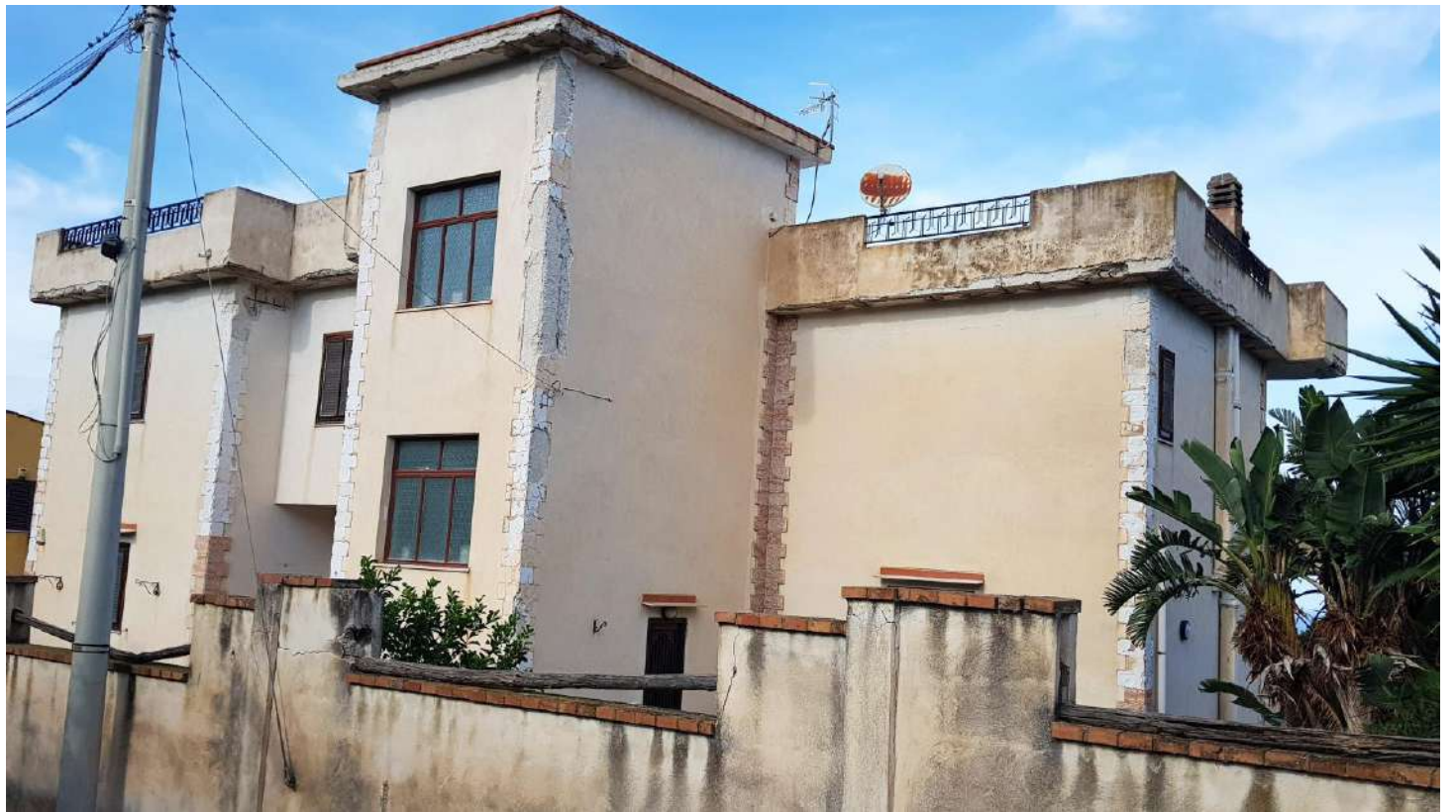
Foto n. 9. Prospetto Sud e, a destra, il prospetto Est.
