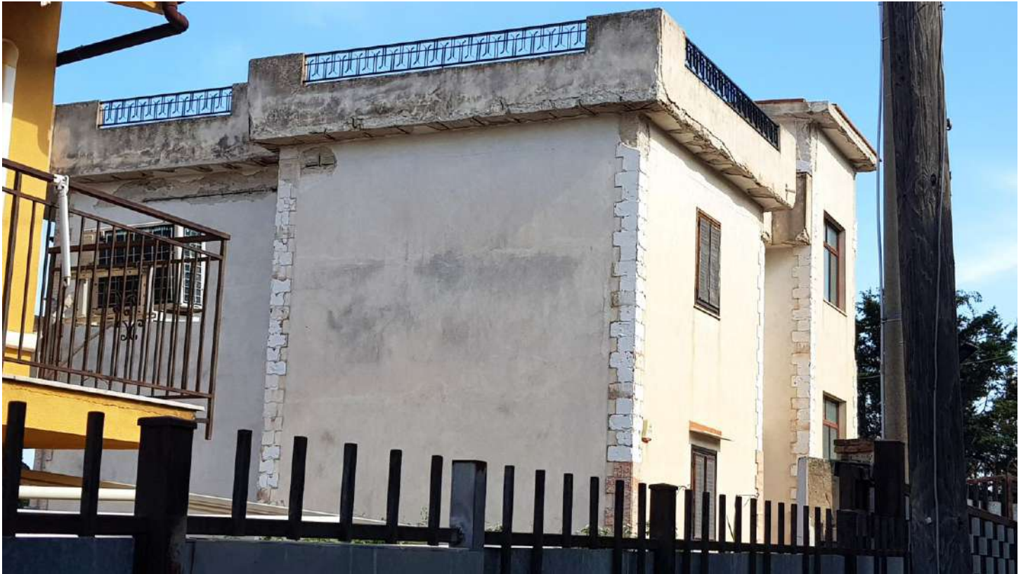
Foto n. 2. Prospetto Ovest a fine lavori.
