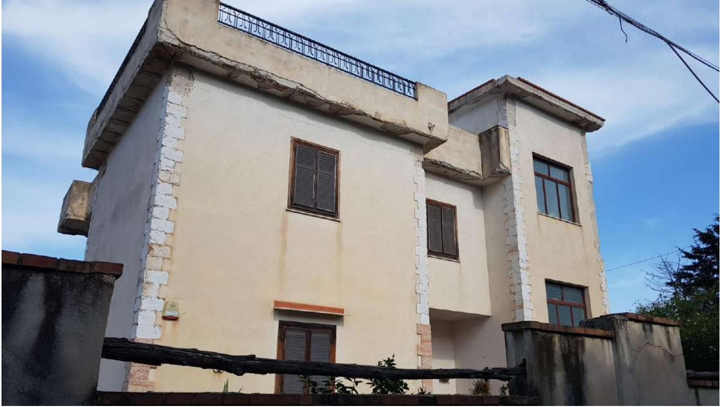
Foto n. 1. Prospetto Sud, lato ingresso, a fine lavori.
