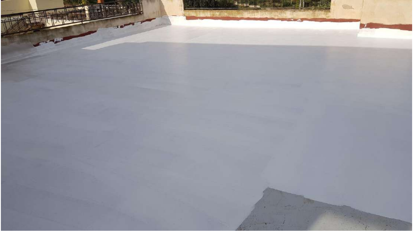
Foto n. 13. Guaina impermeabilizzante passata a rullo su tutto il terrazzo di copertura.
