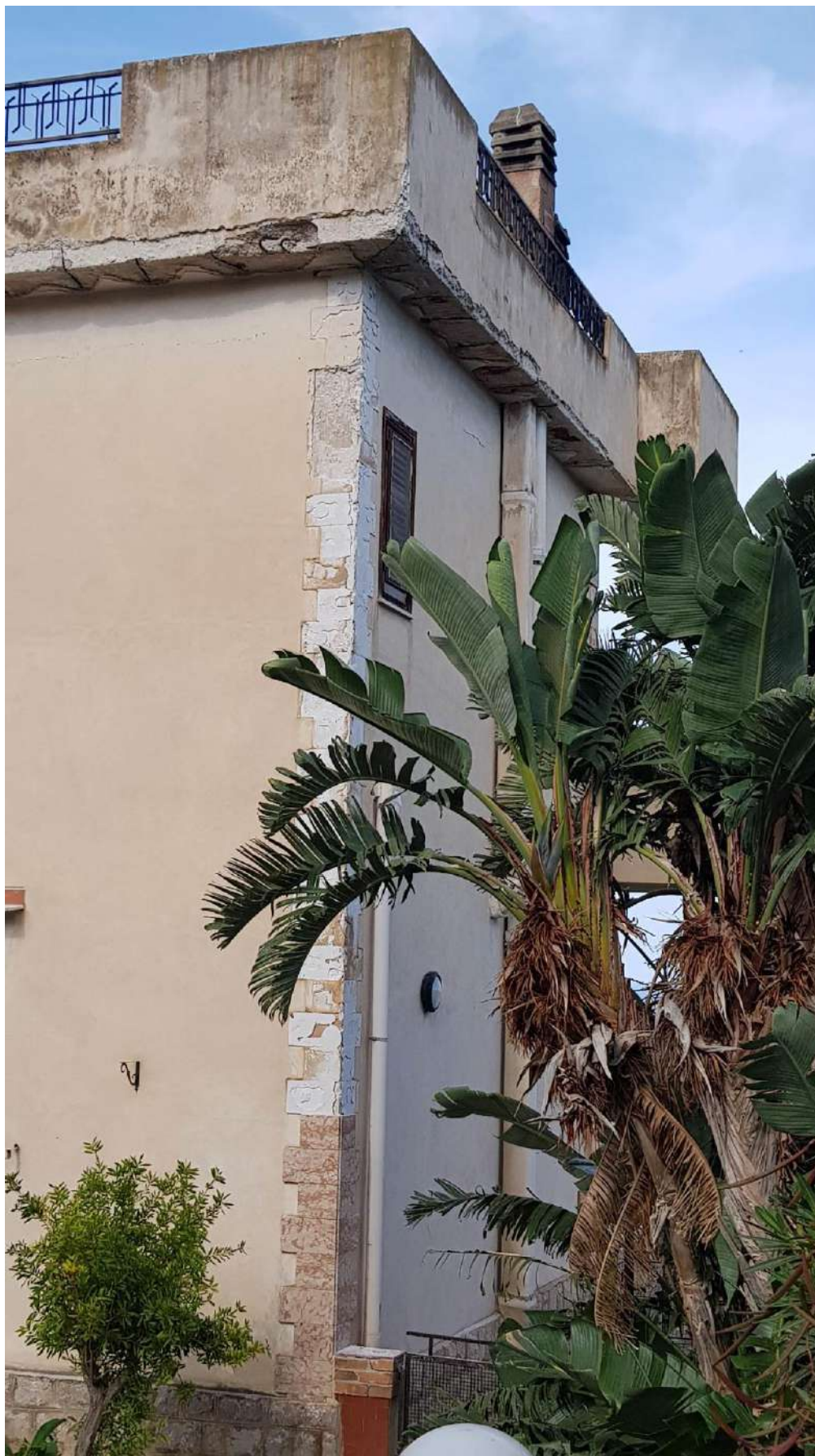
Foto n. 13. Dettaglio prospetto Est.
