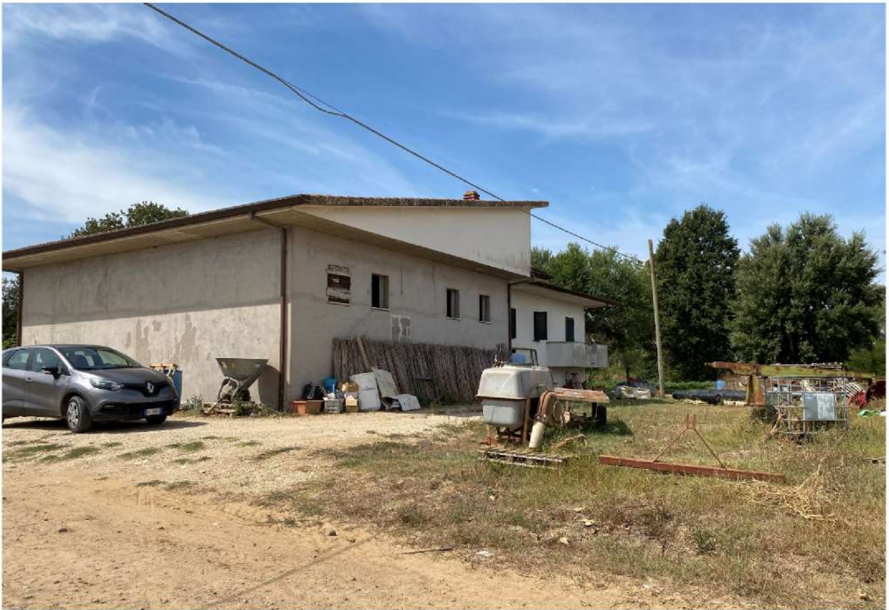
ESTERNO RAVVICINATO - FABBRICATO LATO EST
