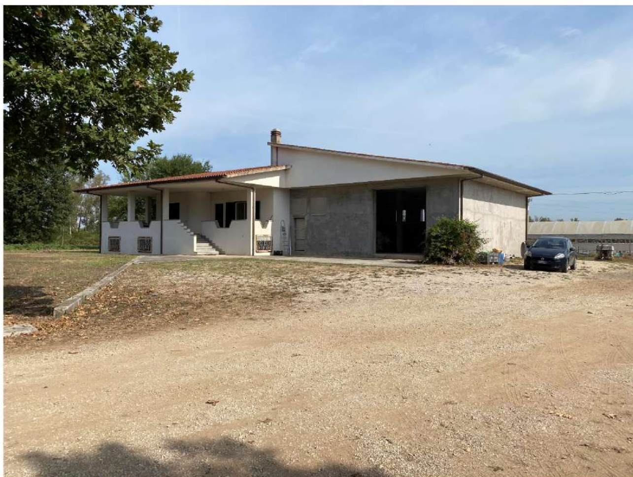
ESTERNO RAVVICINATO - FABBRICATO LATO SUD
