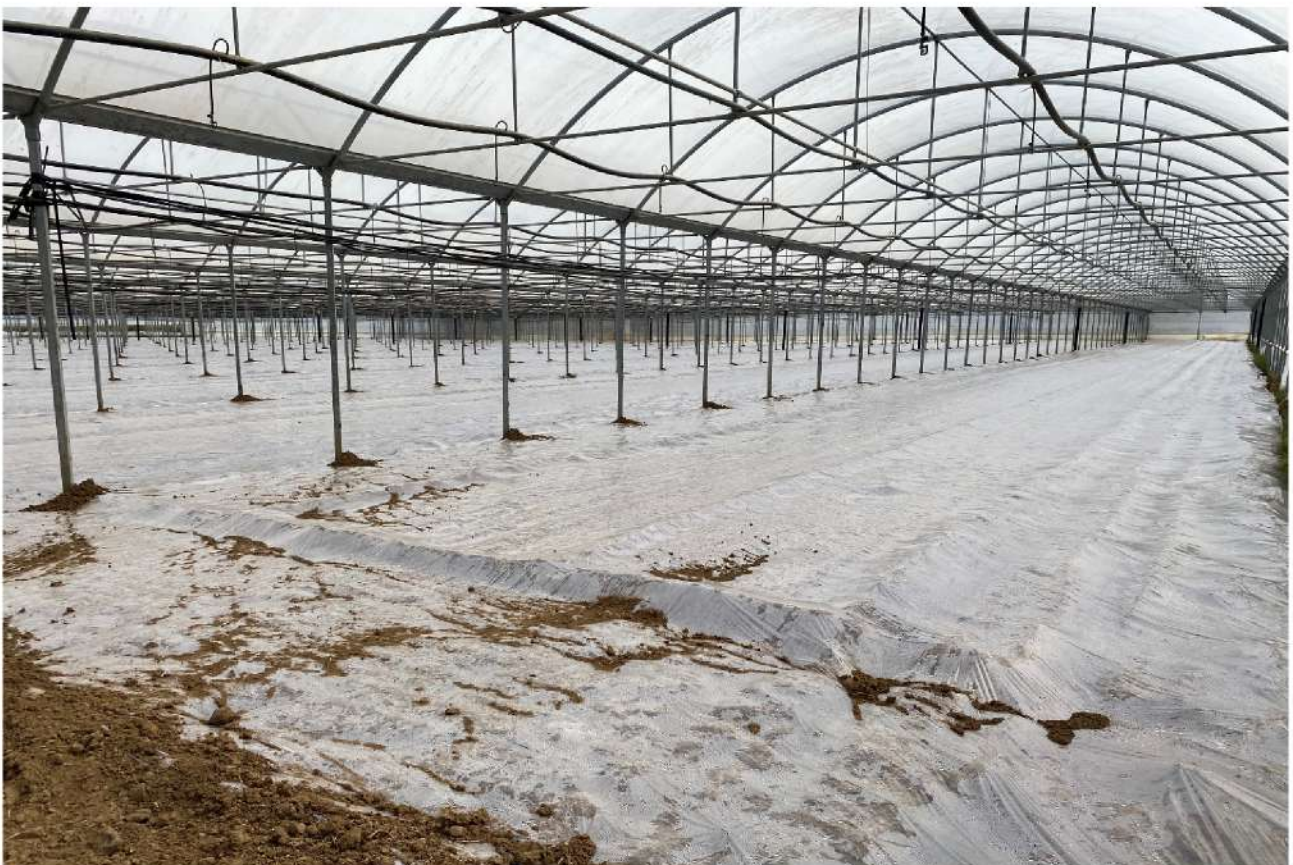
INTERNO RAVVICINATO – DETTAGLIO STRUTTURA SERRE E SANIFICAZIONE TERRENO
