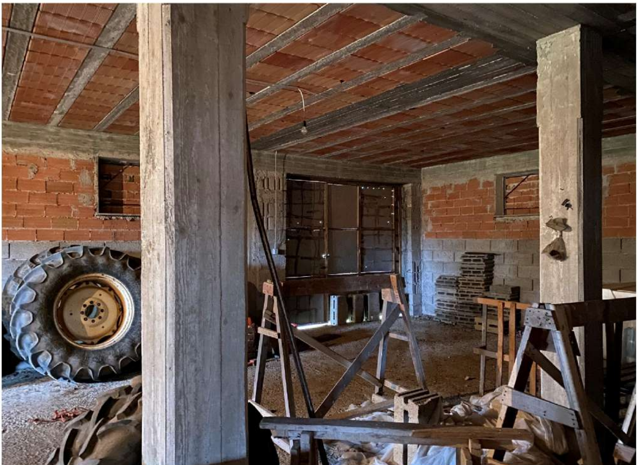
INTERNO LOCALE INTERRATO – STATO AL RUSTICO (IN CATASTO ANCORA IN COSTRUZIONE)
