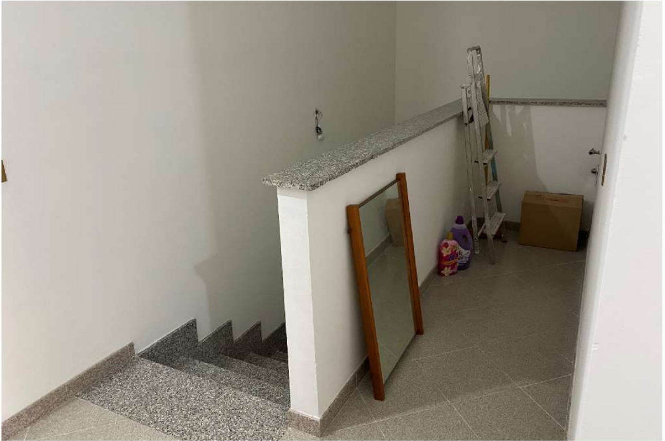
INTERNO APPARTAMENTO – SCALA DI ACCESSO AL PIANO INTERRATO (ANCORA IN COSTRUZIONE)
