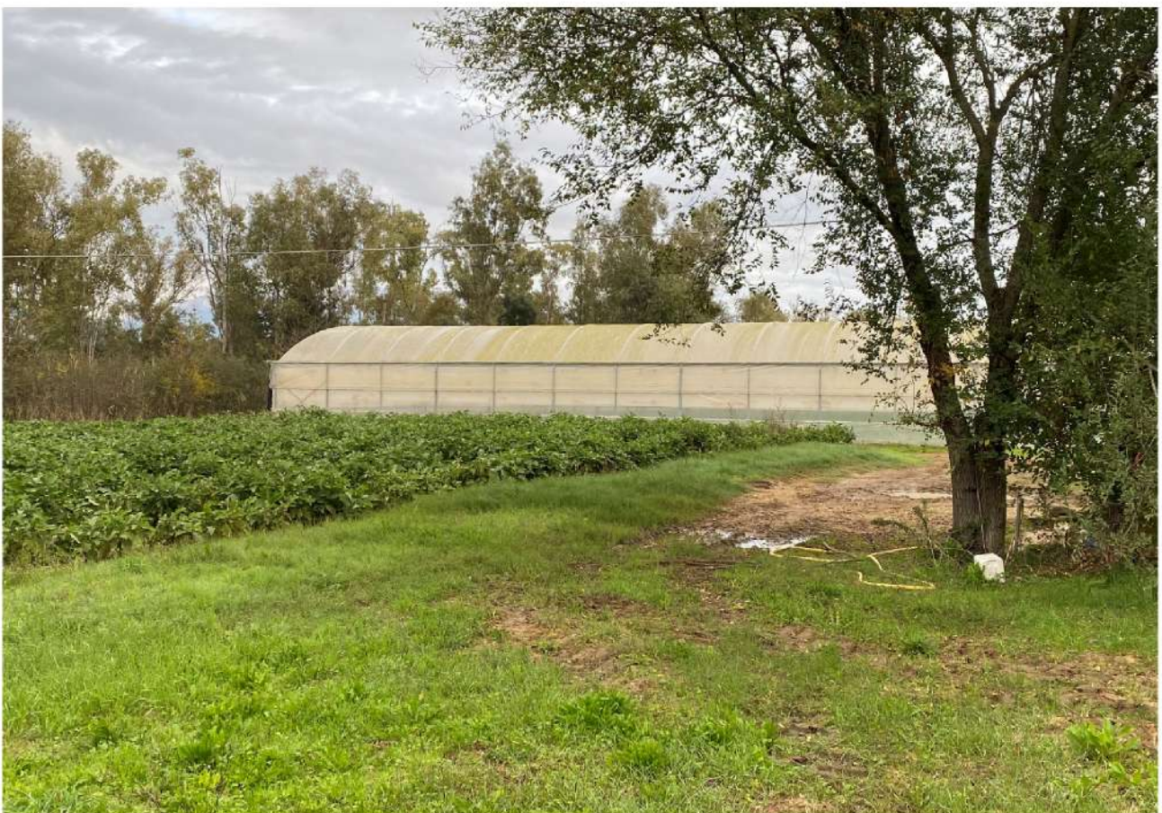
ESTERNO – INQUADRAMENTO ALTRO BLOCCO DI SERRE SU PARTICELLA 184 E 182
