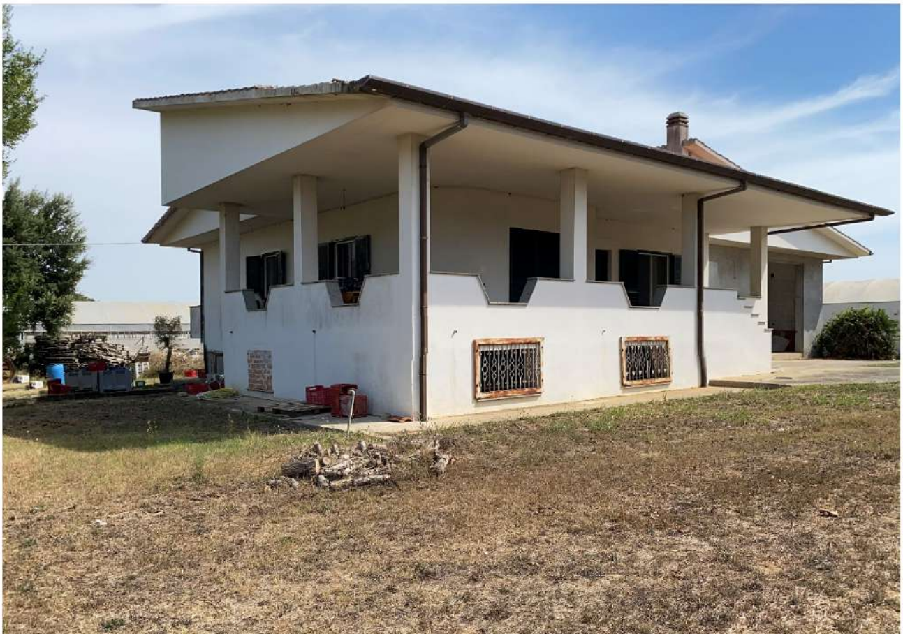
ESTERNO RAVVICINATO - FABBRICATO LATO OVEST
