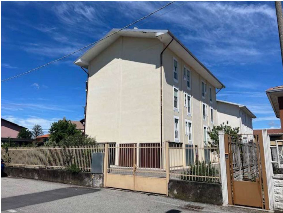
Fronte sud ed ovest su Via Milano
