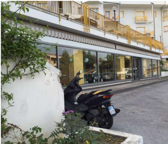
Foto n. 3 - Prospetto principale prospiciente su Piazza Gentile
