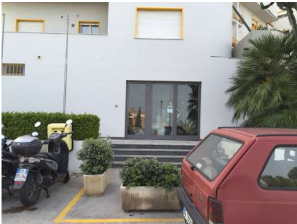
Foto n. 1 - Prospetto principale prospiciente su Piazza Gentile
