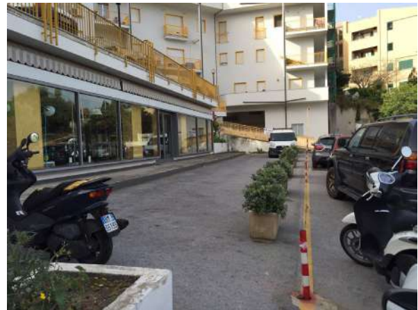
Foto n. 2 - Prospetto principale prospiciente su Piazza Gentile e area di pertinenza esclusiva ad uso parcheggio
