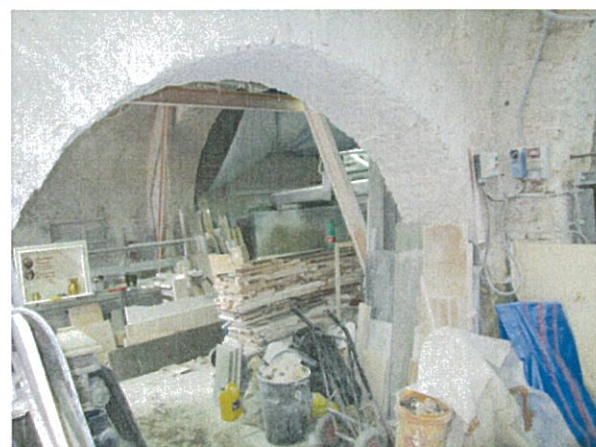
Foto n.4Bis Passaggio- collegamento tra i due locali.
