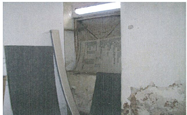
Foto n.20 Vista della finestra al locale civ.21
