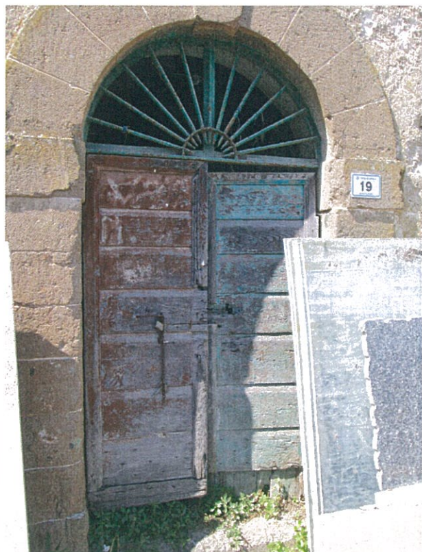
Foto n.9 Negozio/deposito vista esterno. Civ.19
