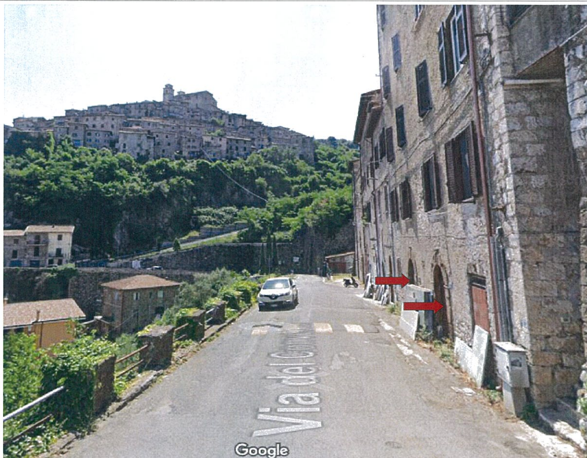
Foto n.13 Vista dei locali su via del Convento civici 19 e 21
