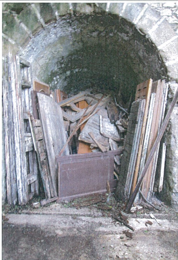
Foto n.35 Vista della bocca della fornace.
