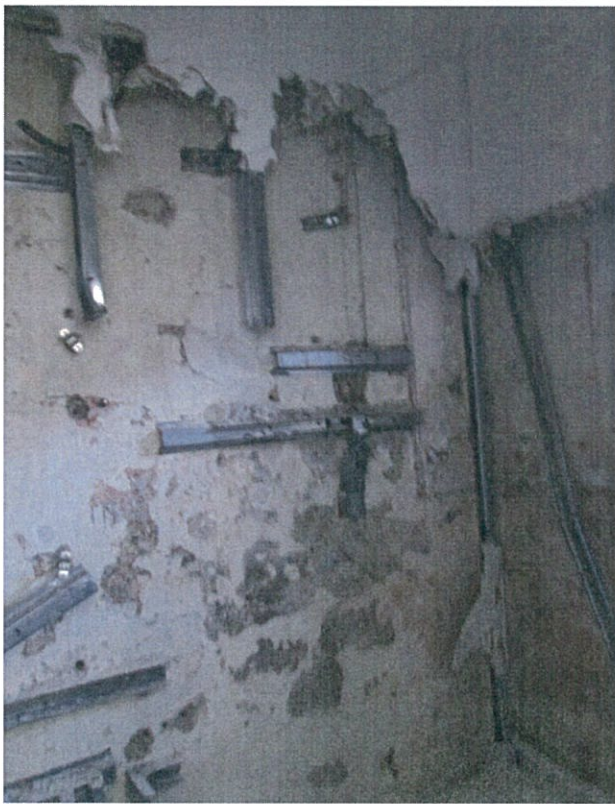
Foto n.19 Locale wc? Distruzione del cartongesso posto sulla muratura portante perimetrale molto umida.
