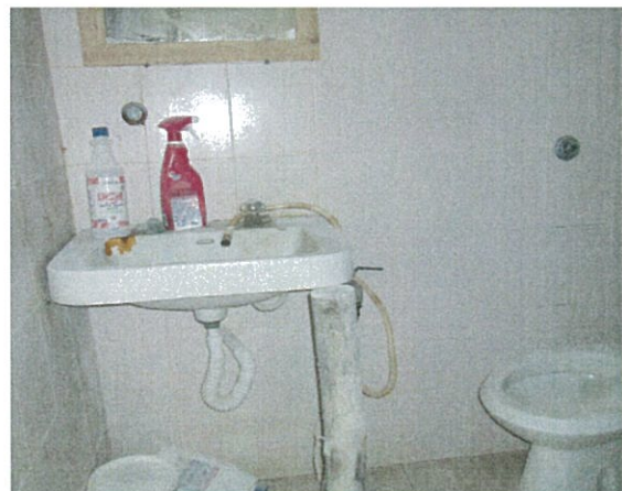
Foto n.8 Bis. Locale civ.13 Vista ingresso servizio Wc.
