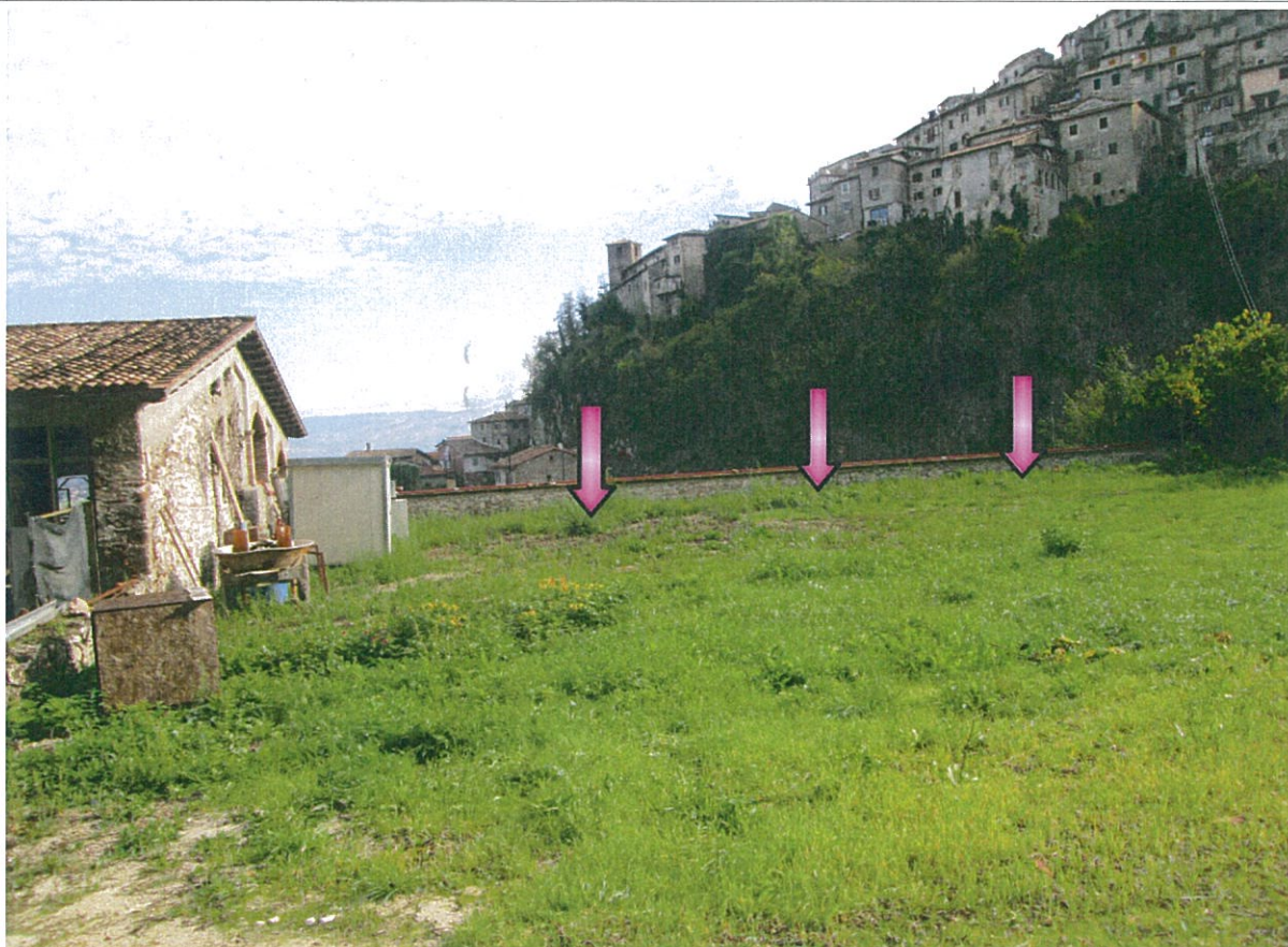
Foto n. 32 Vista del fabbricato a confine dei terreni esecutati in corrispondenza delle bocche di carico delle ex fornaci (Posizione delle frecce). Terreni distinti in Catasto con le Part. 678(ex 44) e 385 Fog.23.
