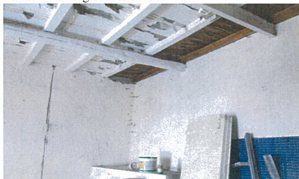
Foto n.16 Vista dell'interno locale civ.21
