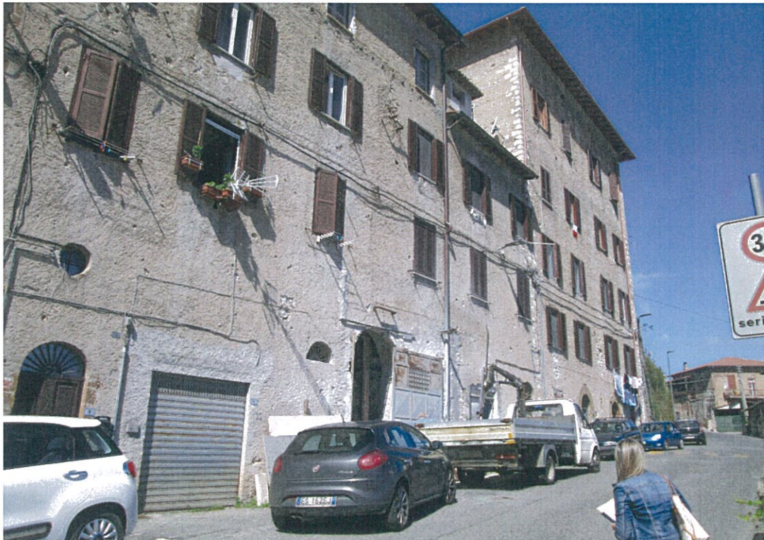
Foto n.2. Vista del fabbricato in cui a piano terra insistono i locali: commerciale lab. Marmista e di deposito
