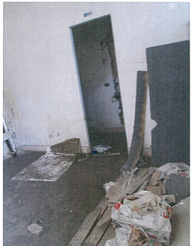
Foto n.18 Divisione interna locale civ.21 per il wc?.
