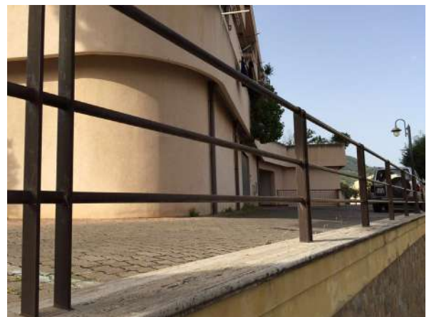
Foto n. 4 - Vista dell'ingresso del lotto B
