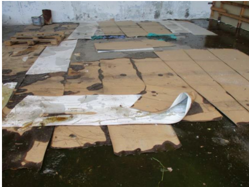
Vista interna PT (fabbricato 5) – Deposito
