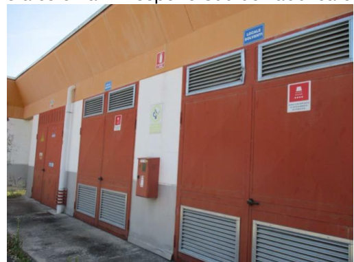
Vista esterna – Prospetto Ovest del fabbricato 4
