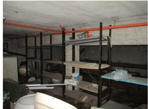
Vista interna PT (fabbricato 6) – Cantina
