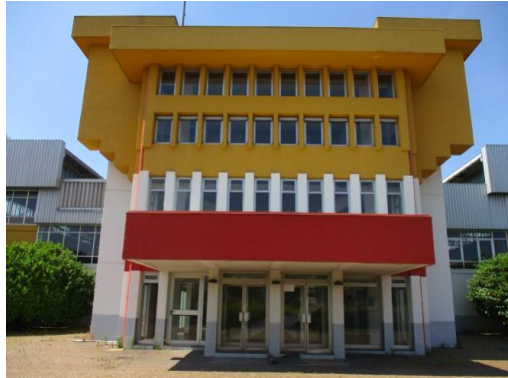
Vista esterna – Ingresso principale al fabbricato (zona uffici)
