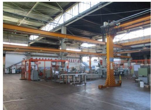
Vista interna PT (fabbricato 1) – Lab. di premontaggio
