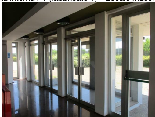
Vista interna PT (fabbricato 2) – Atrio
