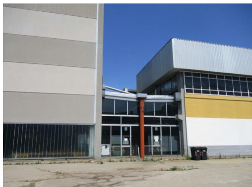
Vista esterna – Prospetto Est del fabbricato 1
