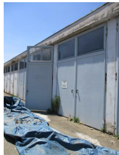
Vista esterna – Prospetto Sud fabbricato 5
