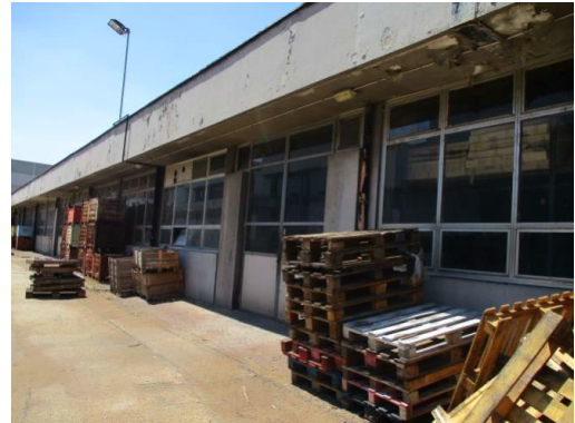
Vista esterna – Prospetto Sud del fabbricato 3
