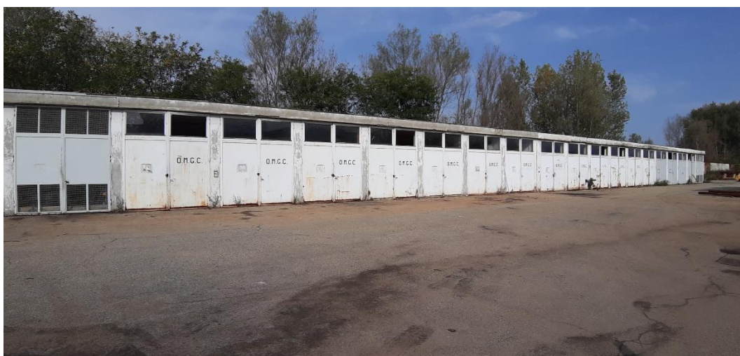
Box rifiuti e depositi
