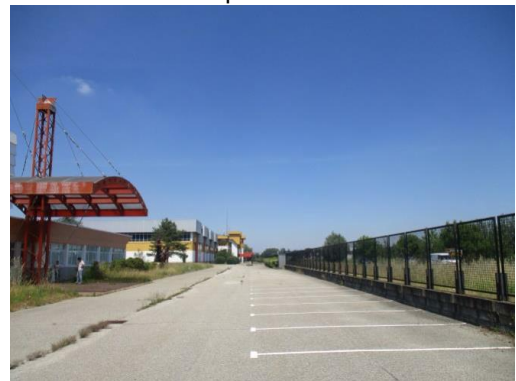
Vista esterna – Prospetto Sud del fabbricato 4
