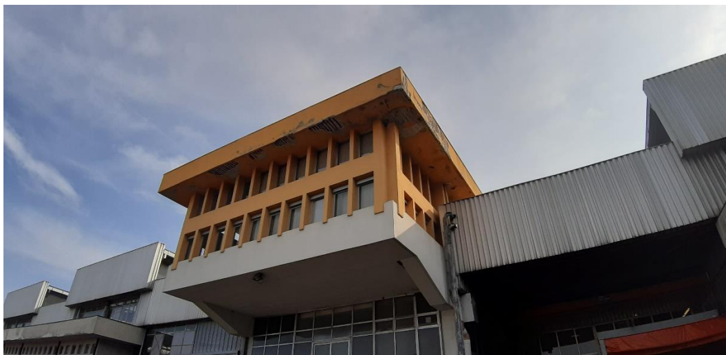
Palazzina uffici - retro
