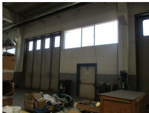
Vista interna PT (fabbricato 1) – Magazzino
