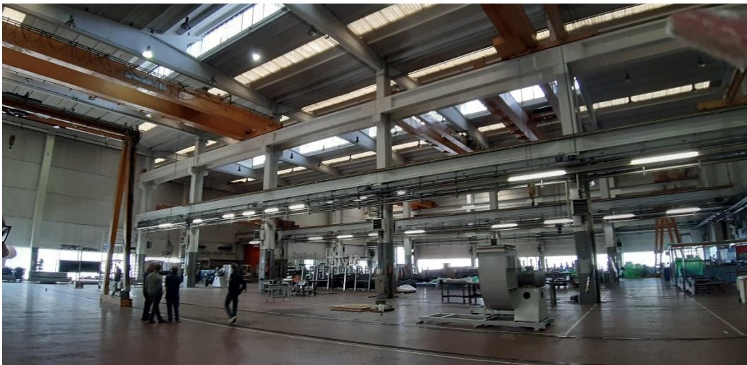
Capannone Montaggio – interno
