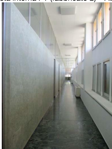
Vista interna P1 (fabbricato 2) – Corridoio
