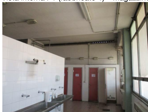
Vista interna PT (fabbricato 1) – Spogliatoi
