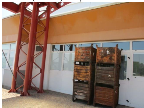
Vista esterna – Prospetto Sud del fabbricato 4 ingr. principale
