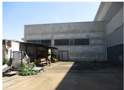
Vista esterna – Prospetto Nord del fabbricato 1
