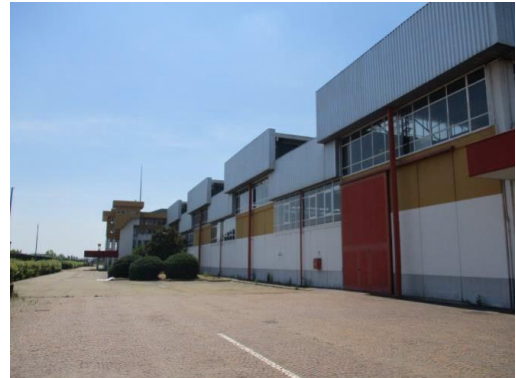
Vista esterna – prospetto Sud del fabbricato 1
