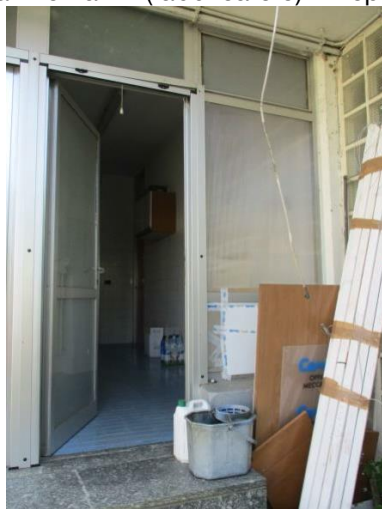
Vista esterna – Ingresso alloggio del custode (fabbr. 6)
