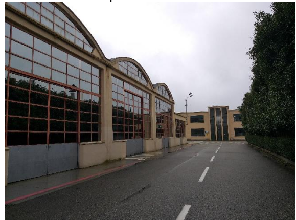
Prospetto deposito (fabbr. 7)
