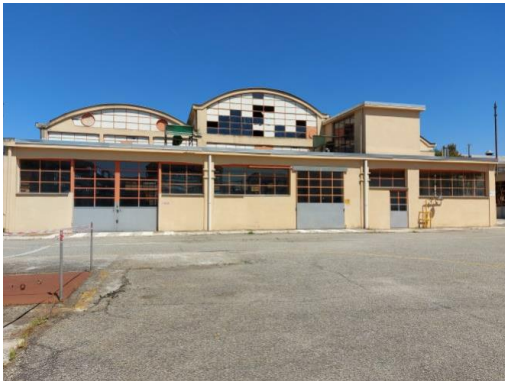
Vista esterna – Prospetti Est fabbricato 7
