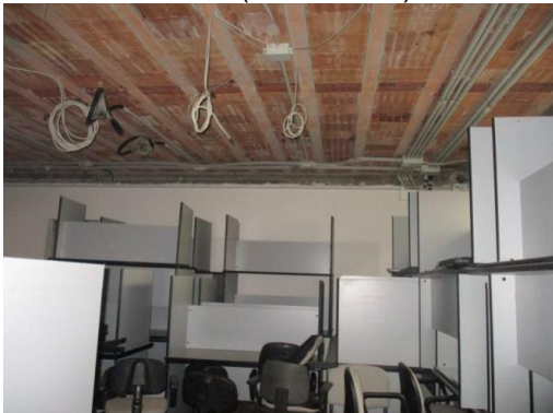
Vista interna PT (fabbricato 4) – Uffici non utilizzati
