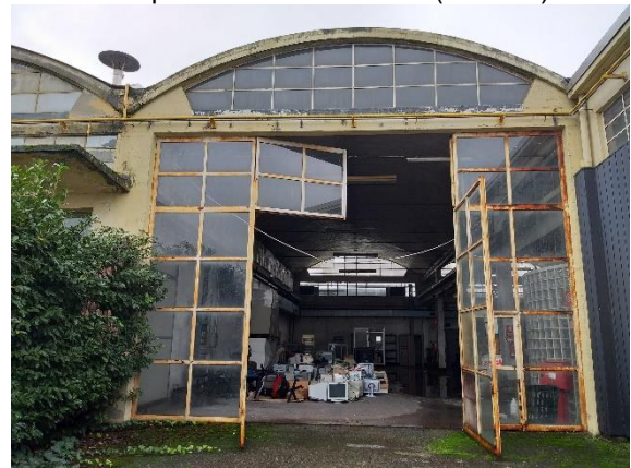
Prospetto deposito abbandonato (fabbr. 6)
