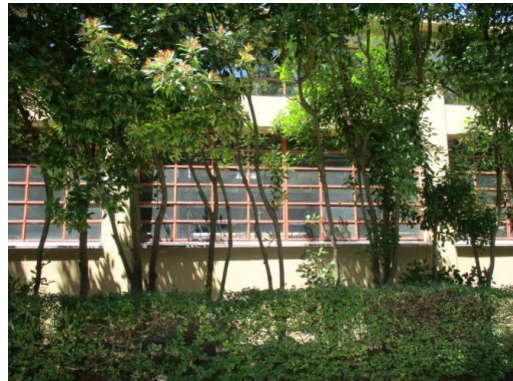
Vista esterna – Prospetto Sud fabbricato 7
