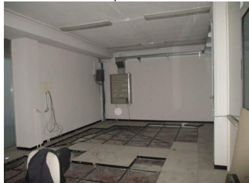
Vista interna PT (fabbricato 4) – Uffici non utilizzati
