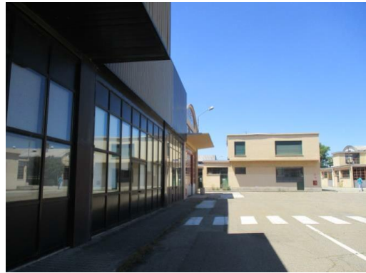
Vista esterna – Prospetto Est fabbricato 5
