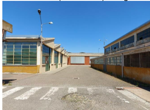
Vista esterna – Prospetto Sud fabbricato 3
