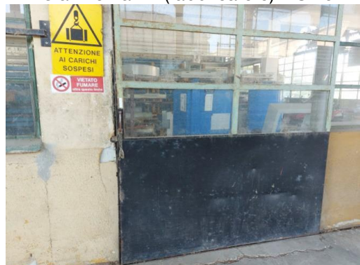
Vista esterna – Prosp. Nord accesso al fabbr. 6
