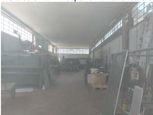
Vista Interna PT (fabbricato 9) – Deposito
