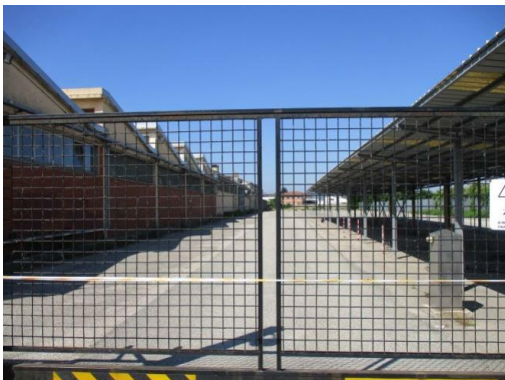
Parcheggio esterno di pertinenza
