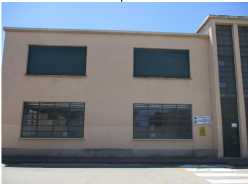
Vista esterna – Prospetto Est fabbricato 9
