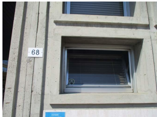
Accesso al fabbricato 1 (uffici)
