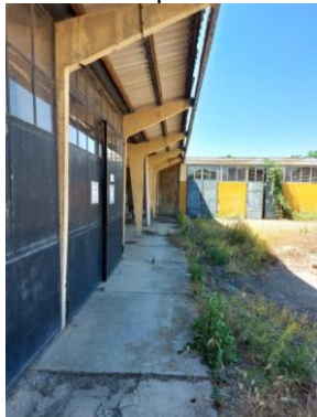
Vista esterna – Prospetto Est fabbricato 8
