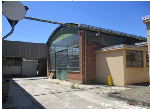
Vista esterna – Prospetto Sud fabbricato 9
