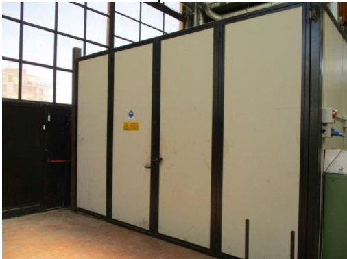
Vista interna PT (fabbricato 2) – Area Montaggio
