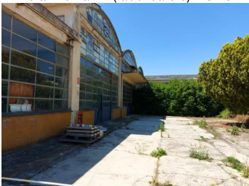
Vista esterna – Prospetto Est fabbricato 6
