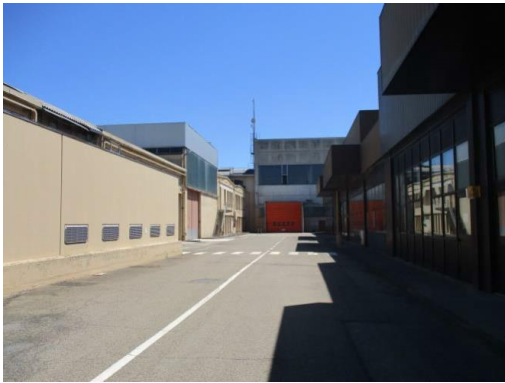
Vista esterna – Prospetto Est fabbricato 5
