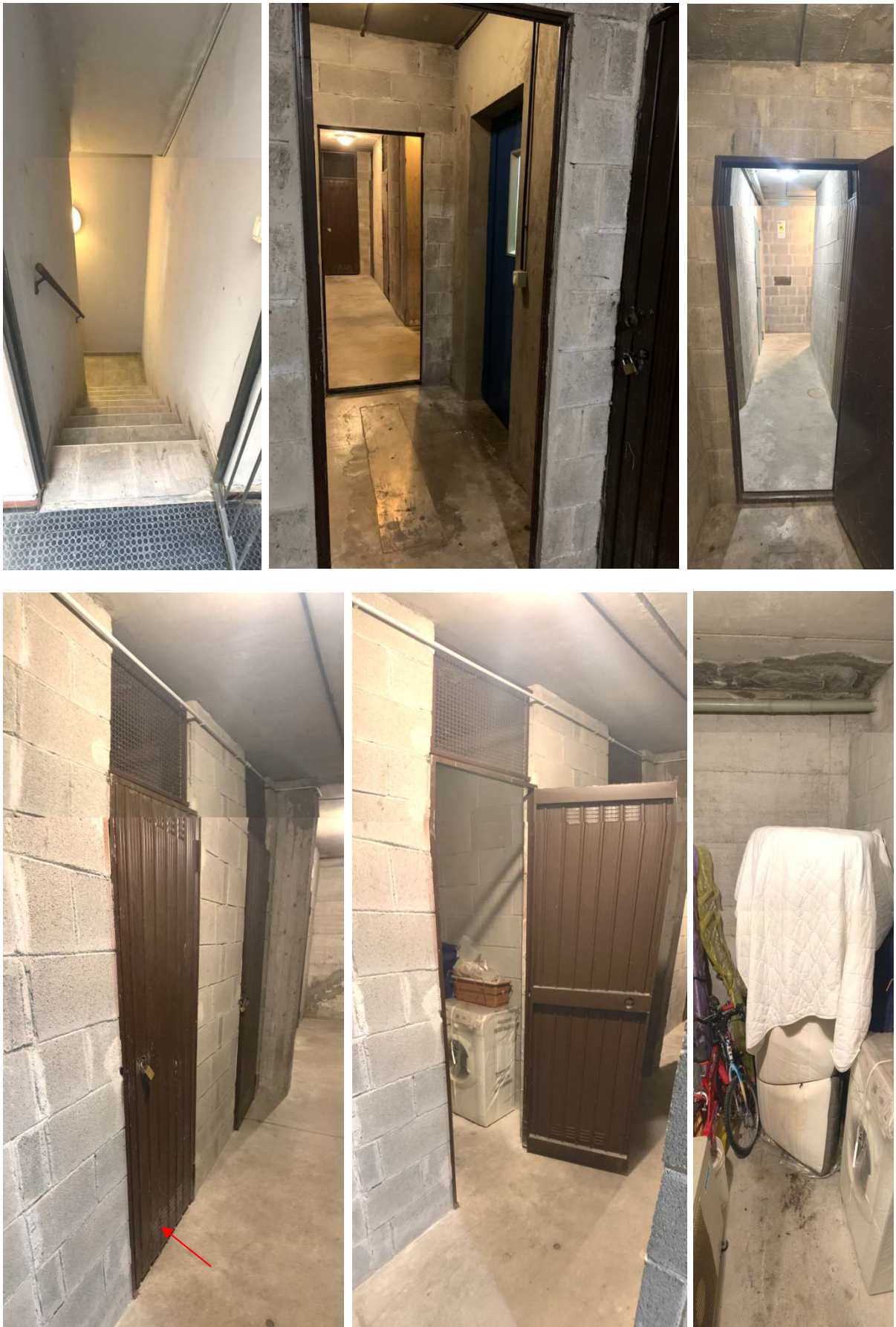
Foto nn. 35-36-37-38-39-40. Piano S1. Cantina
