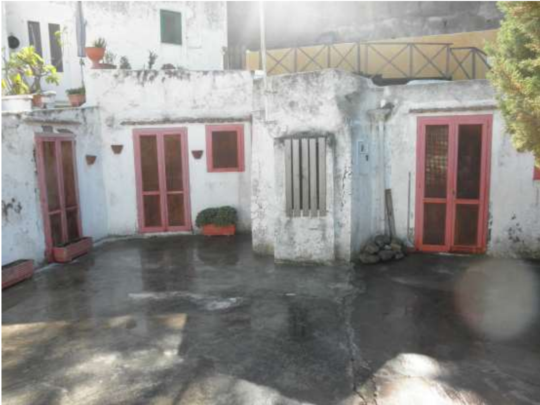
Foto 15 – Ingresso e area esterna
