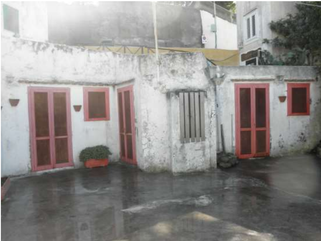
Foto 16 - Ingresso e area esterna
