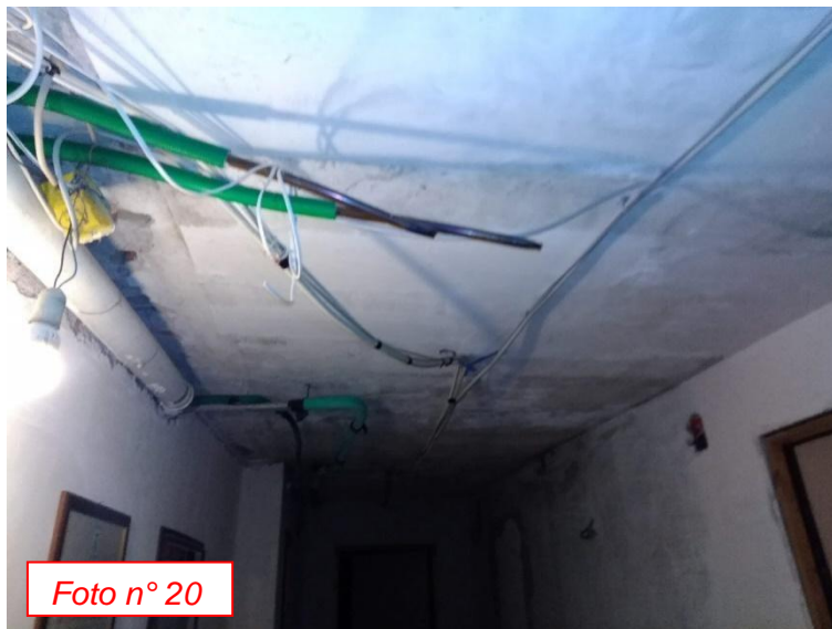
Foto 20: zona ingresso alloggio custode al quarto piano
