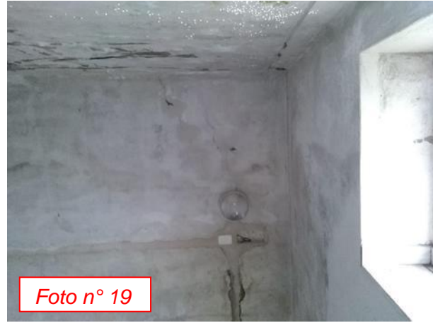
Foto 16-17-18 e 19: copiose e abbondanti infiltrazioni d'acqua alle pareti e soffitto del vano scala lato ovest
