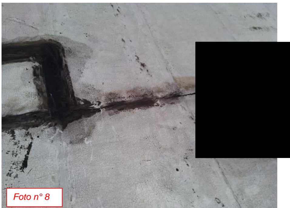
Foto 8: dettaglio di fessure passanti della guaina fino al sottostante massetto
