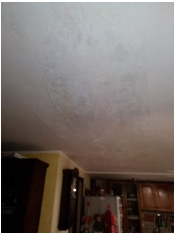
Foto relative ad infiltrazioni d'acqua al soffitto del soggiorno dell'alloggio custode al quarto piano
