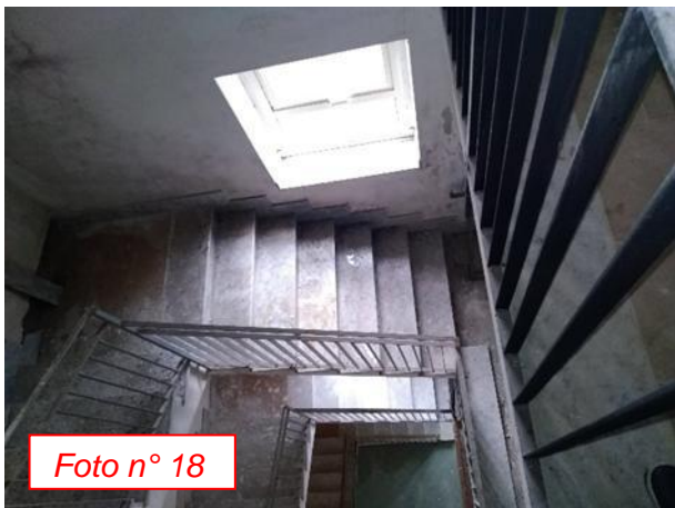
Foto 16-17-18 e 19: copiose e abbondanti infiltrazioni d'acqua alle pareti e soffitto del vano scala lato ovest
