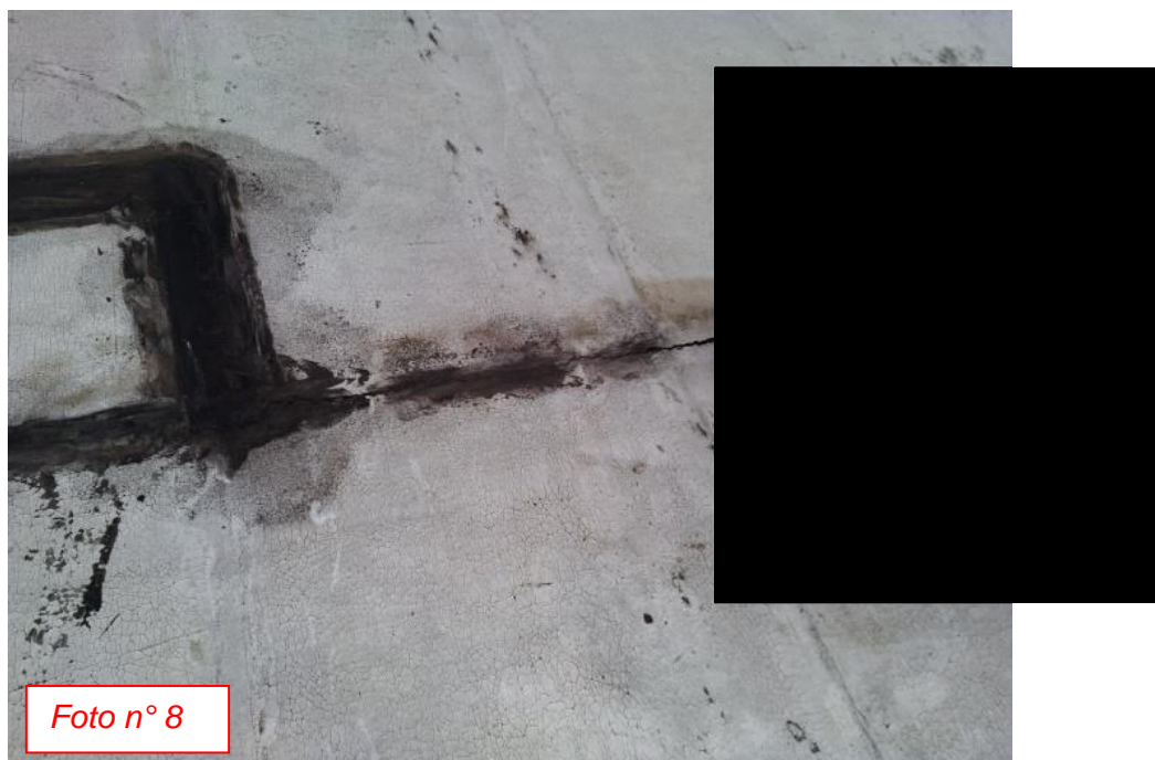
Foto 8: dettaglio di fessure passanti della guaina fino al sottostante massetto
