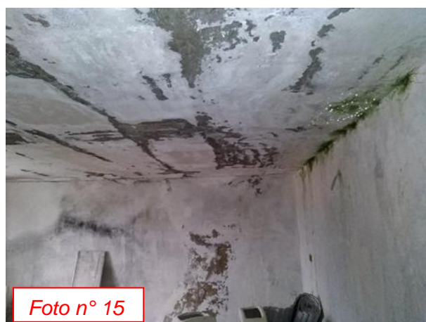
Foto 12 - 13 - 14 e 15: copiose e abbondanti infiltrazioni d'acqua al quarto piano in una zona a rustico
