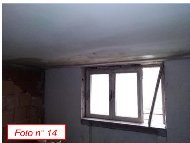
Foto 12 - 13 - 14 e 15: copiose e abbondanti infiltrazioni d'acqua al quarto piano in una zona a rustico
