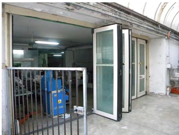
Ingresso del piano interrato
