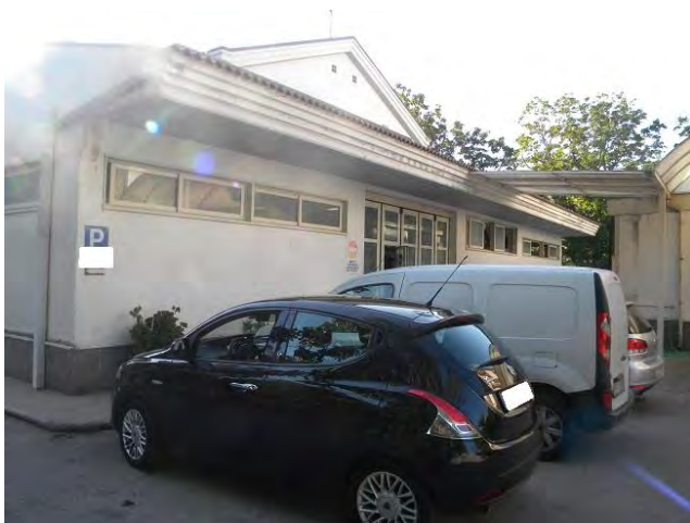
Vista d'insieme del fabbricato
