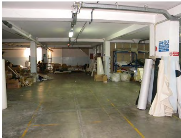
Altro vano deposito posto al piano interrato
