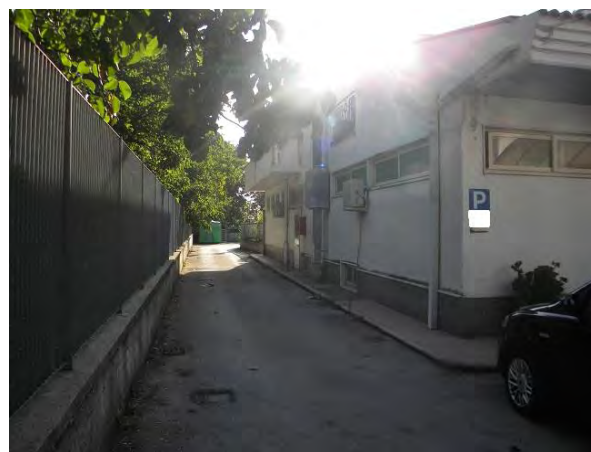
Area pertinenziale e prospetto Sud-Est
