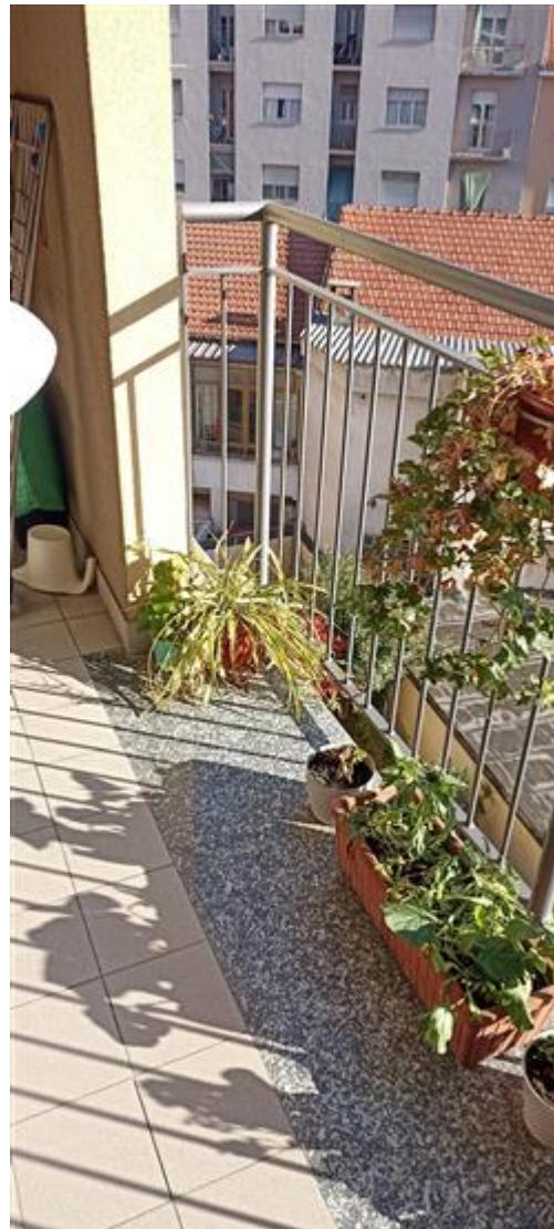
particolare ringhiera del terrazzino
