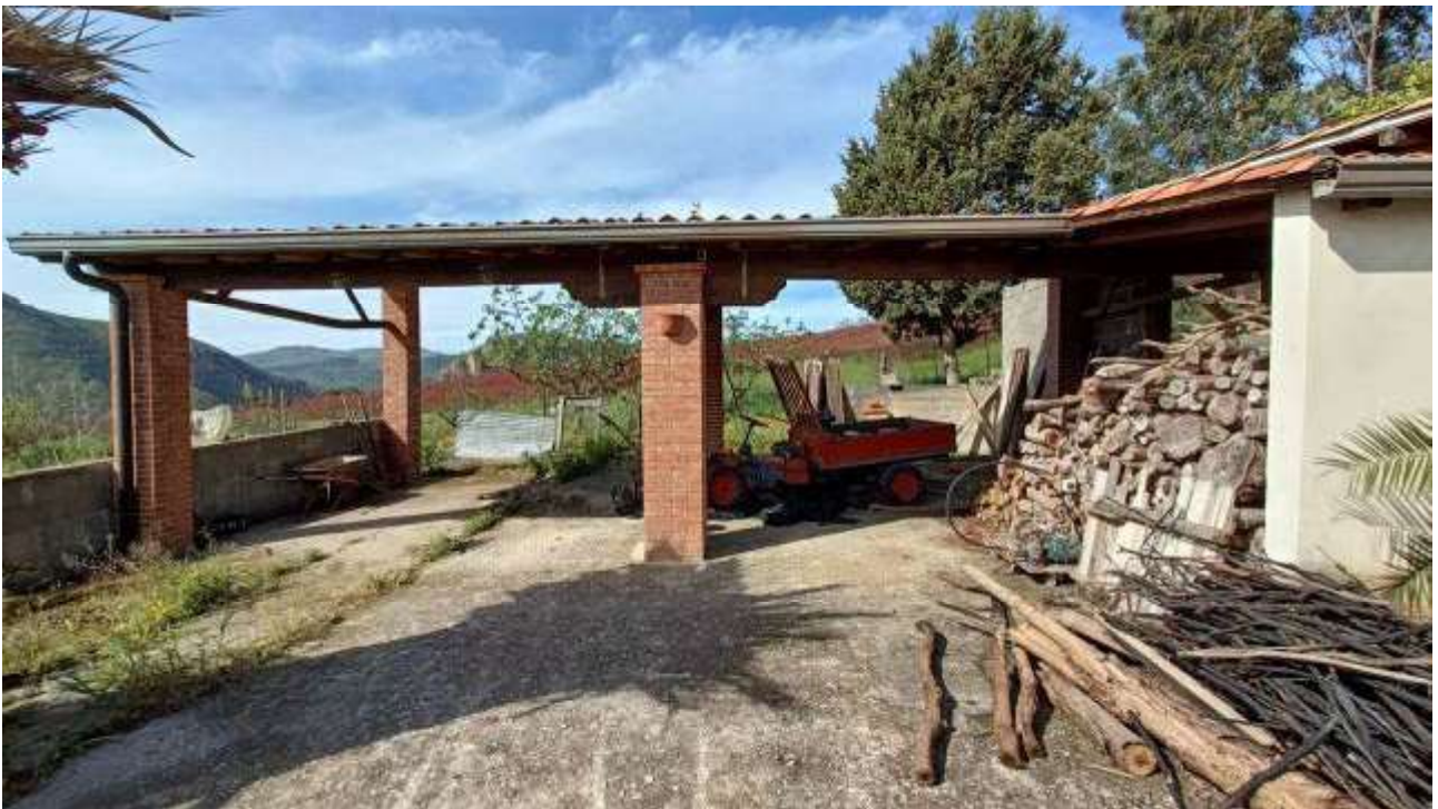
FOTO 6 – Tettoia A e legnaia
