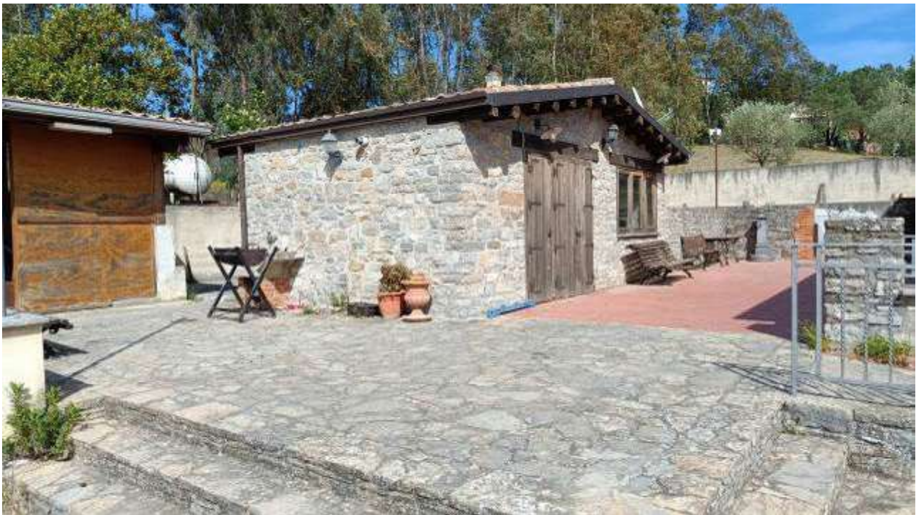
FOTO 4 – Prospetti sud e ovest cucina esterna, particolare del serbatoio GPL
