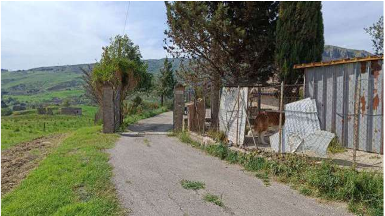
FOTO 1 – Stradella e cancello di accesso
