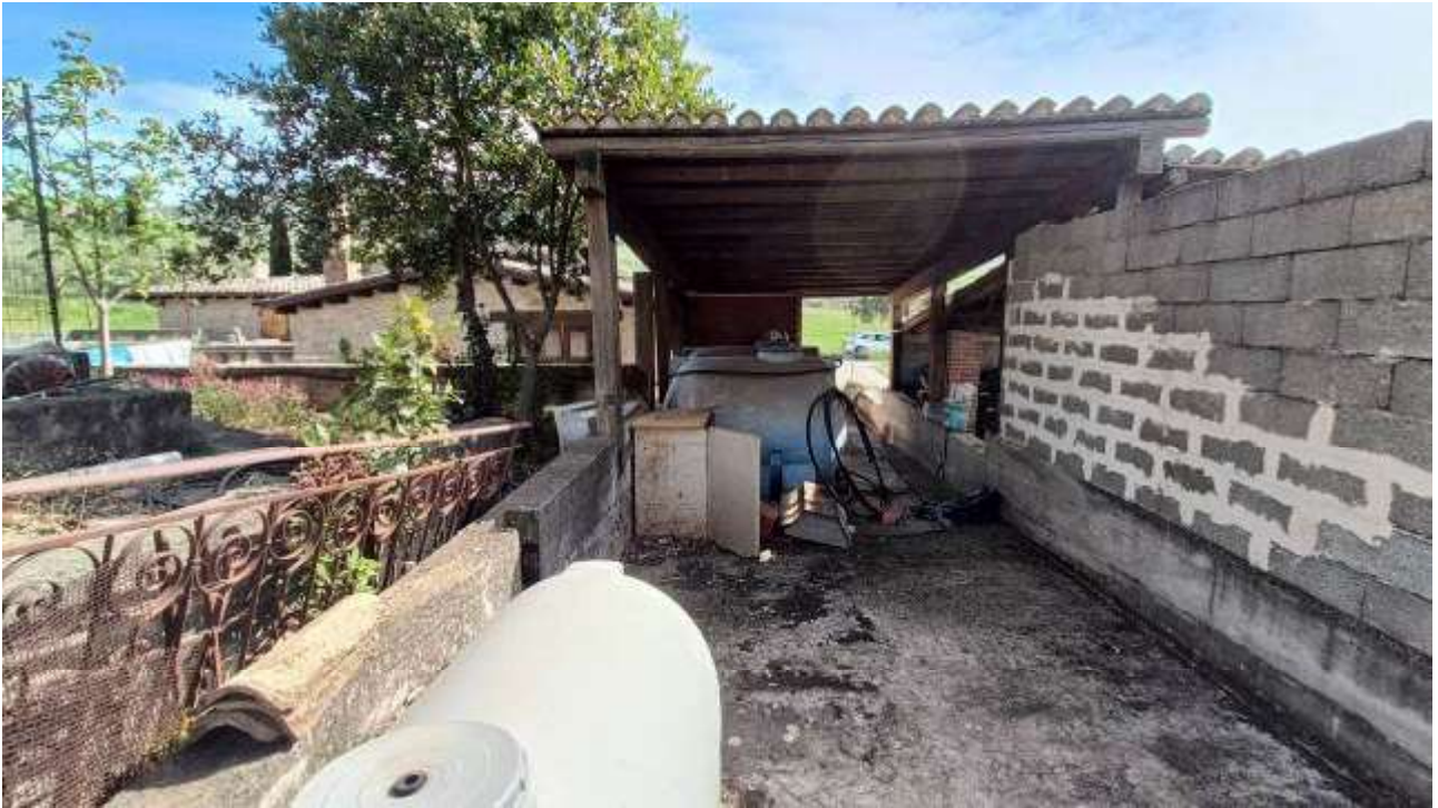
FOTO 5 – Tettoia B (riserva idrica)
