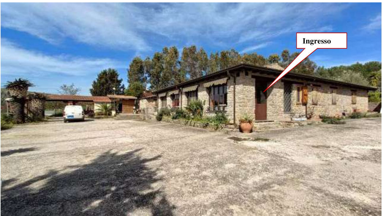
FOTO 2 – Prospetti sud e ovest della villa e tettoie sullo sfondo
