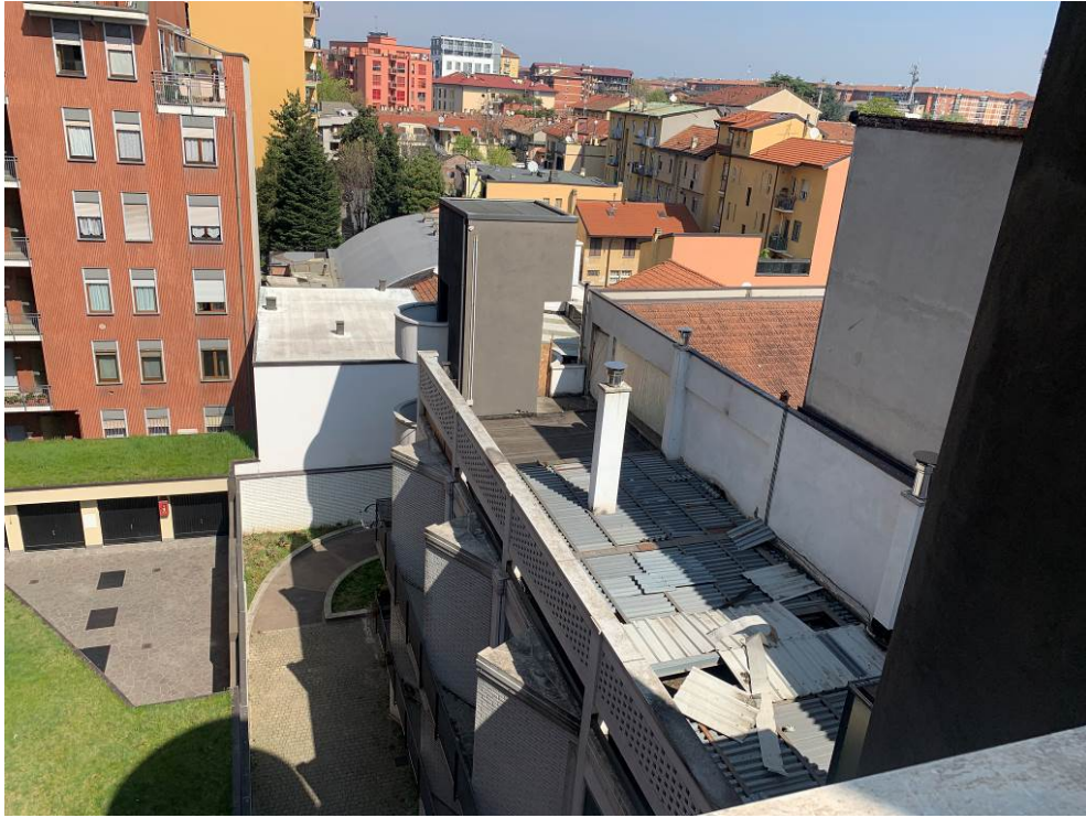
Fotografia n. 27 – Vista dall'alto del terrazzo, confinante con l'unità immobiliare B adiacente, sprovvisto di recinzione
