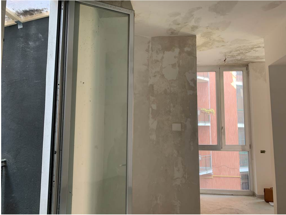
Fotografia n. 7 – Vista del locale ingresso
