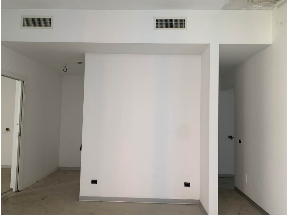
Fotografia n. 19 – Vista del disimpegno (a destra) e dell'angolo cottura (a sinistra)
