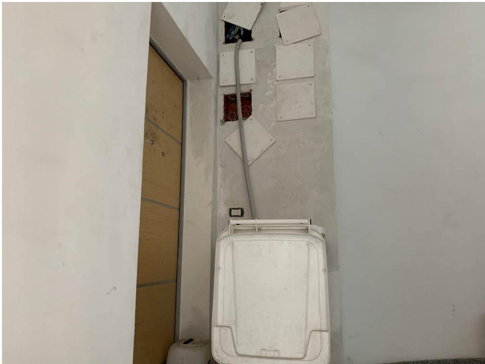
Fotografia n. 6 – Vista della porta di ingresso all'appartamento al piano secondo
