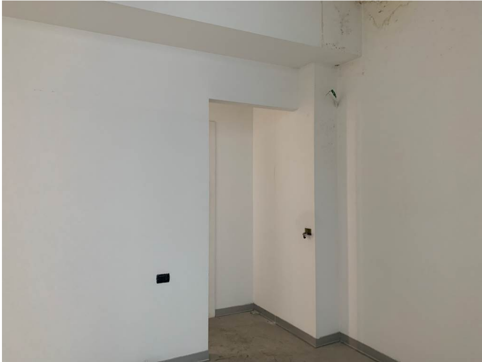
Fotografia n. 13 – Vista dell'apertura che conduce al disimpegno di accesso al locale bagno
