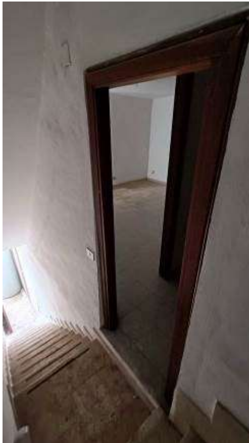
FOTO 4 – Ingresso dal vano scala interno
