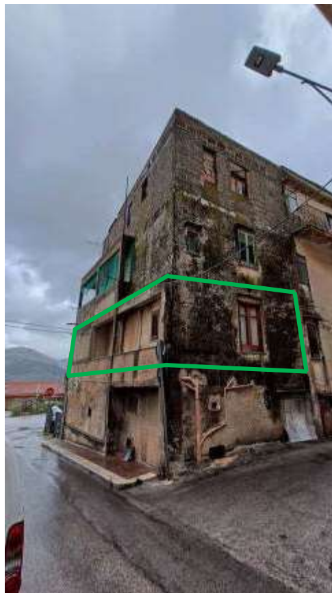
FOTO 2 – Prospetto sud-ovest e sud-est della palazzina
