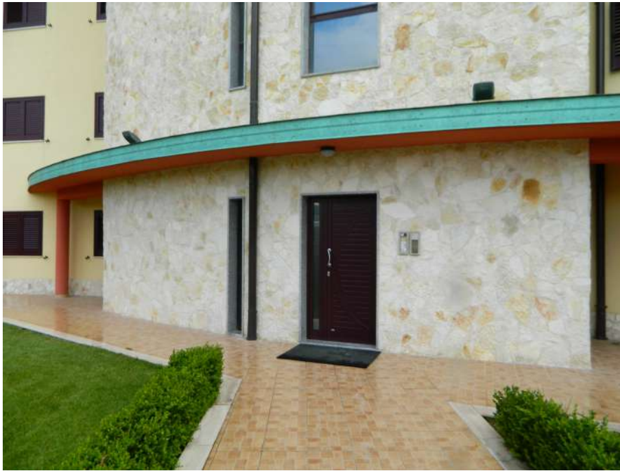
Portone d'ingresso dello stabile
