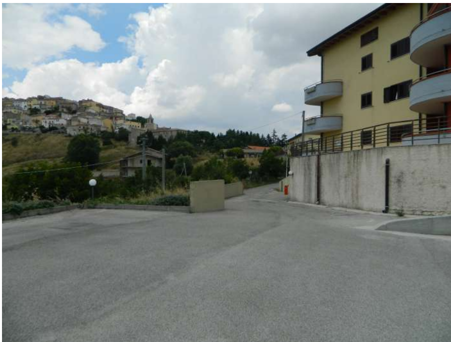
Rampa di accesso al piazzale posto a livello sotto-strada e al piano garage
