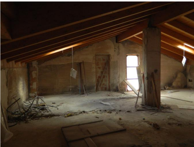
Foto locale deposito – piano sottotetto
