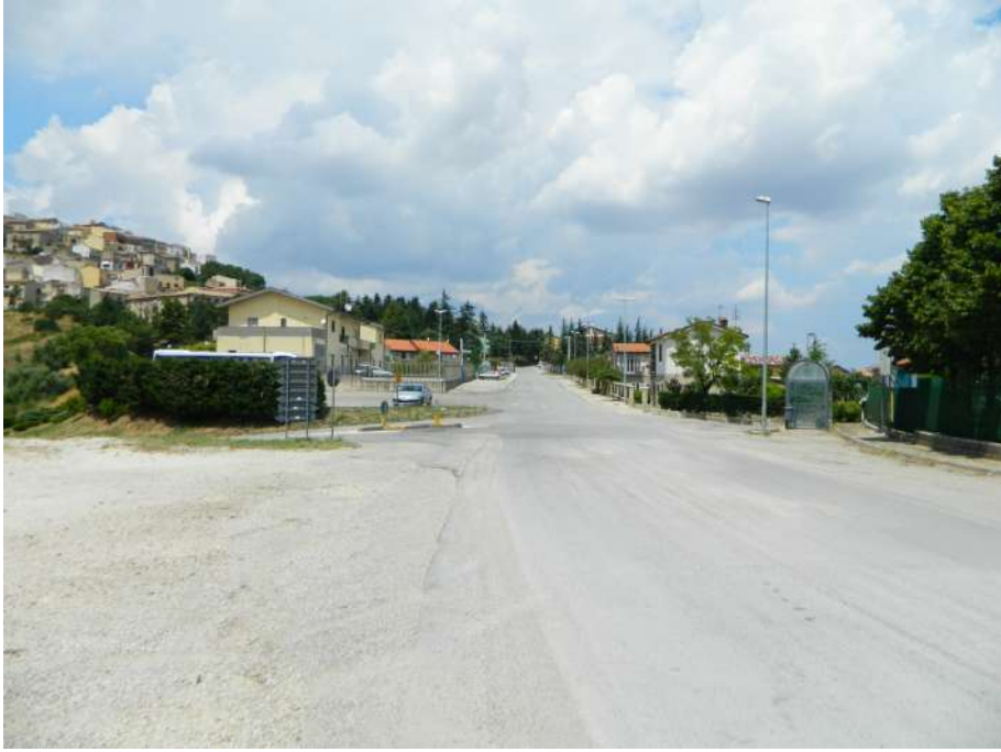
Strada di accesso al lotto
