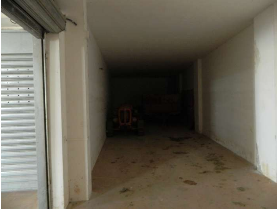
Vista interna del locale deposito oggetto di pignoramento
