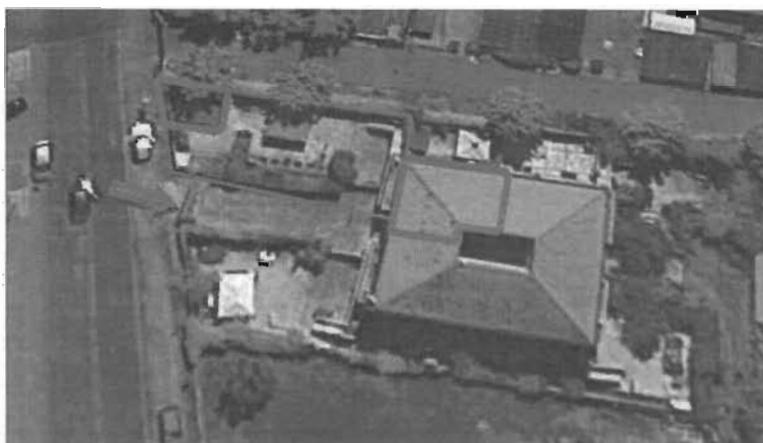
Foto aerea dell'immobile: a sinistra in angolo è il box, al centro la corte confinante col viale comune di accesso posto più in basso, indicato con freccia ed a destra l'ingombro dell'abitazione in villino.
