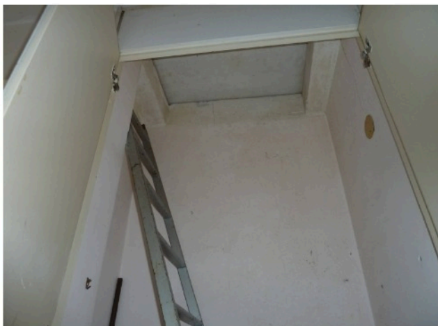
Foto n. 13 – L'accessorio del corridoio al piano 2°.
