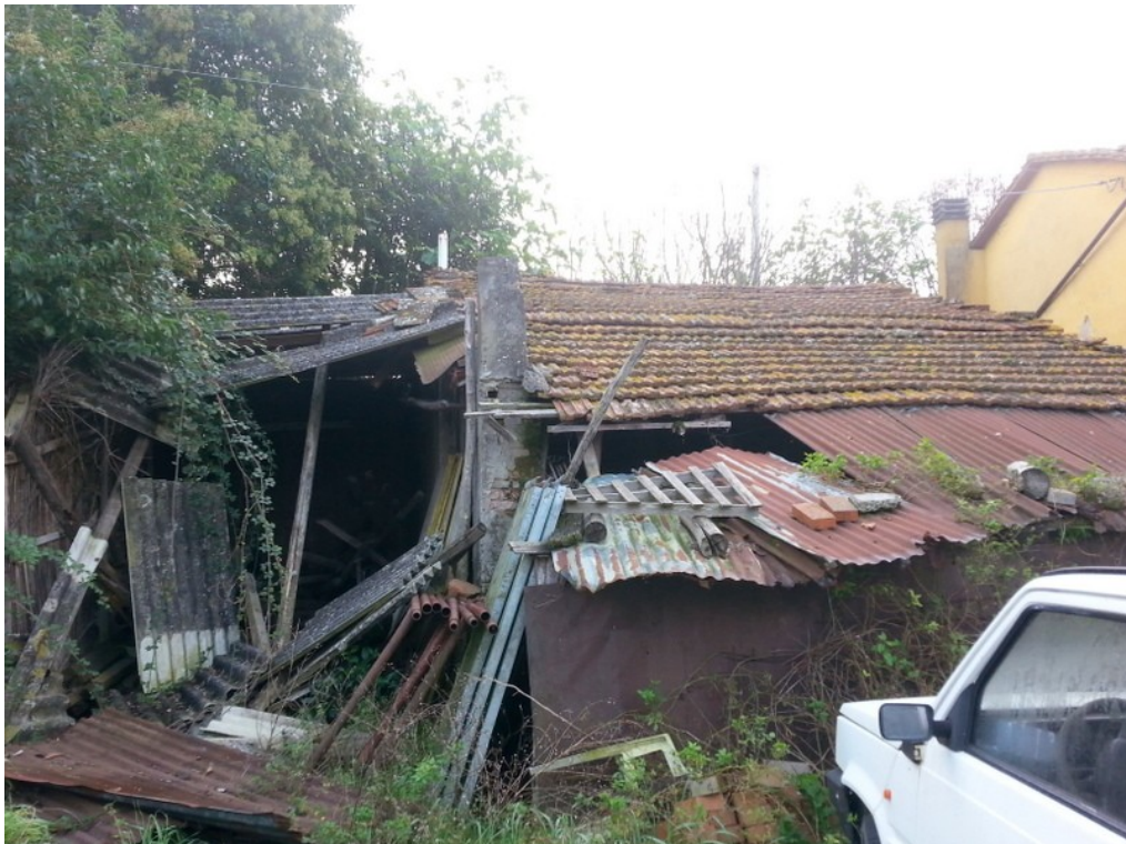
Foto 26 – Edificio C (locale di sgombero non accessibile)
