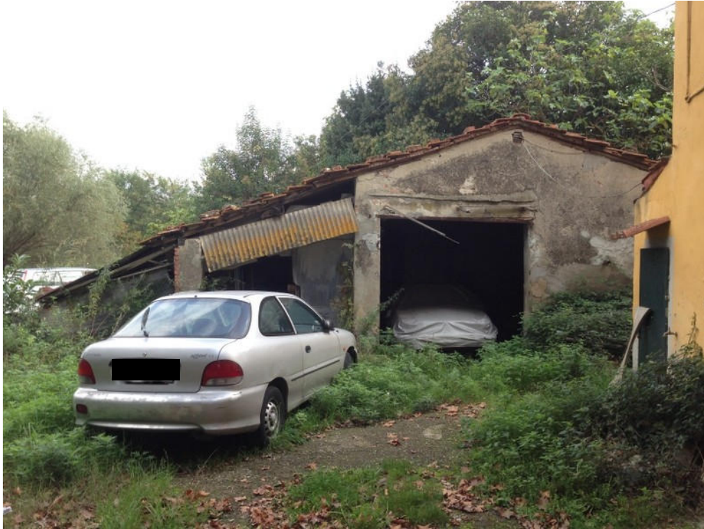
Foto 25 – Edificio C (locale di sgombero non accessibile)
