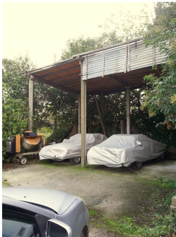
Foto 28 – Edificio D (locale deposito)
