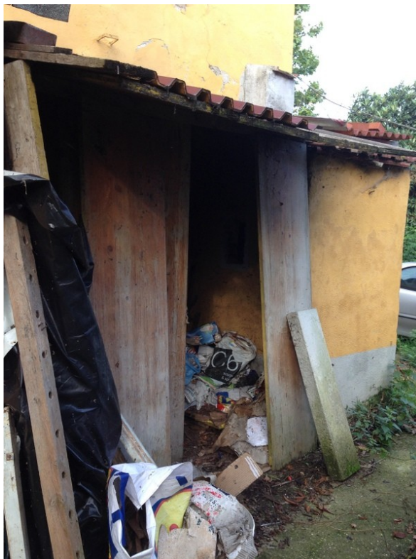
Foto 22 – Ripostiglio e locale tecnico
