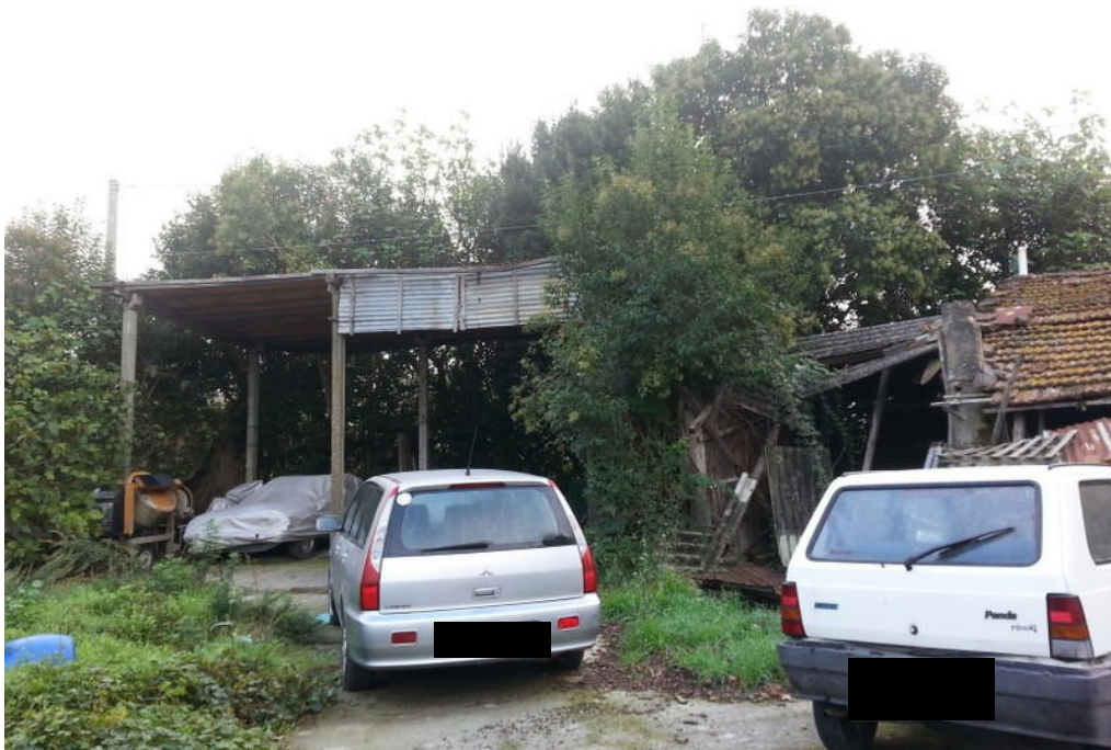
Foto 27 – Edificio D (locale deposito)
