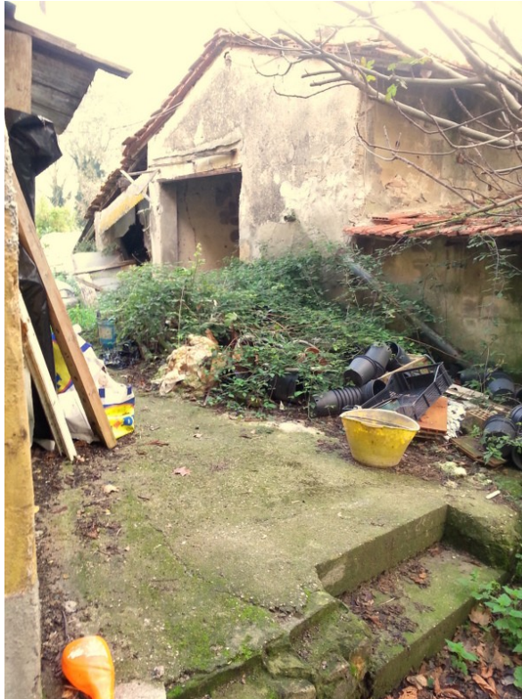
Foto 21 – Edificio C (locale di sgombero non accessibile)
