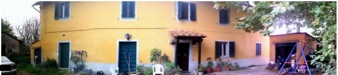
Foto 10 – Panoramica edificio A (prospetto frontale)
