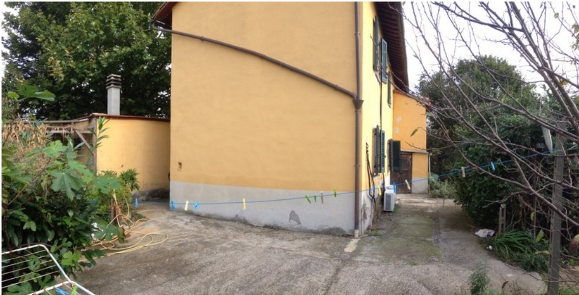
Foto 13 – Panoramica edificio A (prospetto laterale)
