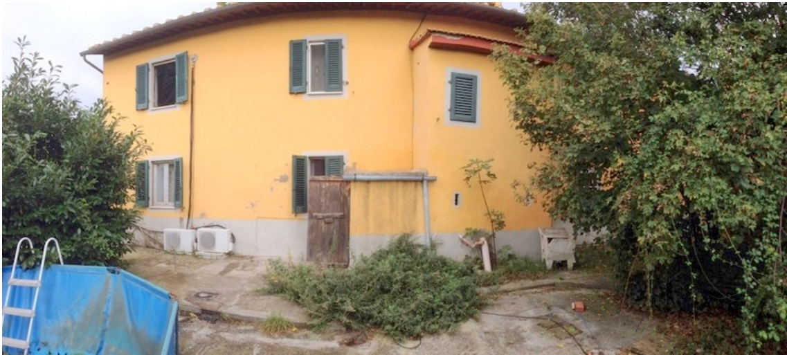
Foto 17 – Panoramica edificio A (prospetto tergale)
