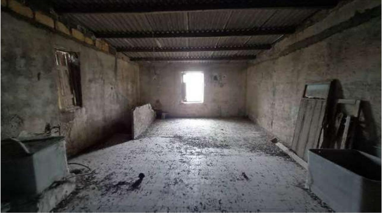
**FOTO 15 – Mansarda (1) terzo piano, copertura in cemento-amianto**
