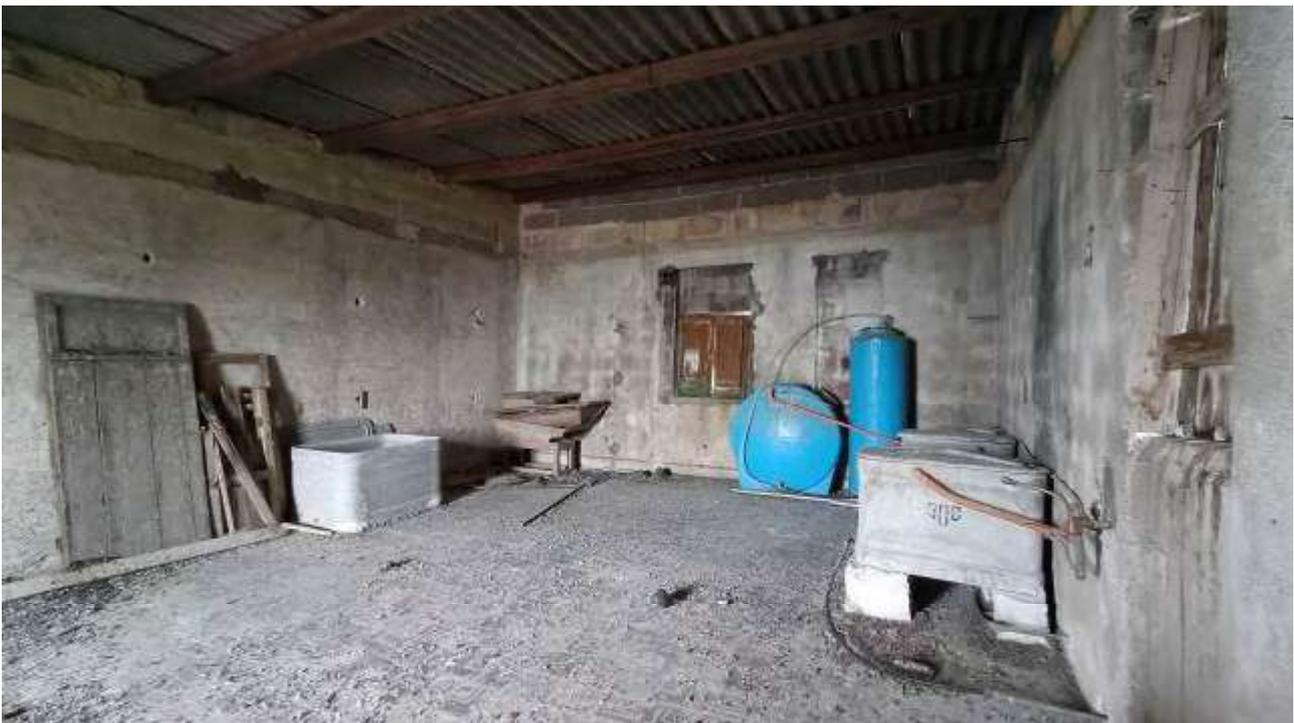
**FOTO 14 – Mansarda (1) terzo piano, riserva idrica in cemento-amianto**
