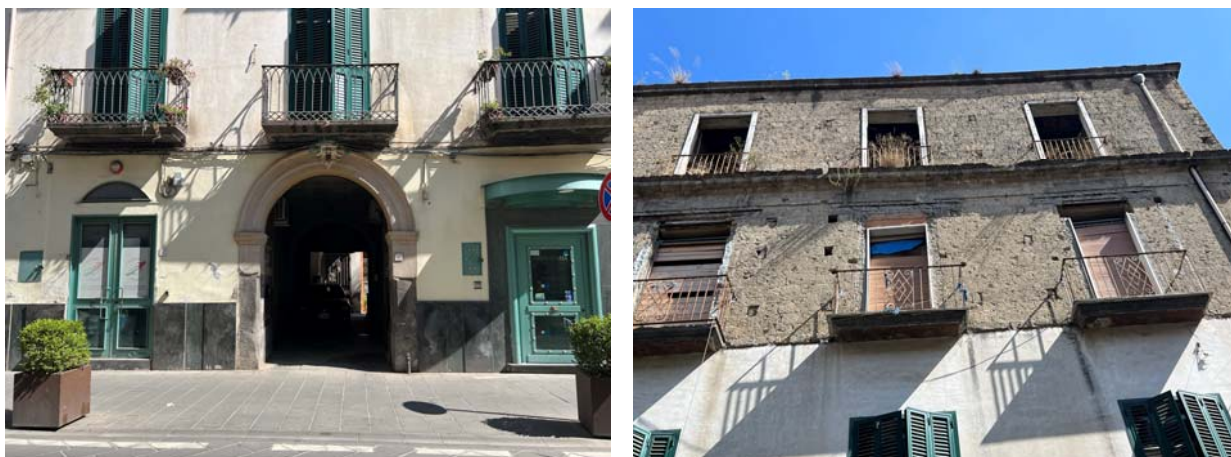
Vista dei piani terra e primo, a sinistra, e secondo e terzo, a destra
