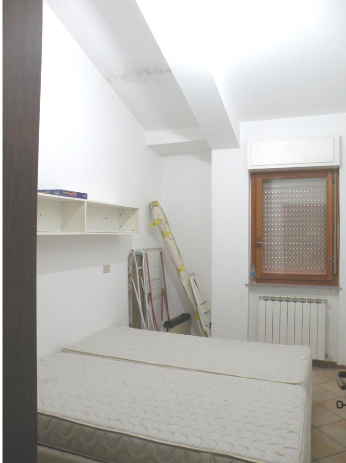
FOTO N°16: Vista interna dell'appartamento al piano secondo, letto 2/1.
