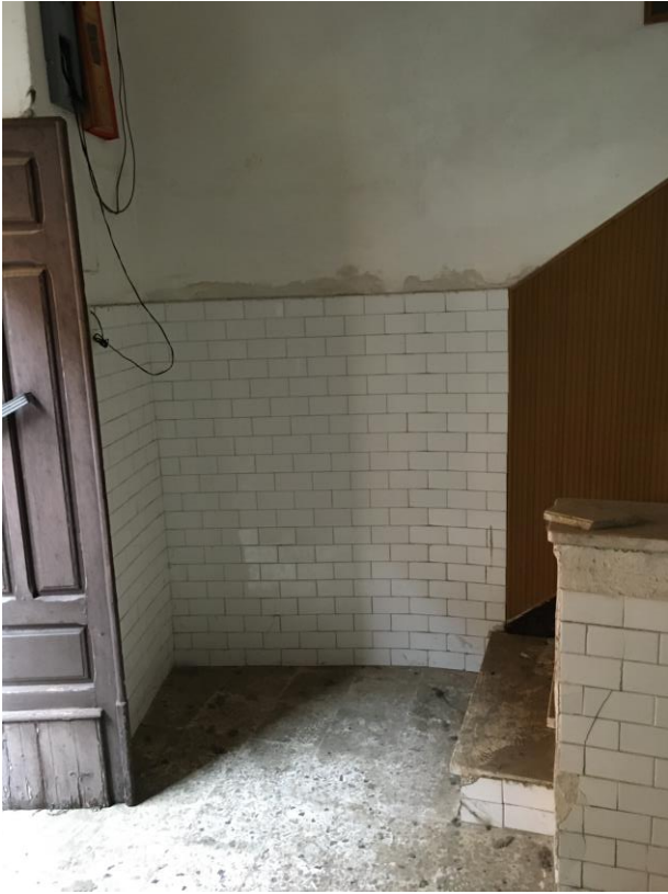
1. Piano Terra – Ingresso e scala.
