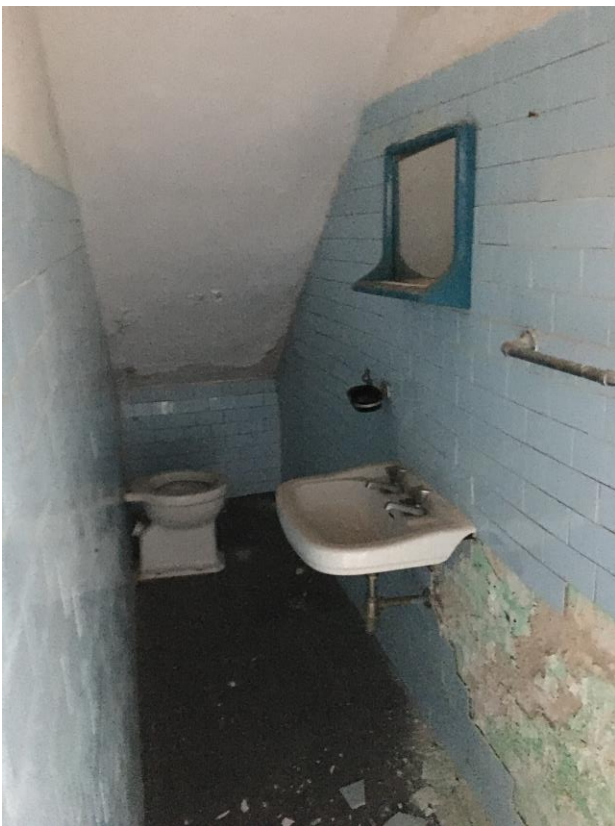
4. Piano terra – Servizio igienico sottoscala
