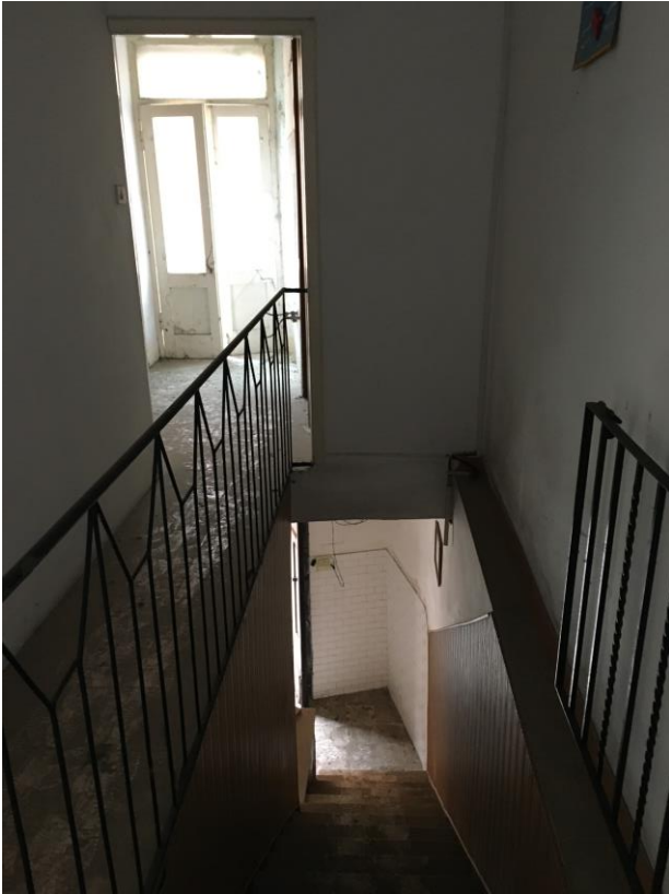
5. Pianerottolo e rampa di scale.
