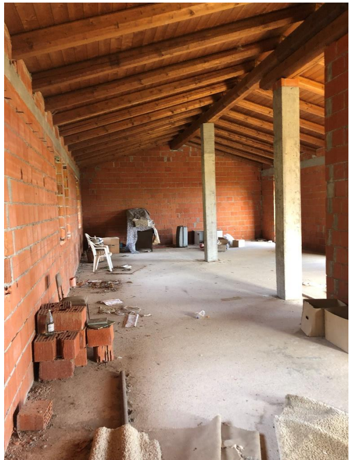
VISTA INTERNO PIANO PRIMO
