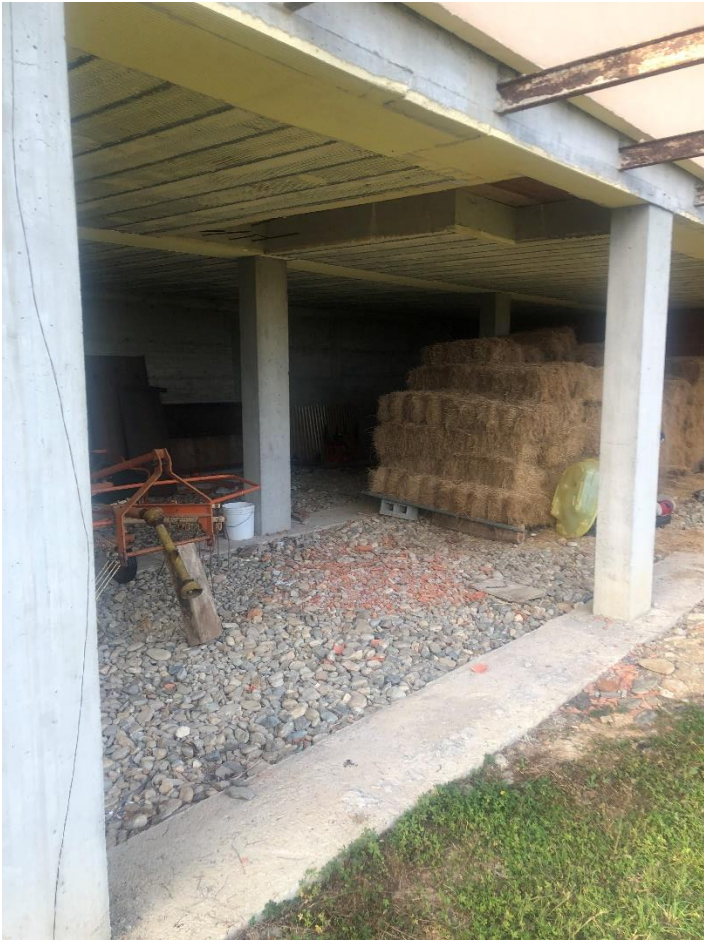
VISTA INTERNO PIANO TERRENO
