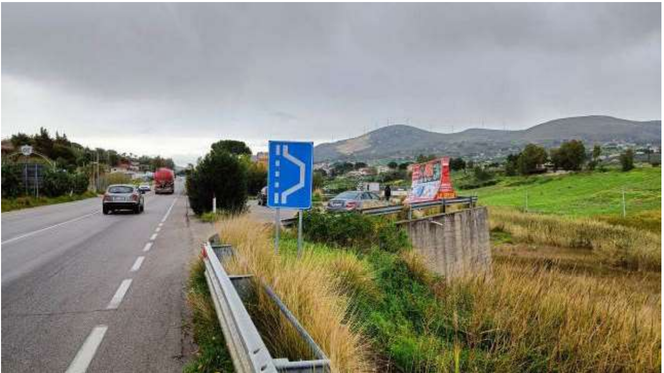
FOTO 1 – Area di sosta sulla SS 121 in direzione Agrigento
