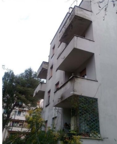
FOTO 4 - PROSPETTO LATERALE LATO DESTRO
