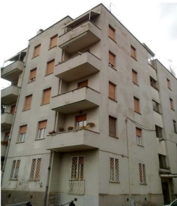
FOTO 3 - PROSPETTO LATERALE LATO SINISTRO
