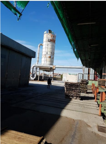
Silos (Edificio E)
