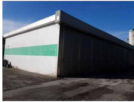
Edificio F – vista del Silos edificio E
