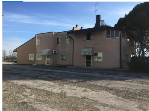
Lato ovest interno area
