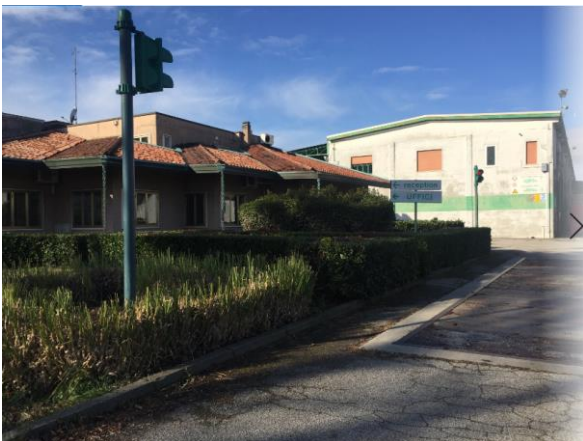
Lato nord interno area
