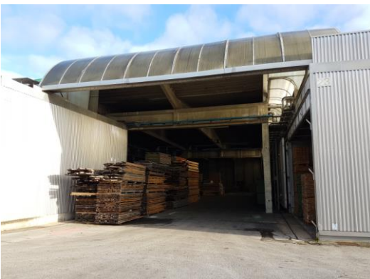
Pensilina edificio A lato sud
