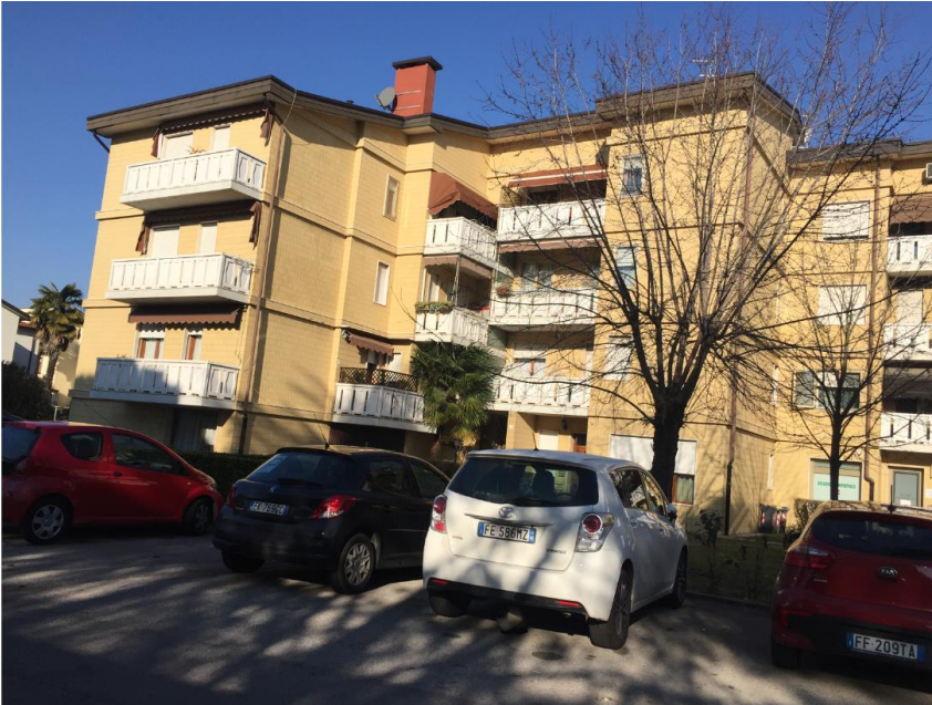
Fronte principale a sud
