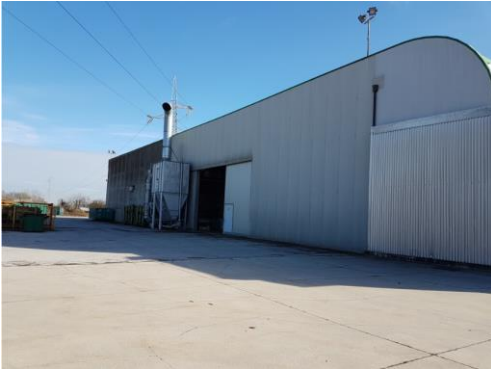
Lato Ovest edificio A
