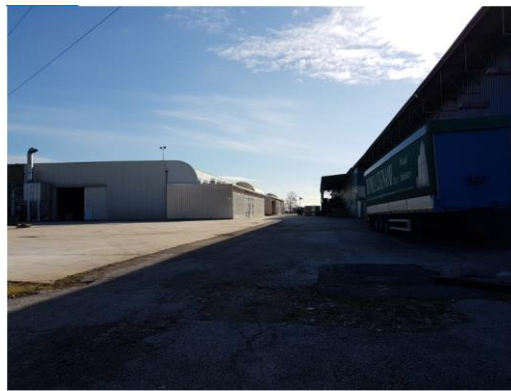
Edifici A e C (da ovest)
