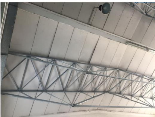
Particolare della copertura
