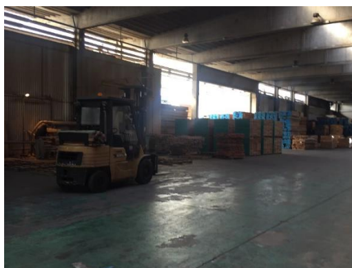
Interno edificio A lato sud
