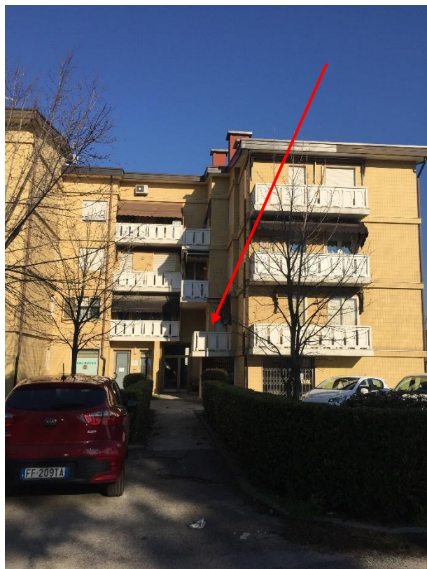
Fronte sud angolo est – Terrazzino in difformità
