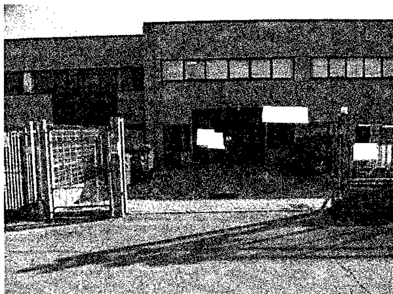
FOTO 4 – Vista della zona di ingresso principale
