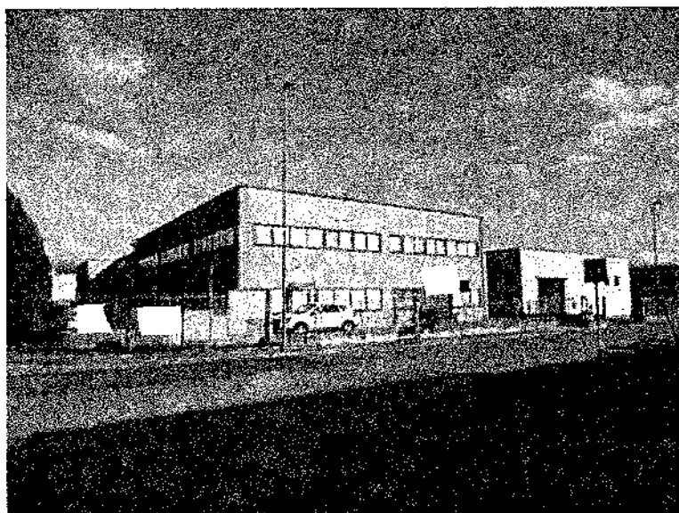
FOTO 2 – Vista da via Pian della Fonda
