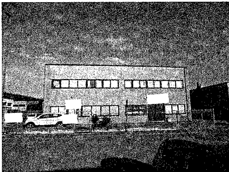
FOTO 1 – Vista prospetto laterale su via Pian della Fonda
