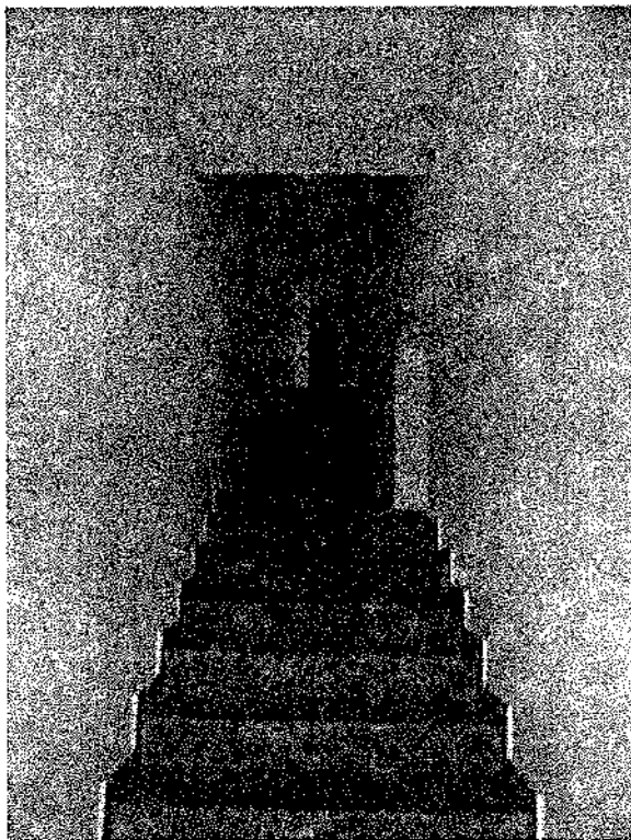
FOTO 7 – Vista vano scale comune
