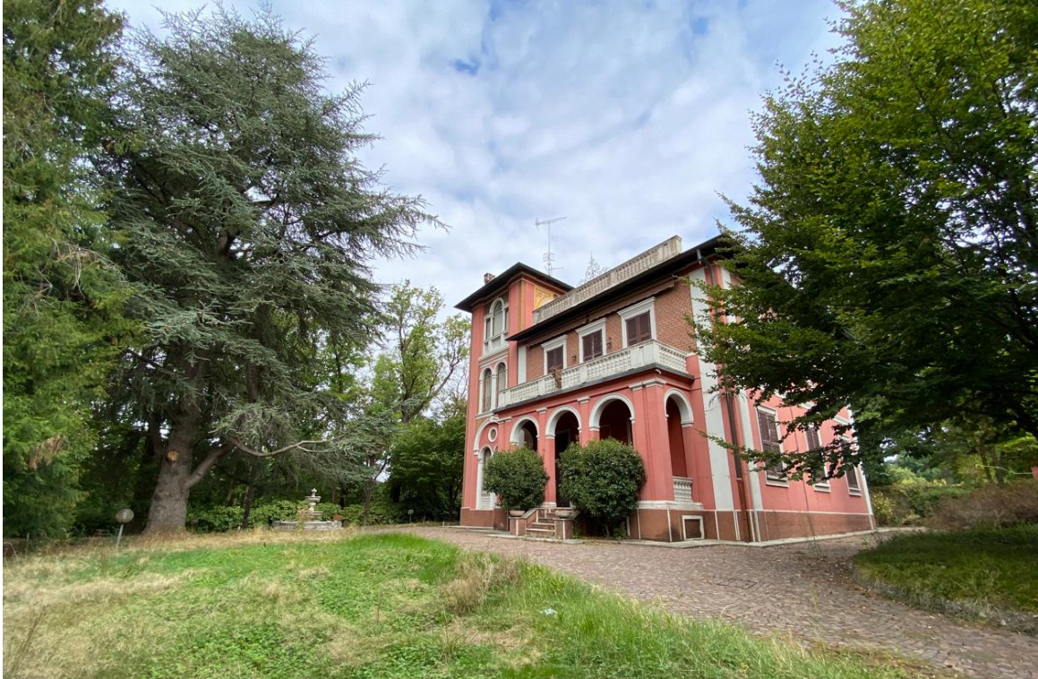
2. Villa vista da sud
