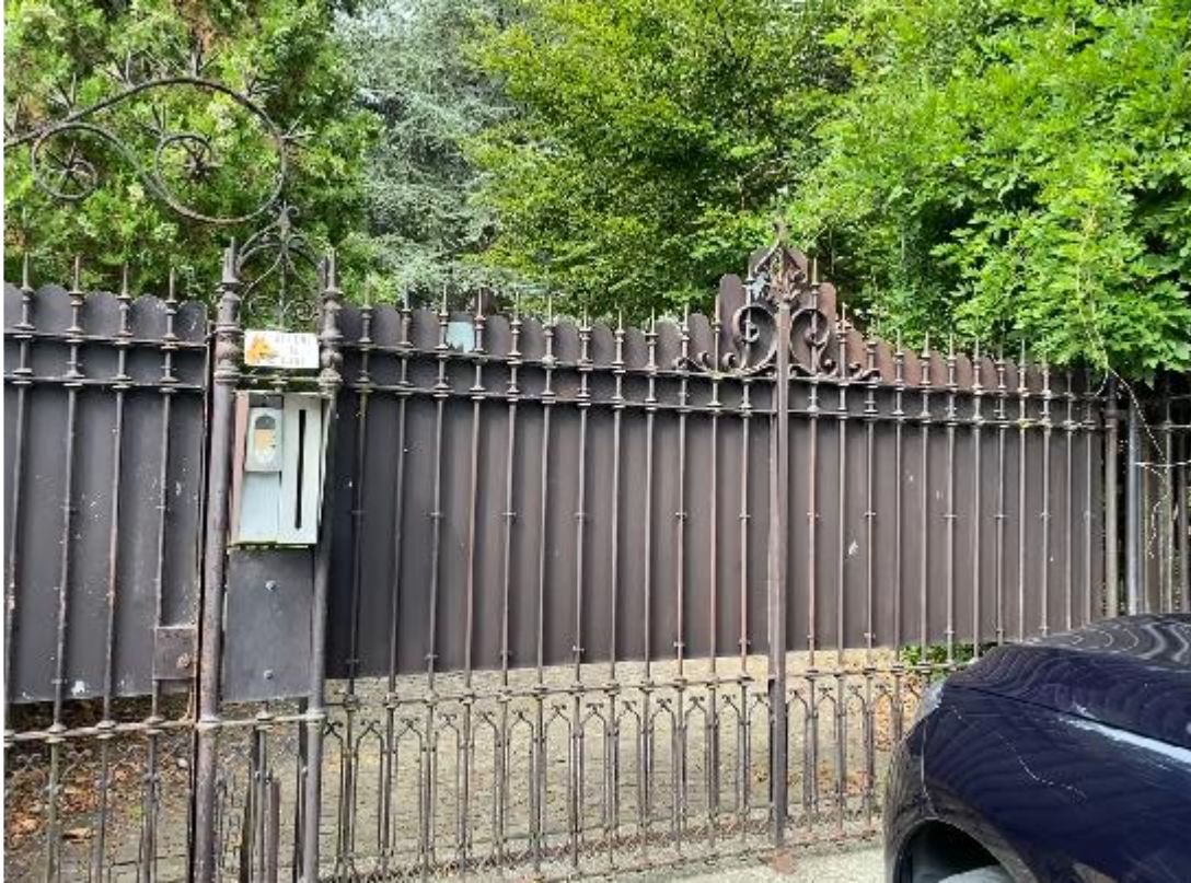
20. ingresso pedonale e carroia
