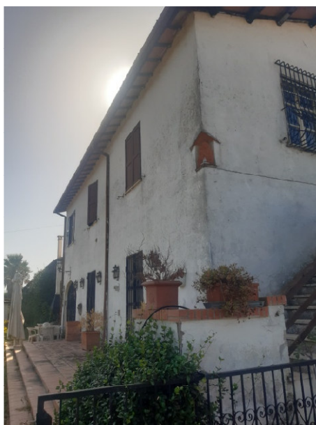
Foto esterne dell'abitazione
