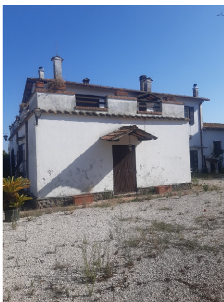
Foto esterne dell'abitazione
