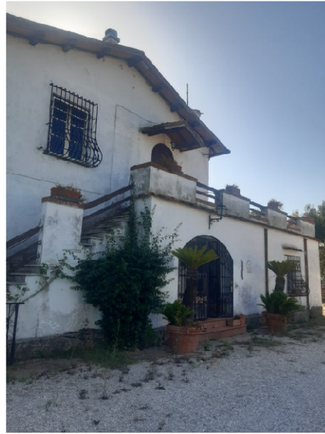
Foto esterne dell'abitazione
