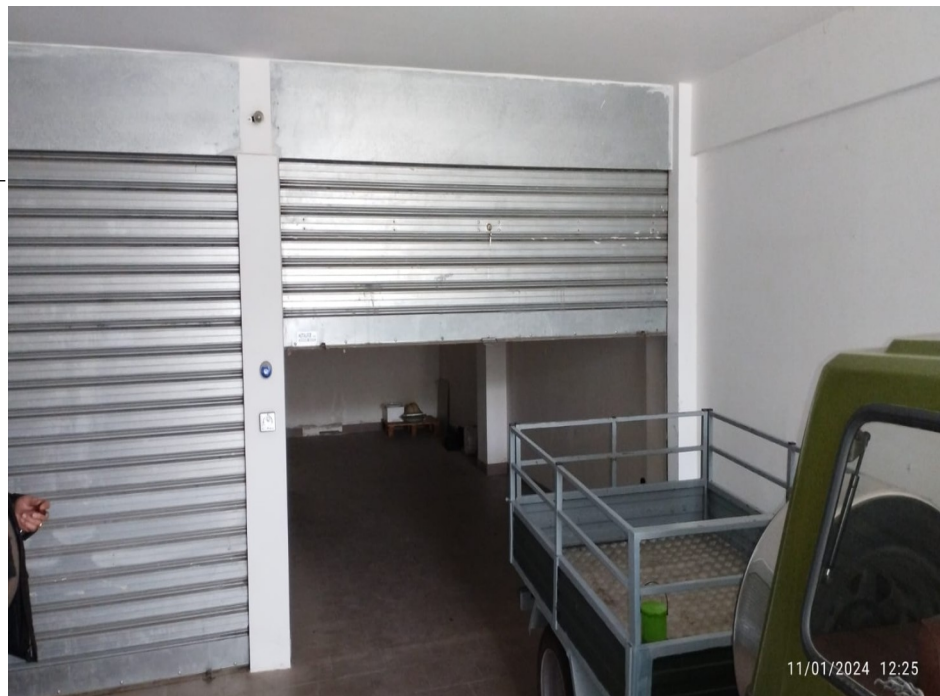
Box seminterrato accesso da rampa carrabile da via Gronchi
