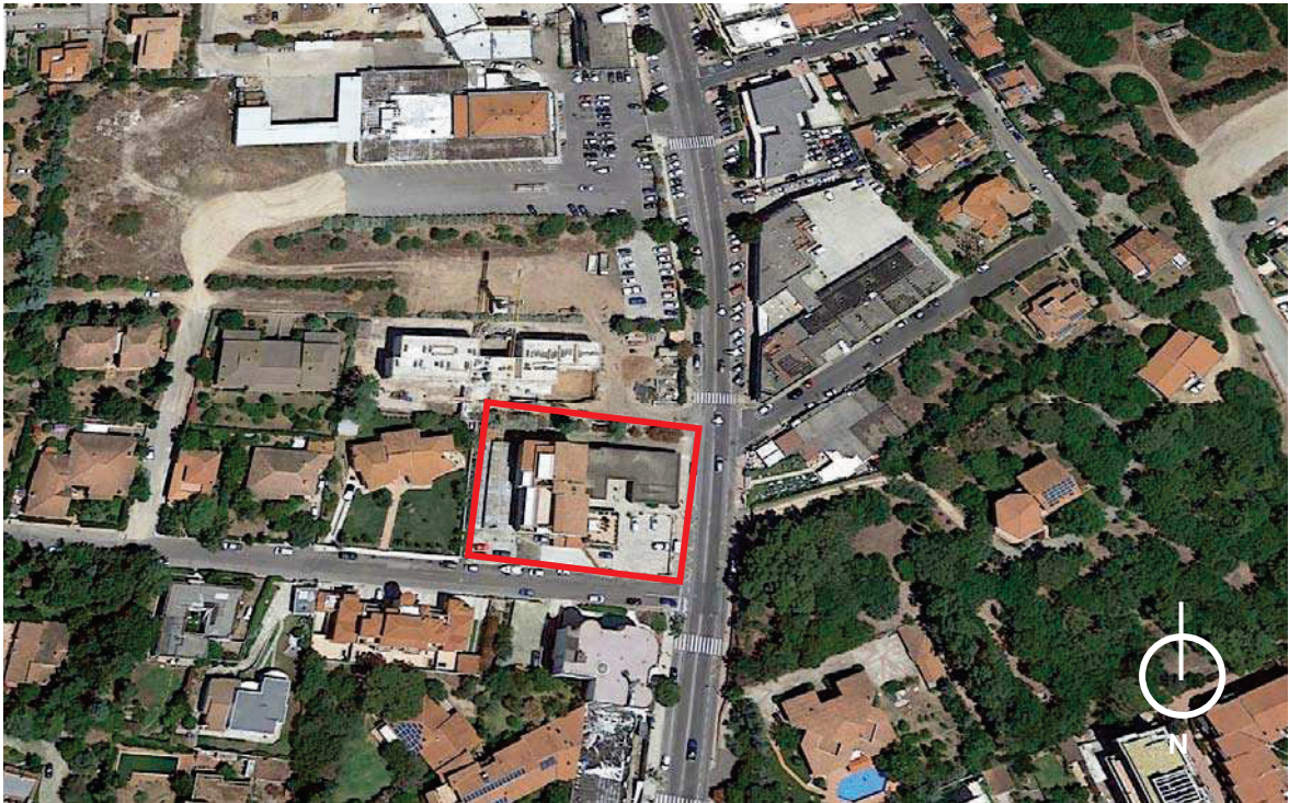
Aerofoto di Olbia con individuazione del condominio di cui fa parte l'immobile oggetto di perizia.
