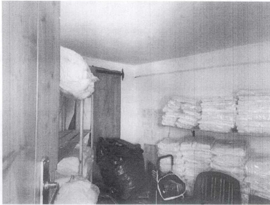
IMMAGINE 10: Volume edilizio aggiunto (interno)
