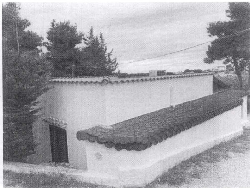
IMMAGINE 11: Volume edilizio aggiunto lateralmente al corpo di fabbrica (esterno)
