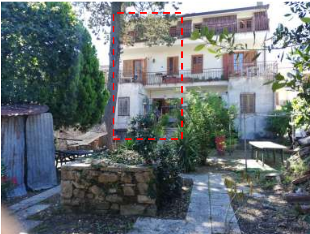
Foto 2: ... Vista del fronte Posteriore
