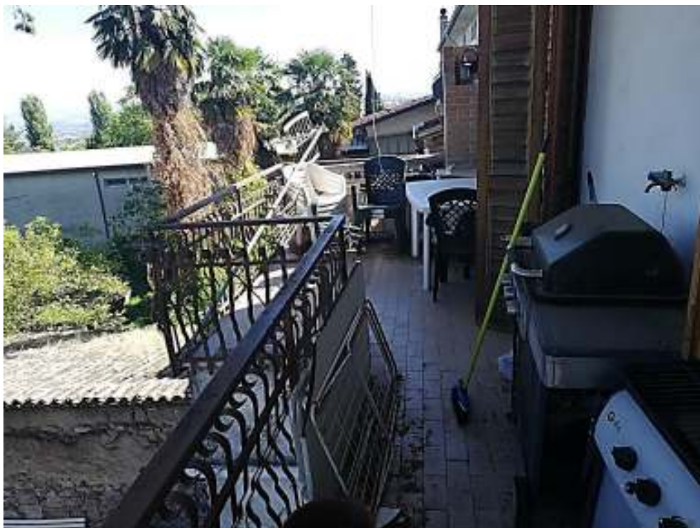
Foto 16: ... Terrazzino al Primo Piano, lato posteriore
