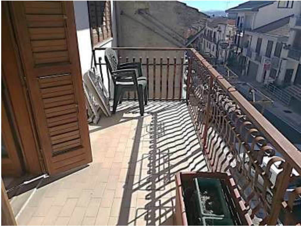
Foto 15: .. Balconi del Primo Piano, lato anteriore
