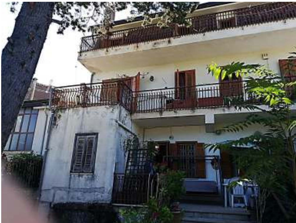
Foto 18: .. Terrazzino al Piano Rialzato – accesso all’area giardino ...
