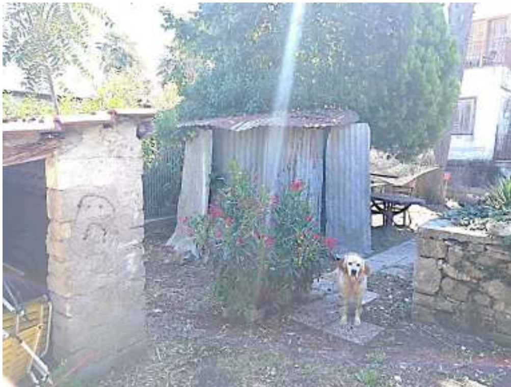
Foto 20: ... Manufatti precari sull'area giardino ...
