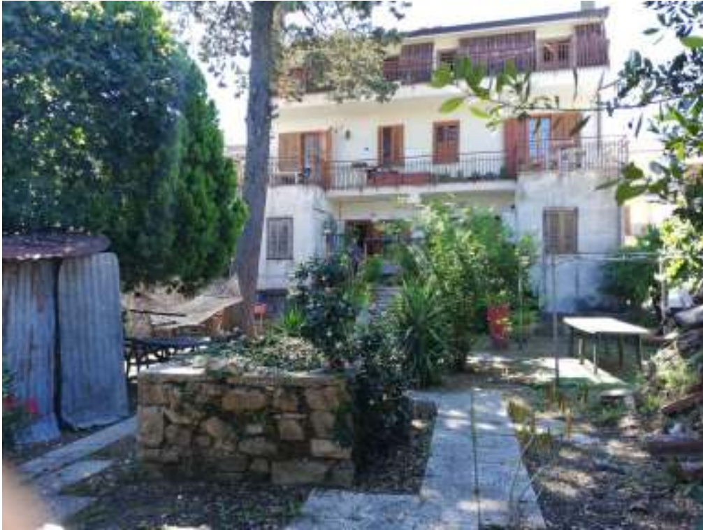
Foto 21: ... Pozzo comune anche all'unità attigua, non oggetto di procedura. ...
