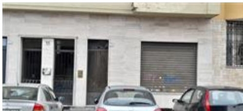
vista su strada
