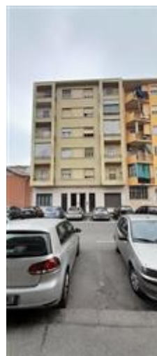
Vista su strada condominio Via Somalia 35
