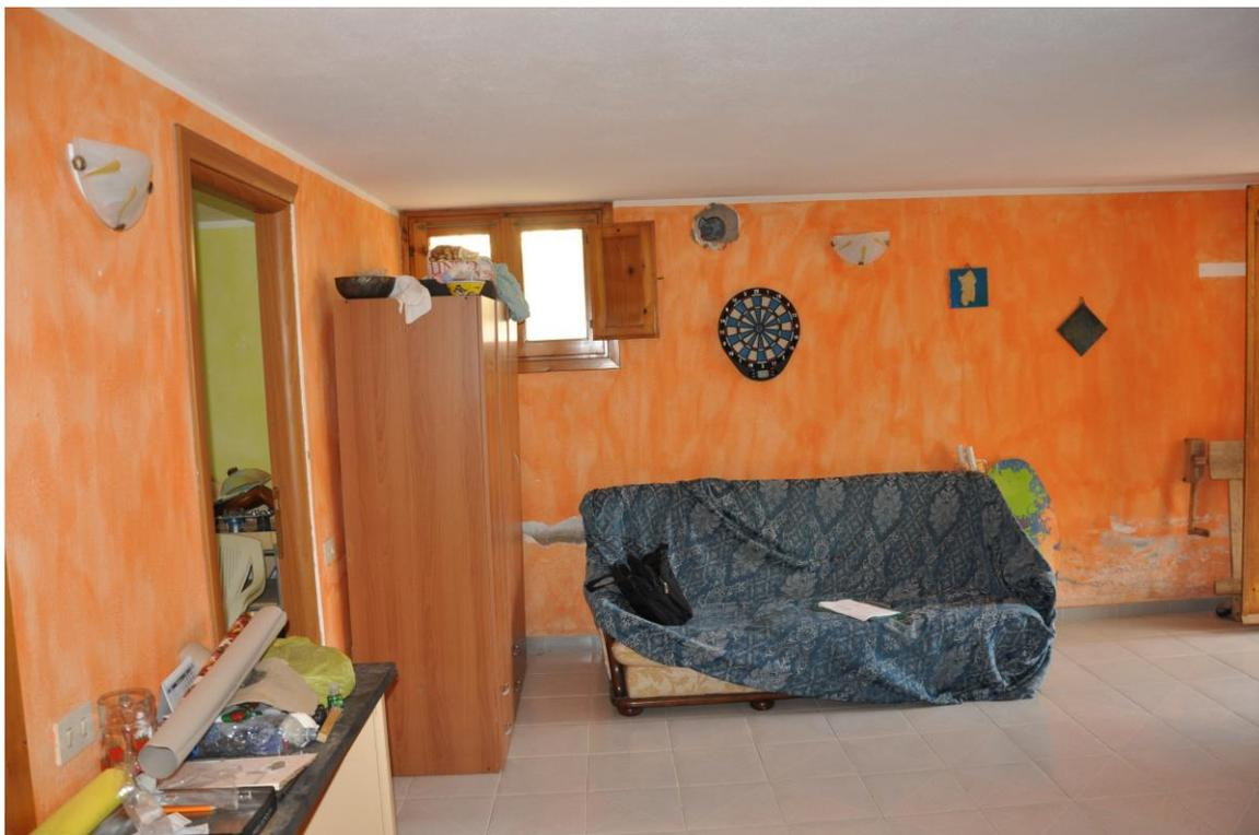
Foto interna del magazzino 1 con evidenti segni di umidità nella parte inferiore della parete
